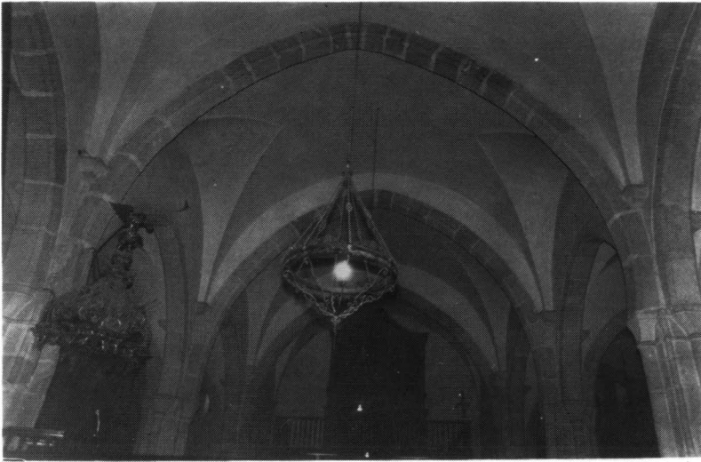
Aspecto general de la nave central.
