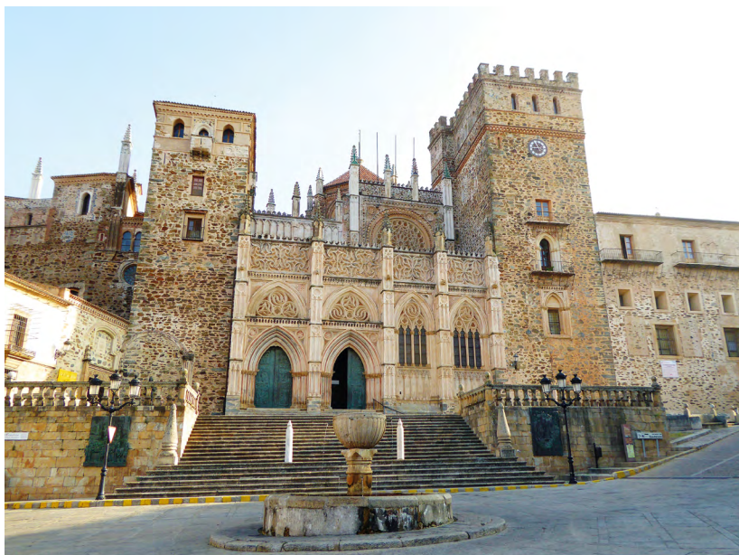
Fig. 1. Guadalupe. Fachada de la iglesia del Real Monasterio de Santa María de Guadalupe. Foto: Pilar Mogollón Cano-Cortés.
