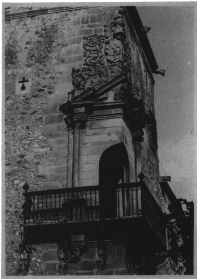
CÁCERES. Balcón de esquina del palacio de Godoy.
