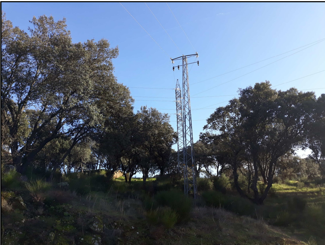
Imagen 4 : Líneas eléctricas presentes en la zona de actuación.
