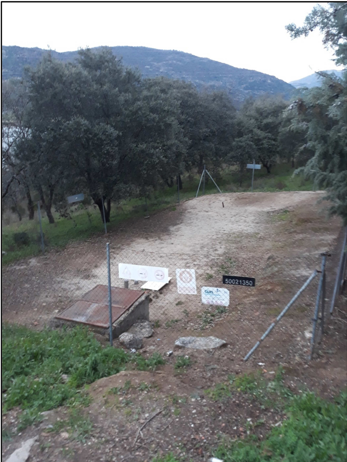
Imagen 5: Depósito de almacenamiento de gas de la urbanización.
