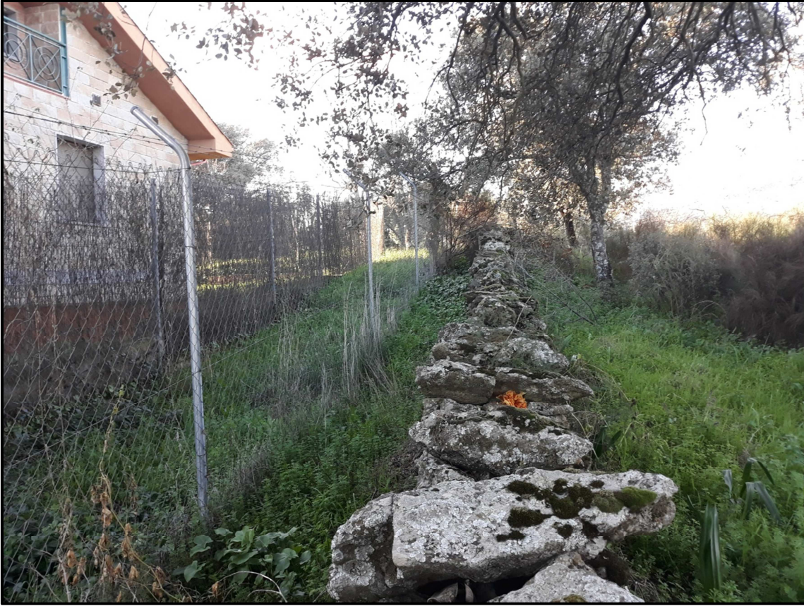
Imagen 6: Vallado perimetral en la zona del Cordel de Nava Cebrera.
