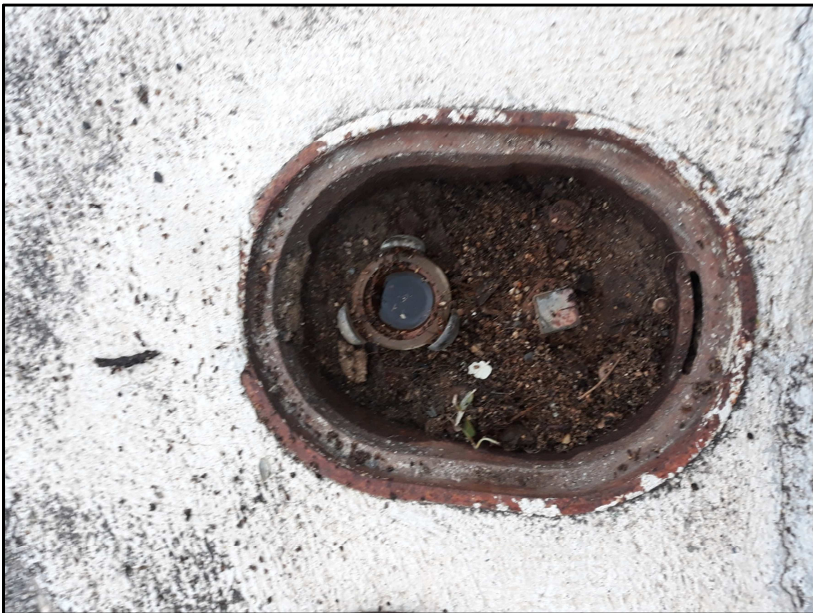
Imagen 2: Hidrante de suelo con racor Tipo Barcelona \varnothing 45 mm.
