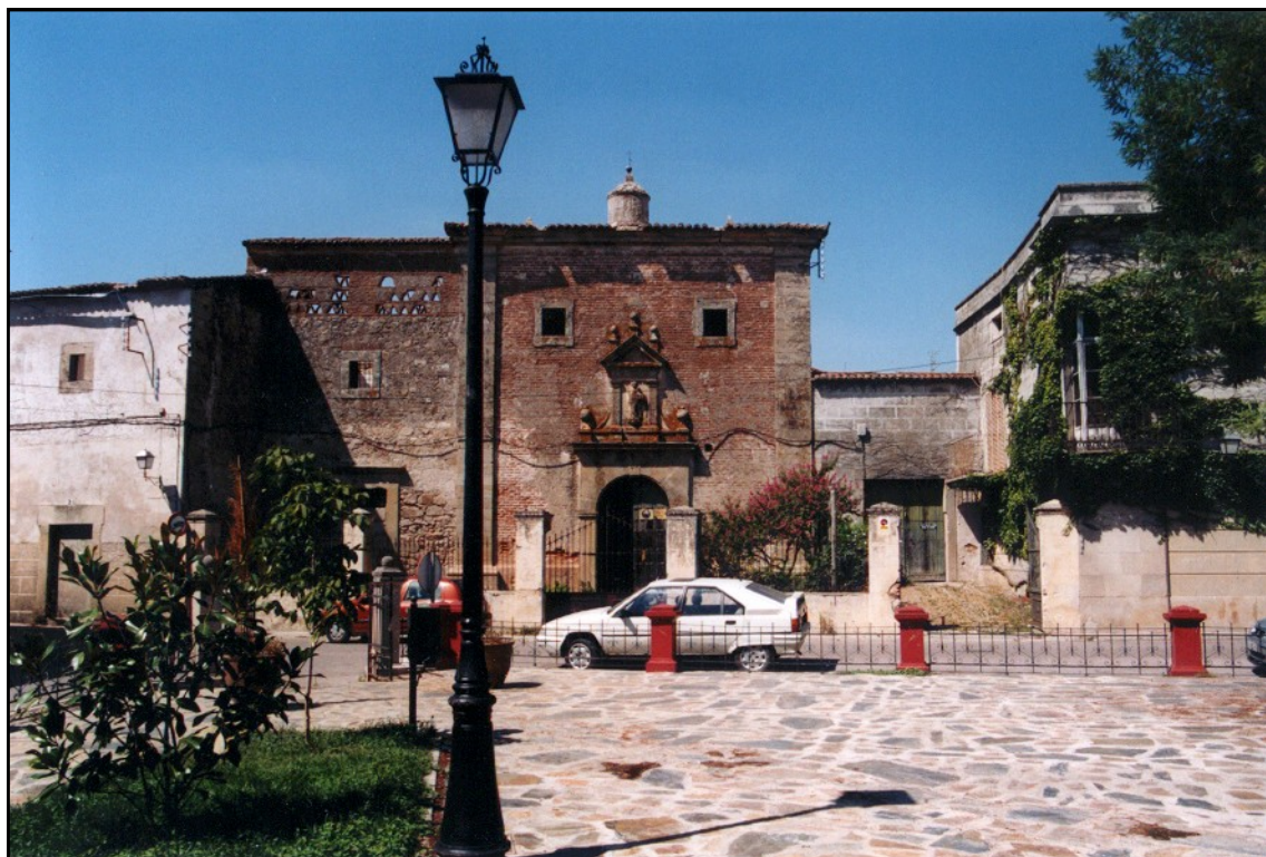
Imagen 6: Fachada antes de las obras.
