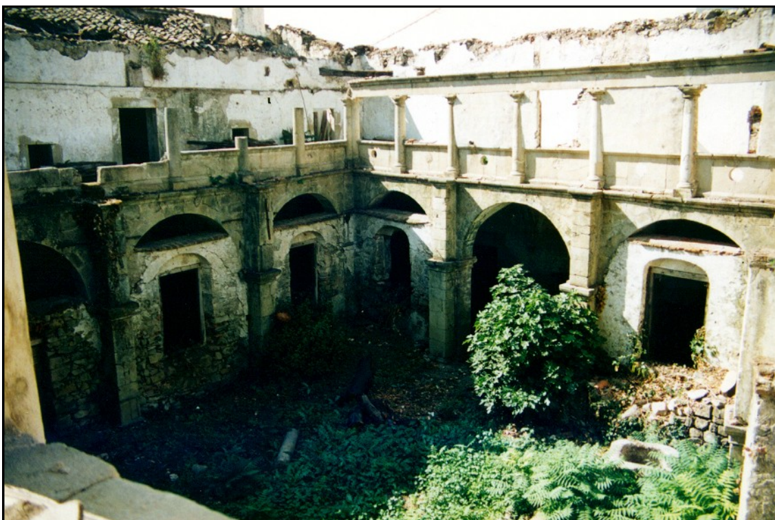
Imagen 23: Vista general del Claustro antes de las obras.
