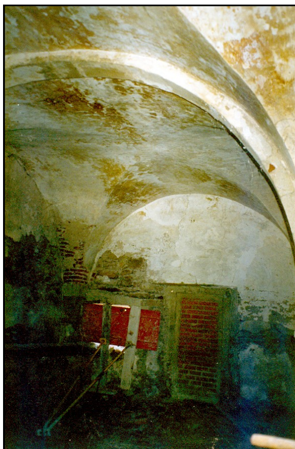
Imagen 28: El Salón antes de las obras.
