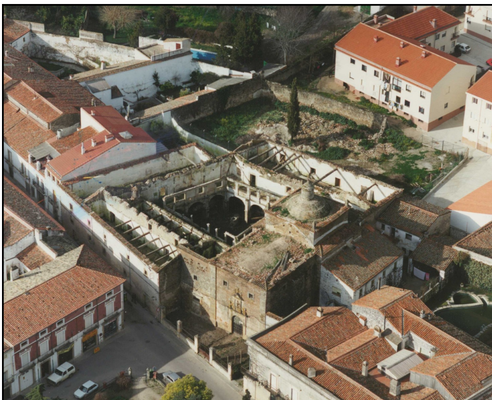
Imagen 1: Vista aérea del Convento antes de las obras, 1995.
