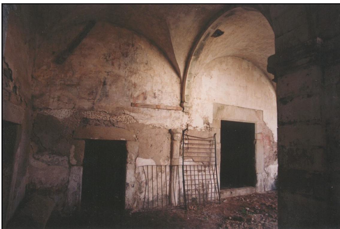
Imagen 22: El Claustro antes de las obras.
