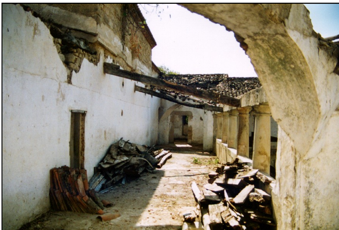
Imagen 25: Detalle del Claustro antes de las obras.
