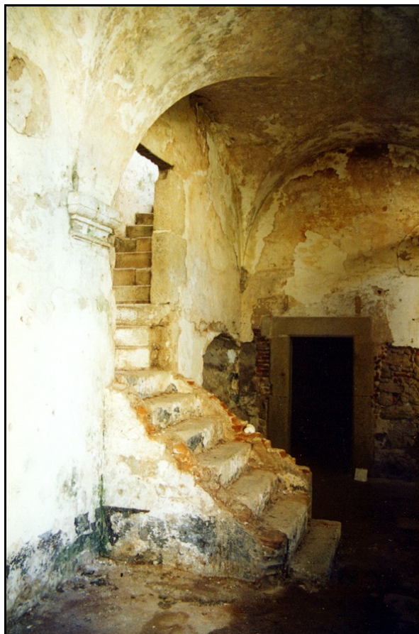
Imagen 20: Galería del Claustro antes de las obras.
