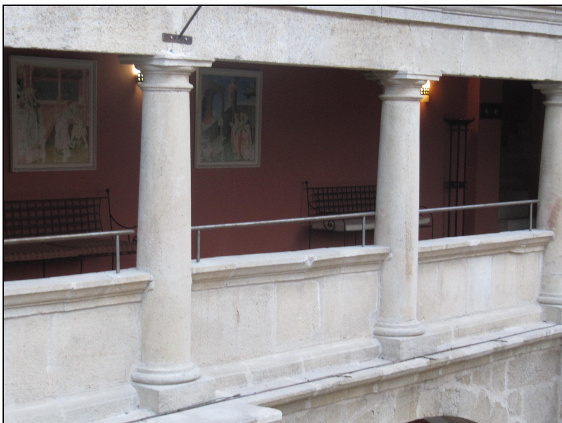
Imagen 40: Detalle de las columnas del Claustro.
