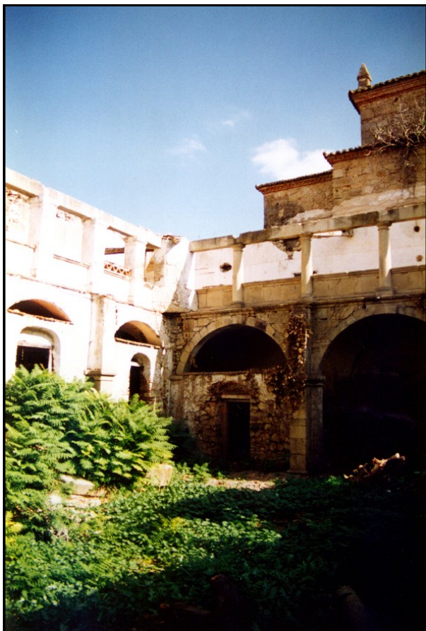
Imagen 19: Detalle del Claustro antes de las obras.
