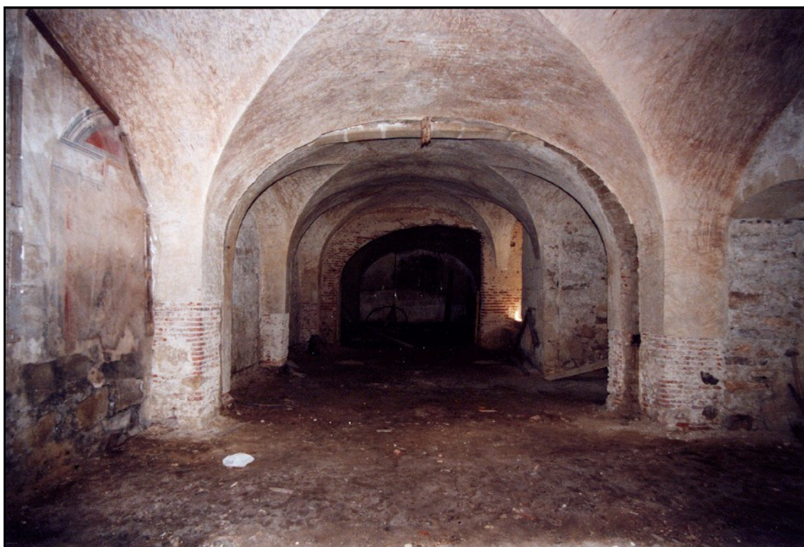
Imagen 27: El Salón antes de las obras.
