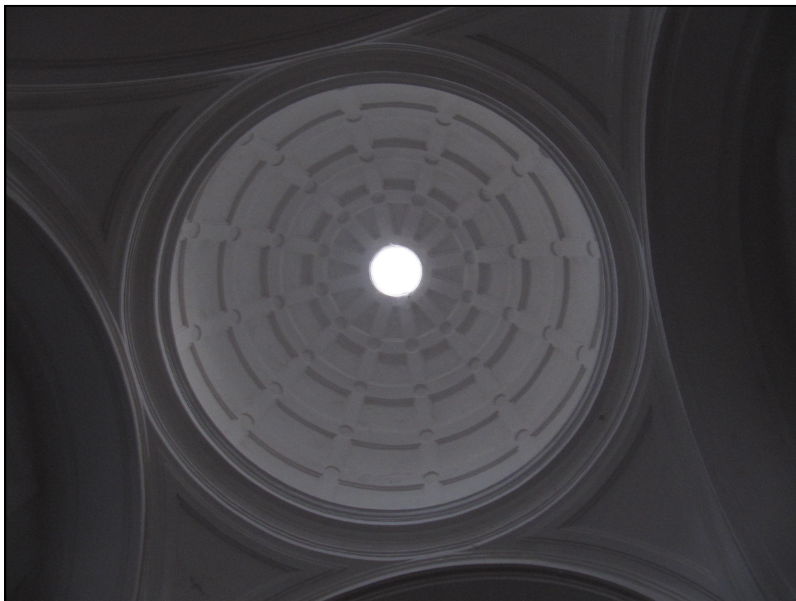
Imagen 43: Detalle de la Cúpula.
