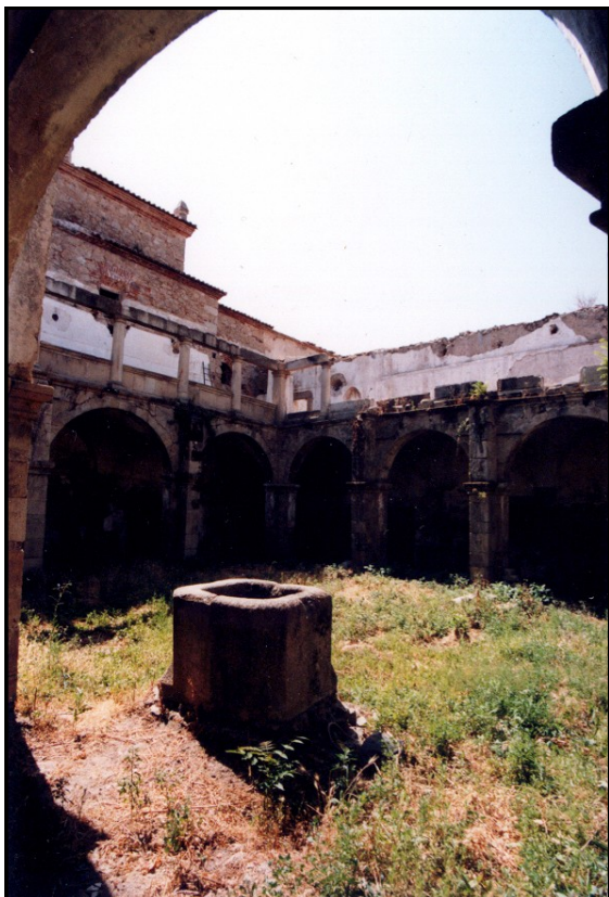
Imagen 16: El Claustro antes de las obras.
