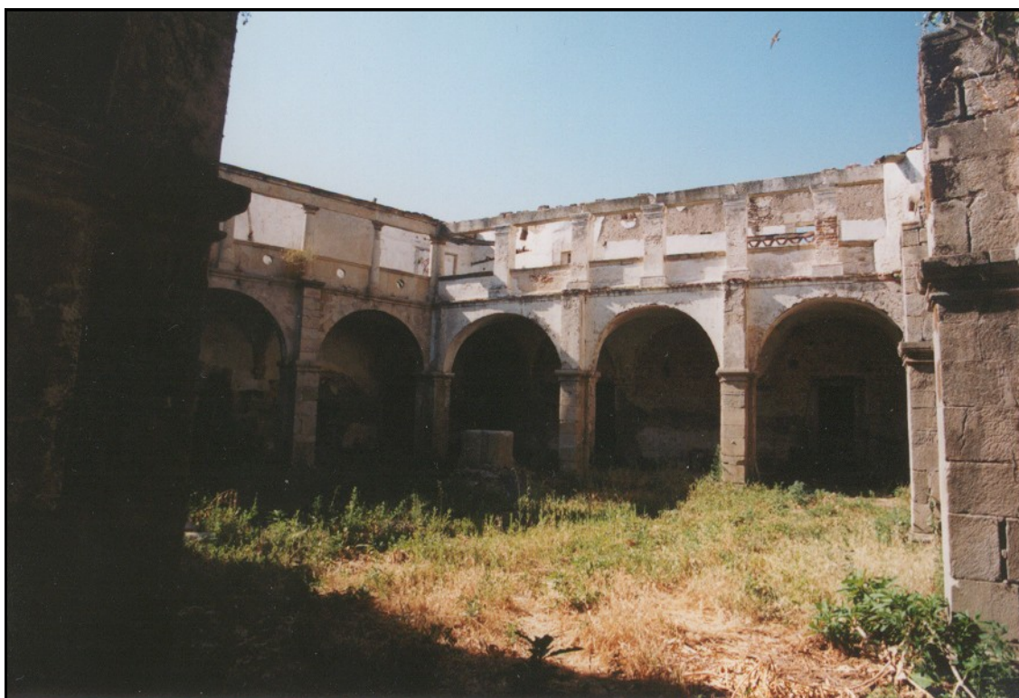
Imagen 18: El Claustro antes de las obras.
