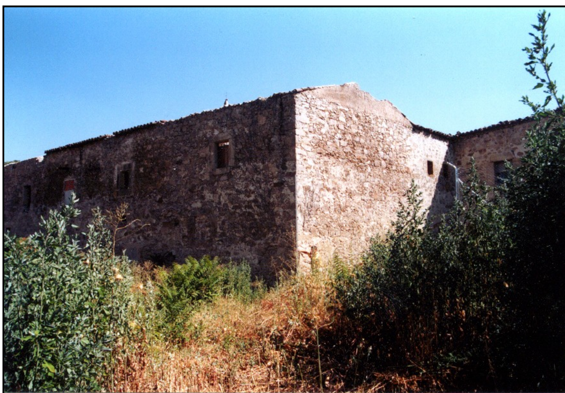
Imagen 4: Exteriores antes de las obras.
