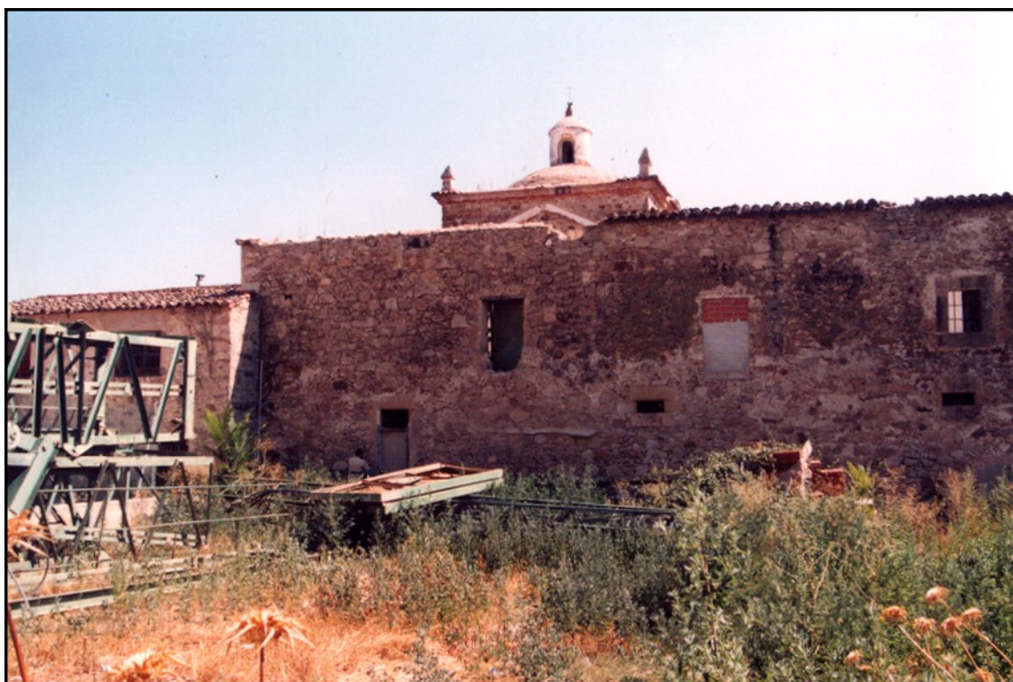
Imagen 3: Exteriores antes de las obras.
