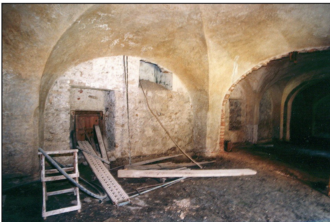
Imagen 26: El Salón antes de las obras.
