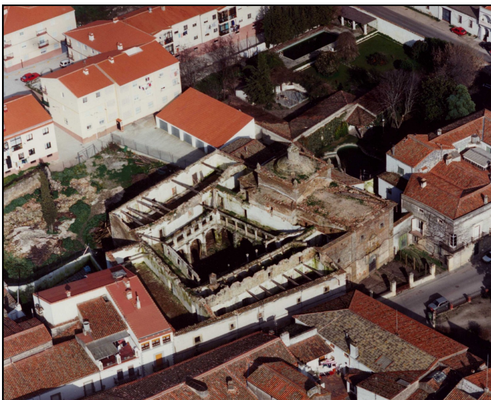
Imagen 2: Vista aérea del Convento antes de las obras, 1995.
