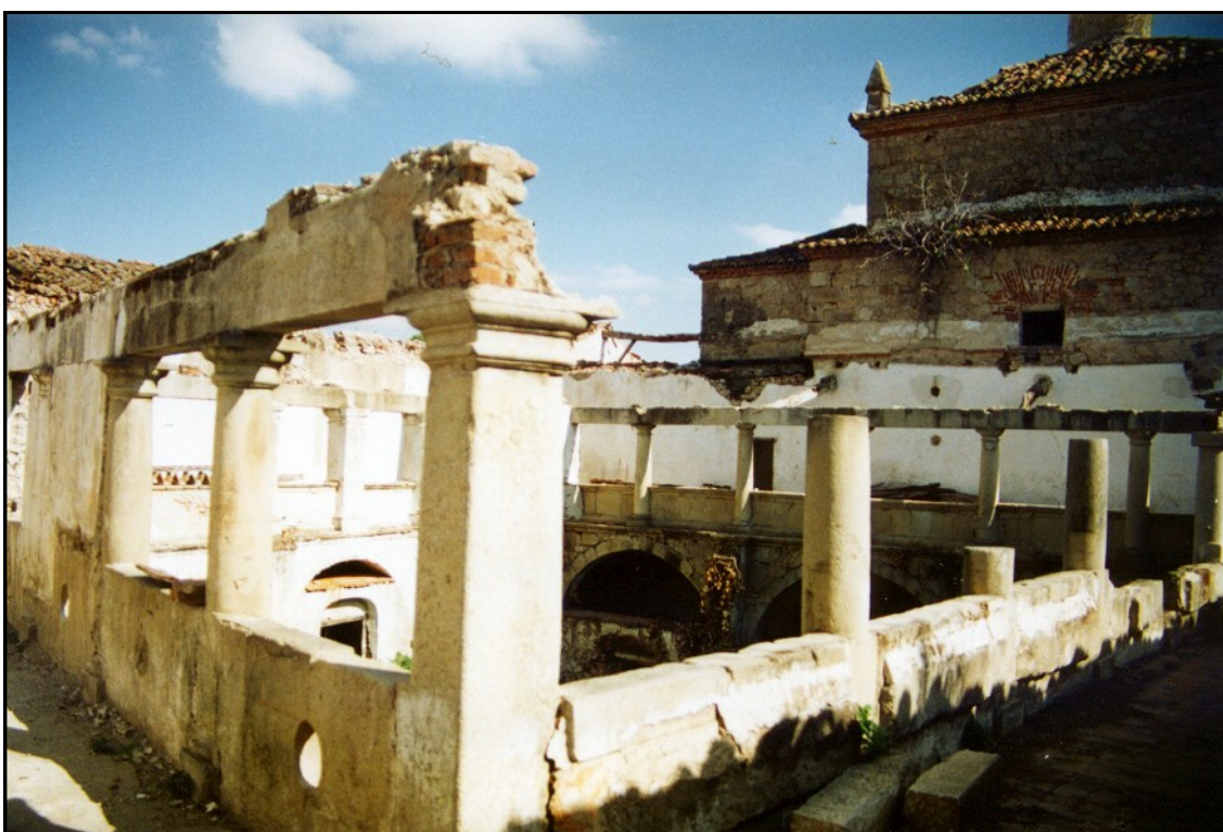
Imagen 24: El Claustro antes de las obras.
