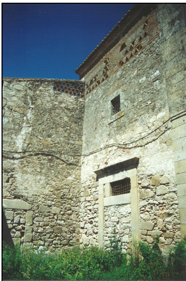
Imagen 5: Detalle de la fachada antes de las obras.
