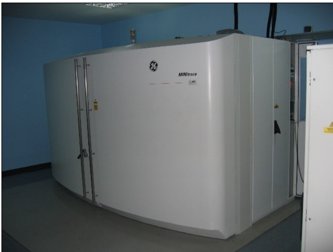
Figura 3.2. Ciclotrón Minitrace de GE instalado en el CHUB.
