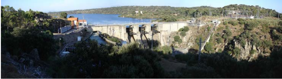
Figura 1. Panorámica de la Presa de Valdeobispo. Fuente: http://www.valdeobispo.net/Presa/Panoramica1.html
