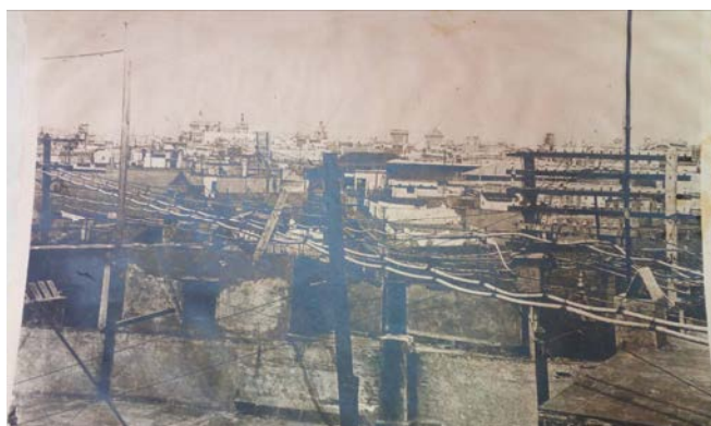
Figura 1. Estado de distribución de una red de cableados y postes, con un aspecto caótico y poco estético (Fotografía: AHMCC).
