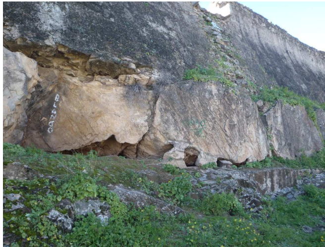
Fig. 5. Marcas de barrenos en el foso
