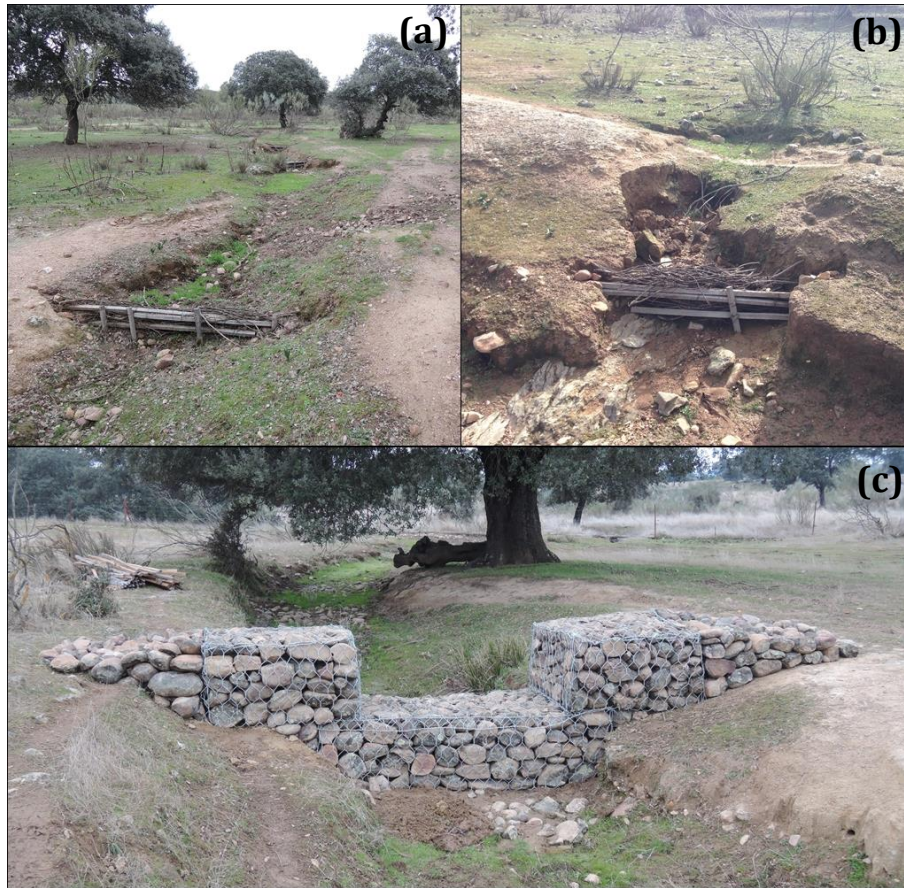
Figura 6. Ejemplos de medidas de corrección y control de cárcavas implementadas en una cuenca de dehesa en Extremadura: (a) una fajina hecha con escobas e implementada perpendicular a la cárcava, (b) una fajina instalada en una cabecera lateral y (c) un gabi6n formado por cantos y bloques de cuarcita y construido perpendicular a la cárcava.
