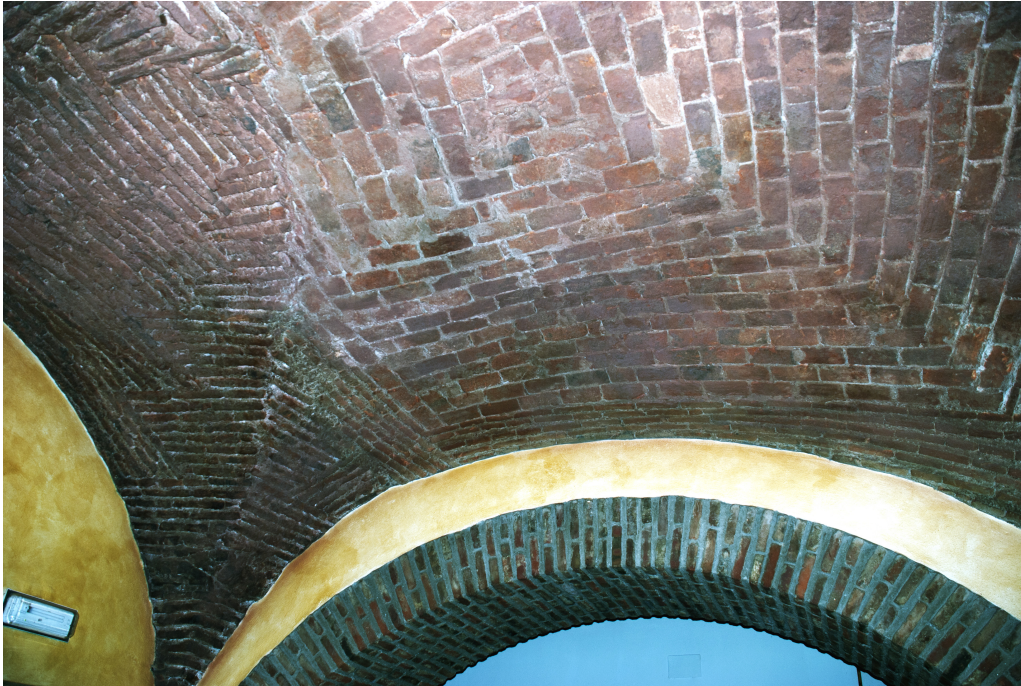
Figura F.8: Reconstrucción de una bóveda de rosca con fábrica a panderete. En c/ Francisco Pizarro nº 18, Navas del Madroño (Cáceres).
