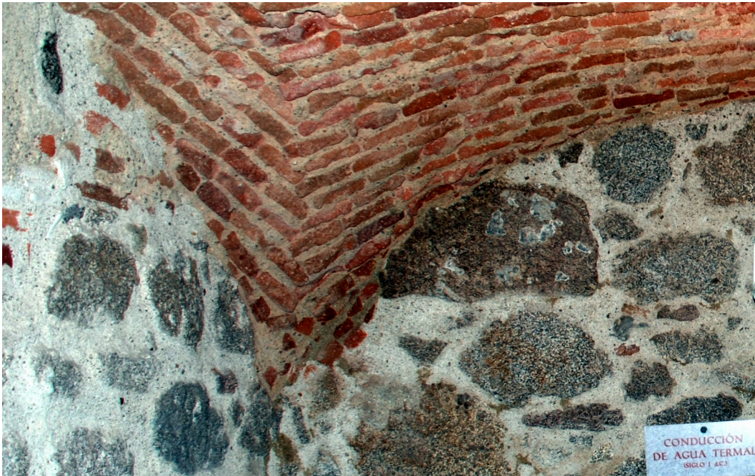
Figura F.6: Arranque de bóveda con fábrica en forma de hoja de palmera. En avd. Las Termas. Baños de Montemayor (Cáceres).
