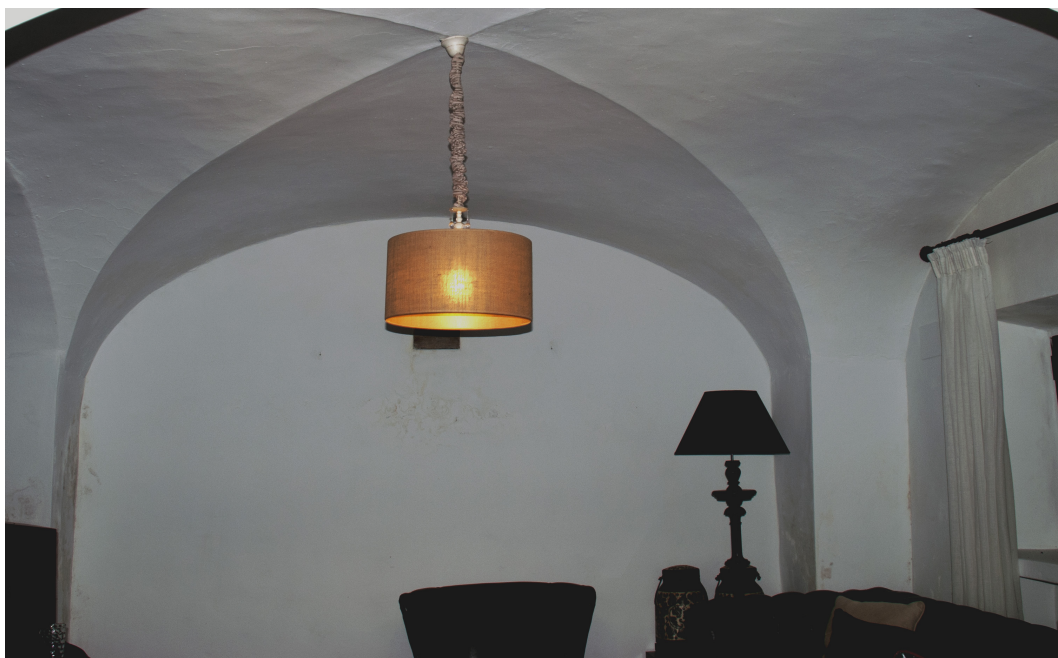
Figura F.5: Arranques de bóveda Extremeña sobre pilastras. En Viñas de la Mata (T. M. de Cáceres).
