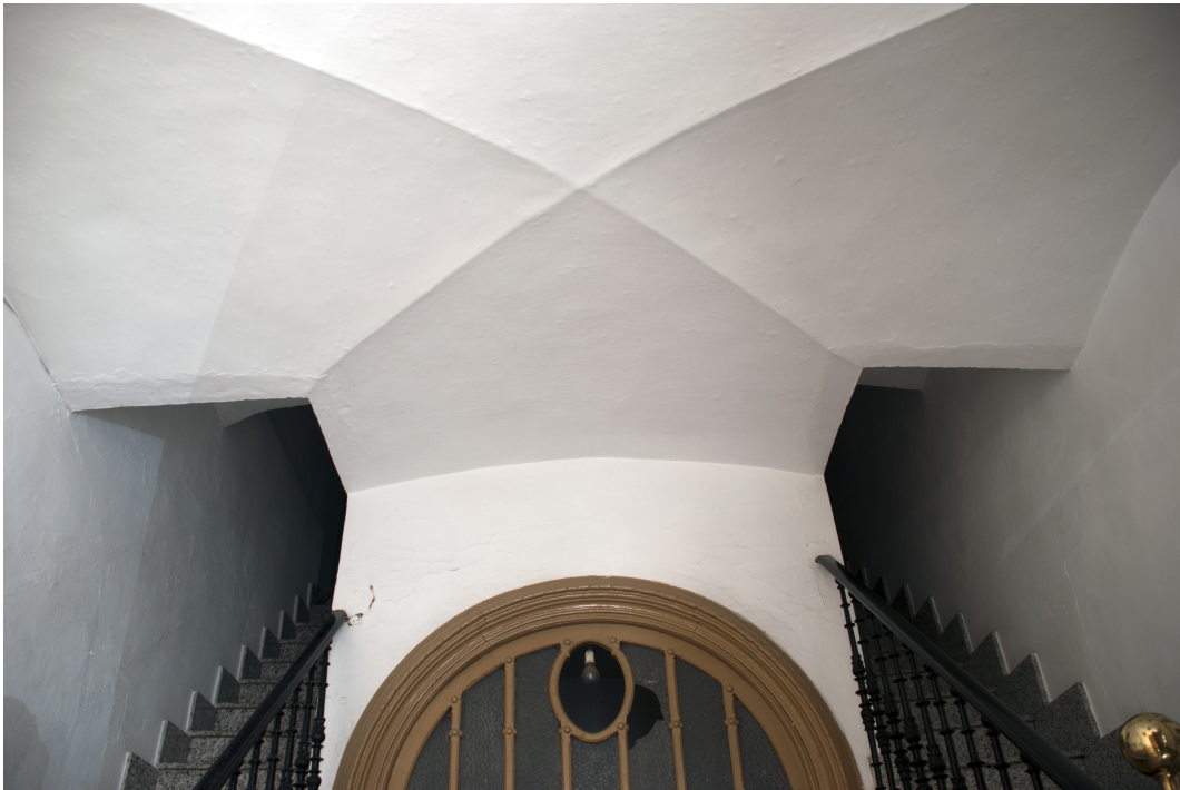
Figura F.10: Bóveda Extremeña. Situación en que los esfuerzos de la bóveda se dirigen hacia los muros de apoyo y no hacia las aristas diagonales. En Plaza de España, Burguillos del Cerro (Badajoz).
