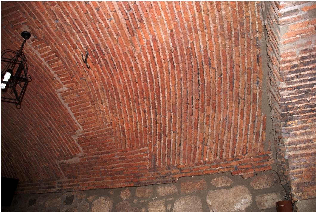
Figura F.1: Bóveda de cañón construida sin cimbrar por hiladas inclinadas. En c/ Coronel Guillén nº 9 de Navas del Madroño (Caceres)
