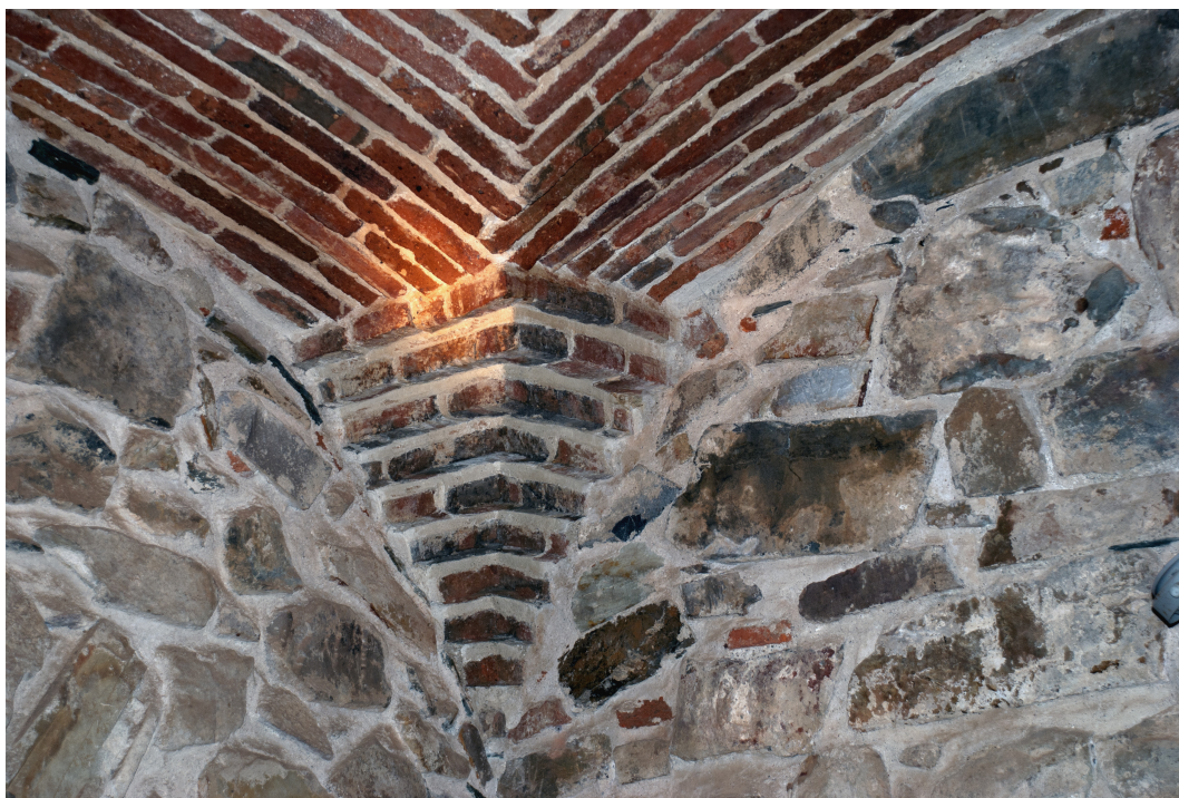
Figura F.4: Arranque de bóveda de rosca sobre pechina. En Torre Bujaco, Plaza Mayor (Cáceres).
