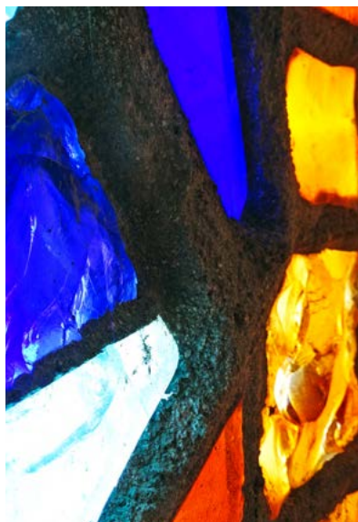
Dallas engarzadas con hormigón armado en Conquista del Guadiana.
