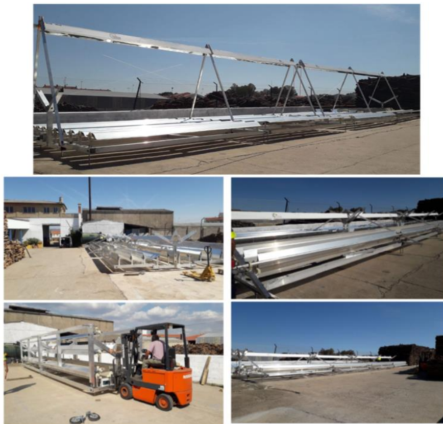
Figura 53. Montaje de colectores lineales Fresnel.
