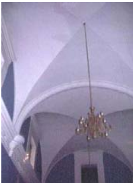
Cubierta original de arista realizaba por Becerra en la sacristía de la catedral de Lima
