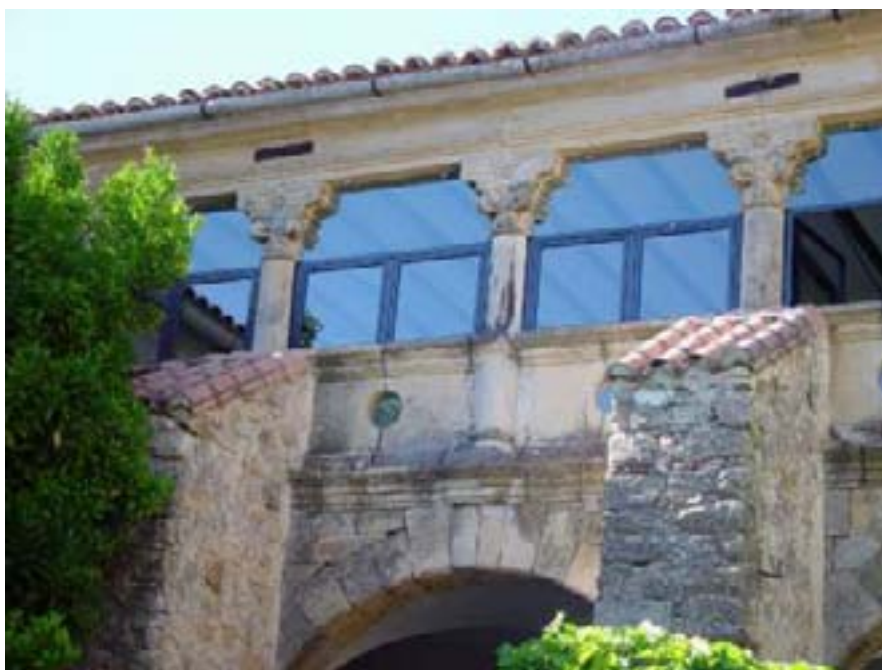
Galería adintelada en la segunda planta con sus contrafuertes
