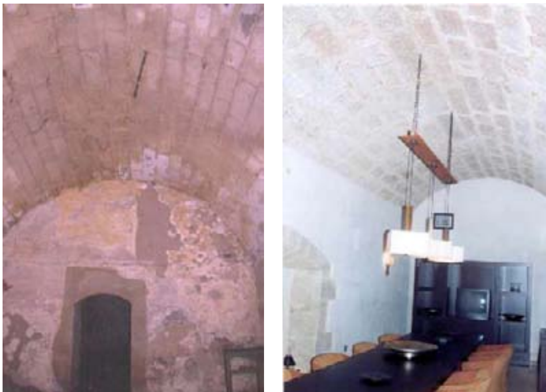
Bóvedas de medio cañón de cantería de las caballerizas antes de la restauración y bóvedas de una estancia de la entreplanta después de restaurar el edificio como hotel
