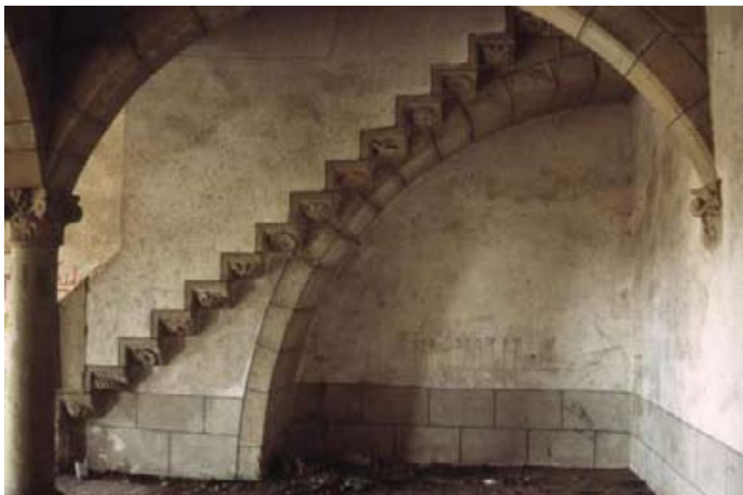
Escalera situada en la primera planta del Palacio de “Santa Marta” de Trujillo, antes de la restauración
