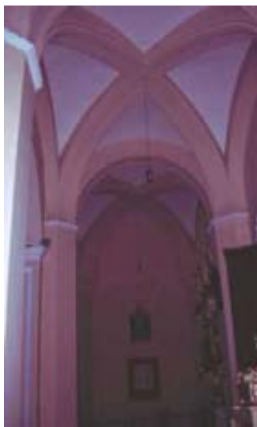
Detalle de una nave lateral de la Iglesia de San Agustín, Lima
