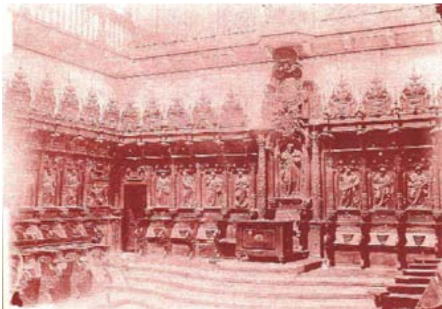
Sillería del coro de la catedral en su ubicación original, antes de 1898, con sus sitiales altos y bajos, obra de Pedro de Noguera
