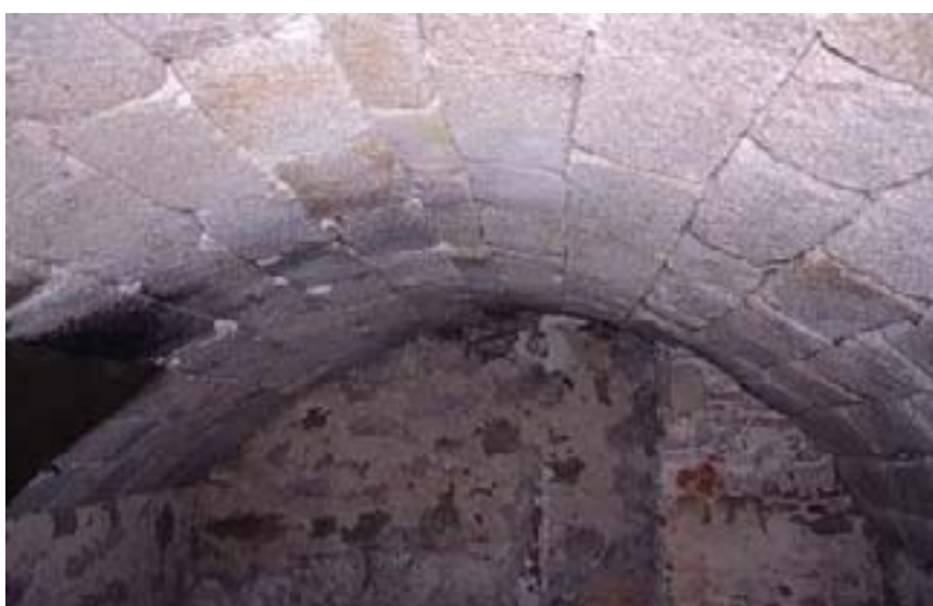
Cubierta de medio cañón de la cripta de Santo Domingo de Trujillo
