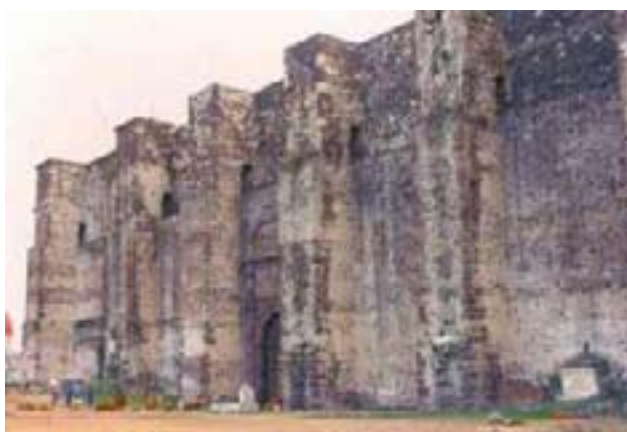
Contrafuertes de la iglesia conventual de Cuauhtinchan
