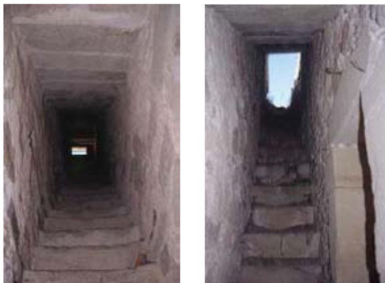
Subida de escalera hacia la torre de las campanas de las iglesias de Orellana la Vieja y Santo Domingo de Trujillo respectivamente
