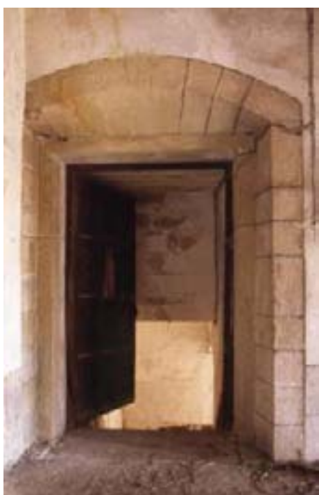
Vano capialzado del palacio de Santa Marta de Trujillo y dibujo de un arco capialzado de Martínez de Aranda 665
