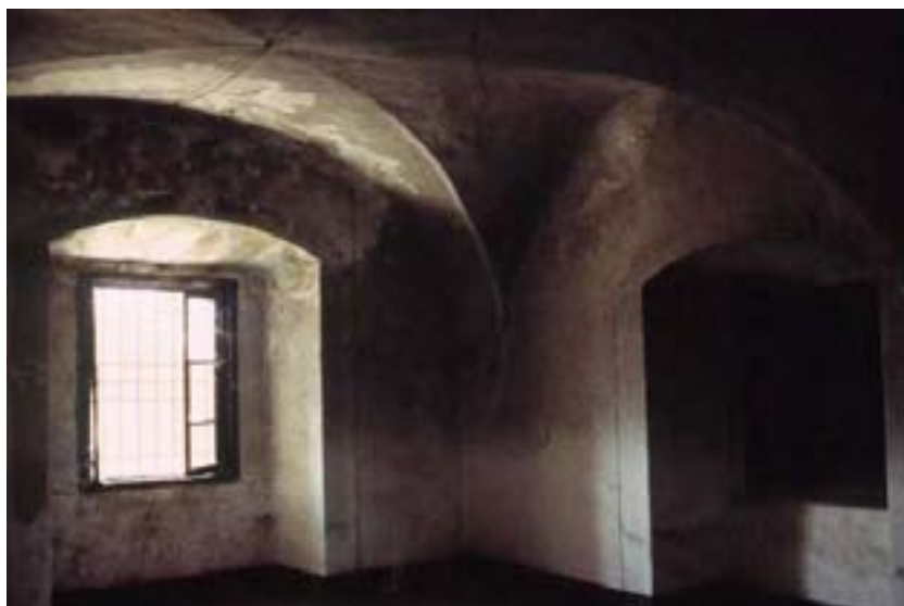
Cubierta de arista de una habitación situada en la entreplanta del palacio de Santa Marta
