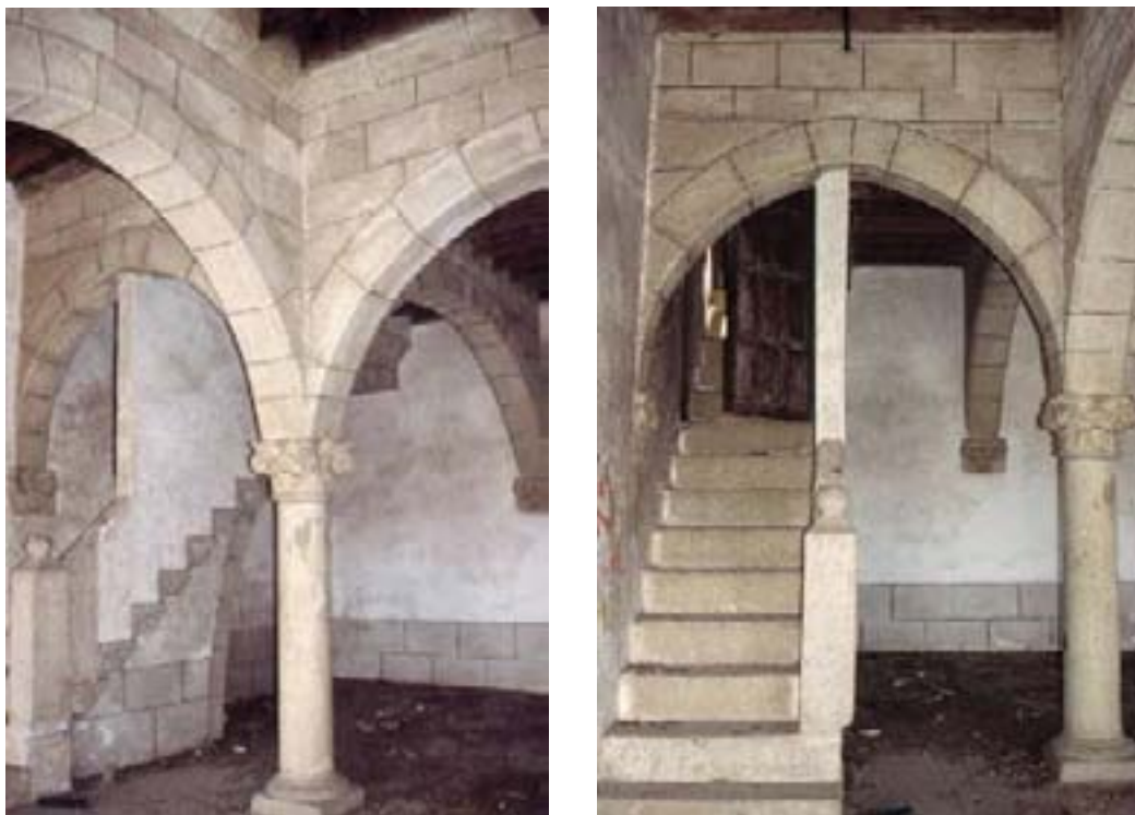
Detalles de los arcos y subida de la escalera del primer piso
