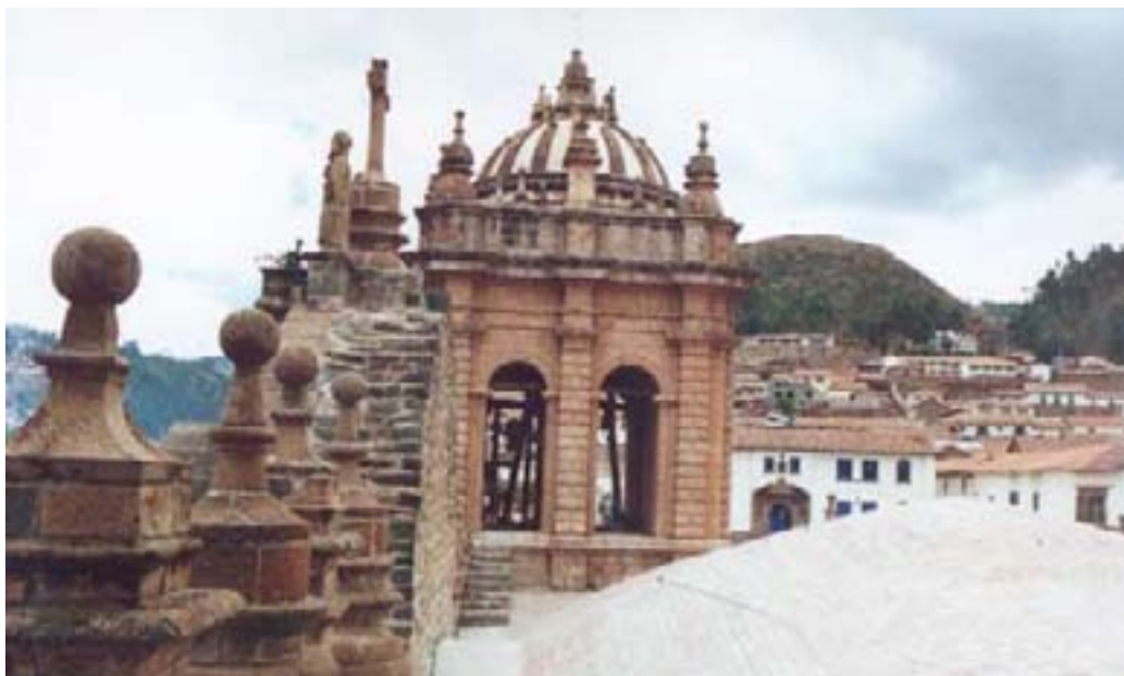
Restauración de la torre de las campanas de la catedral cuzqueña
