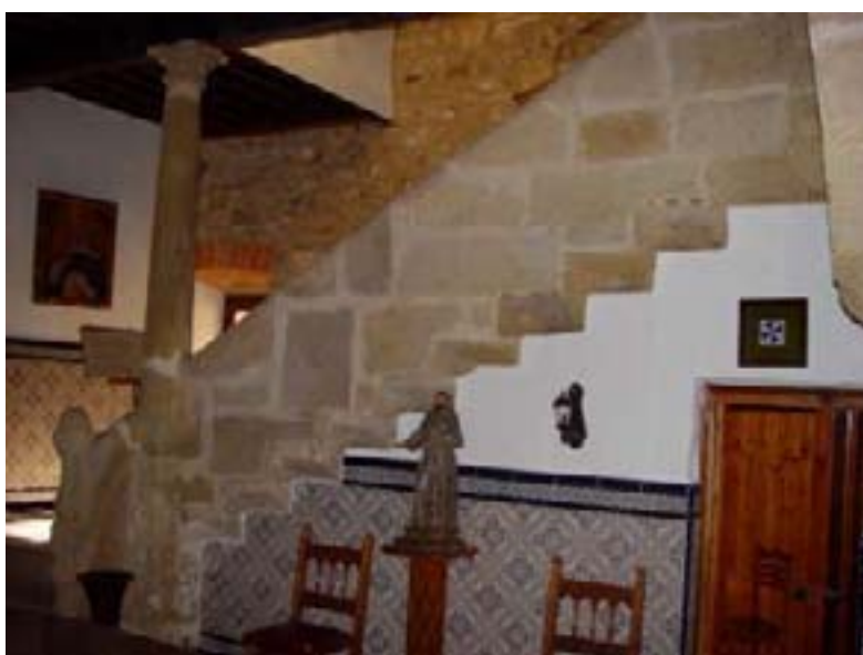
Escalera interior del Convento de San Miguel en Trujillo
