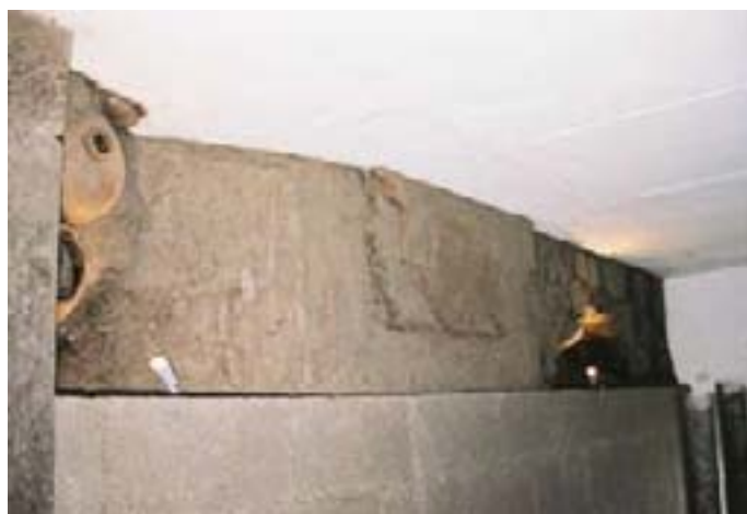
Detalle de algunas ollas de barro utilizadas como relleno para la bóveda de la sala capitular
