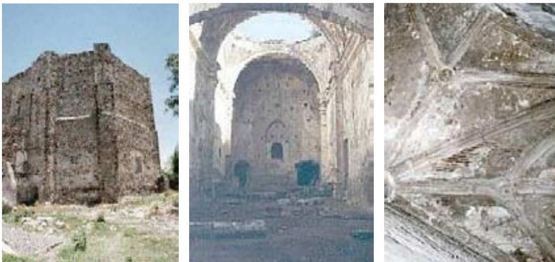
Detalle de la cabecera, el presbiterio y los restos de la bóveda de crucería del ábside
