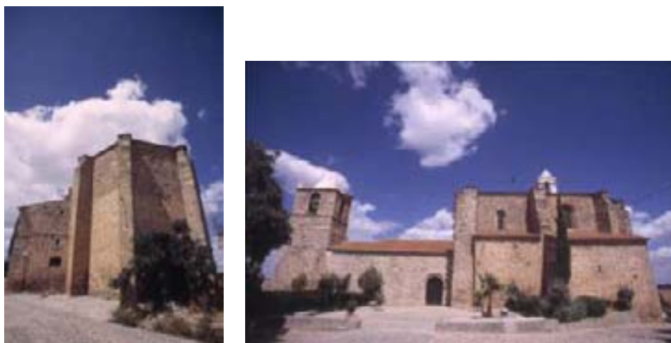
Cabecera y contrafuertes de la Iglesia parroquial de Valdetorres de Tajo
