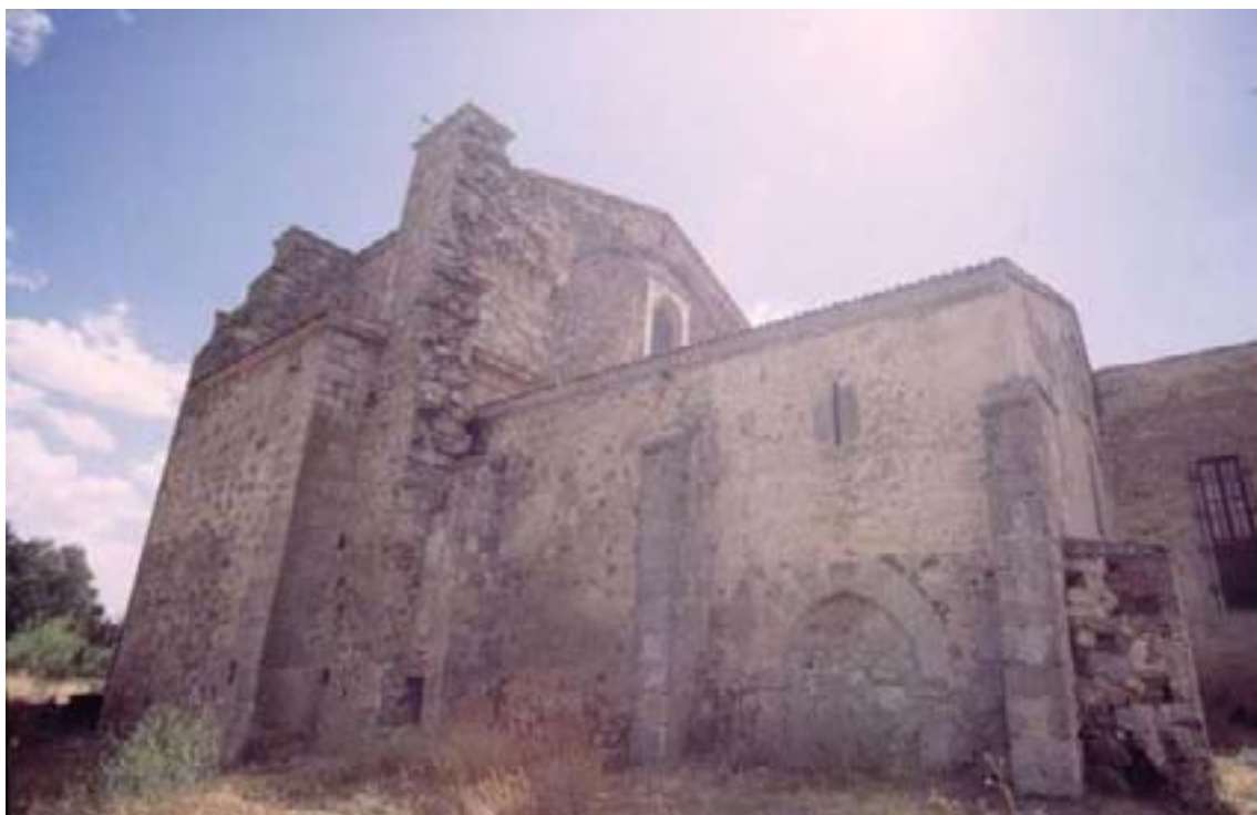
Fachada del lado del evangelio y portada con arco apuntado cegada de la iglesia de Valdetorres de Tajo
