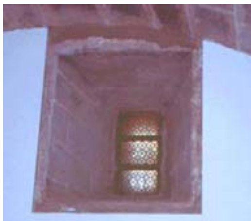
Ventana de la sacristía de Valdetorres de Tajo
