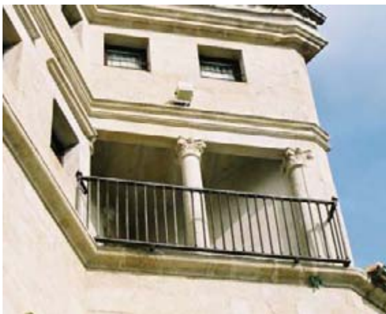
Detalle de la fachada en ángulo con su balcón de la misma
