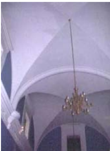
Bóveda de arista de la sacristía de la catedral de Lima
