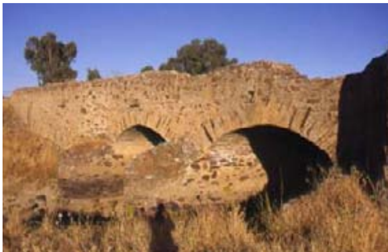
Puente sobre el río Magasquilla
