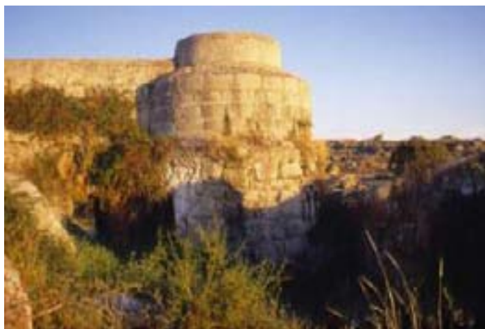
Sistema de aliviadero en forma de “arubah”
