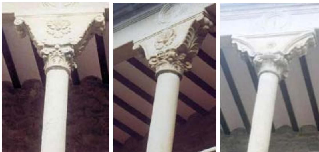
Diferentes tipos de capiteles y zapatas de la galería superior del patio
