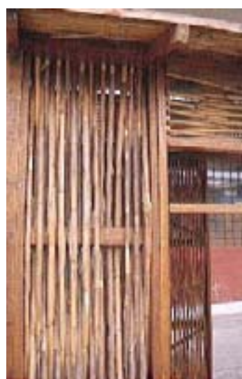
Entramado de un telar de caña. Prácticas de la Facultad de Arquitectura Urbanismo y Artes de la UNI. Lima (Perú)
