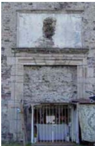
Puerta norte del Convento de Totimehuacan
