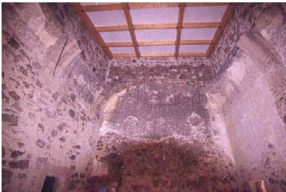
Salón principal restaurado del Palacio de Orellana la Vieja
