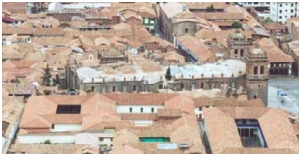
Secuencia de domos de la catedral de Cuzco, diferencia de altura entre las tres naves principales y las de capillas
