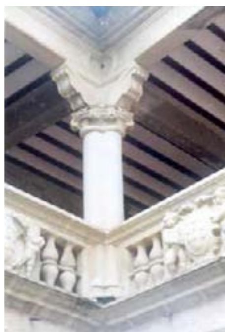
Zapatas de los ángulos del patio
