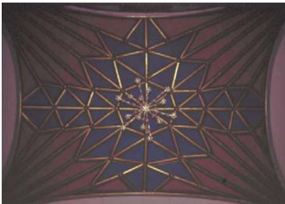
Bóveda de quincha actual de la Catedral de Lima, Perú
