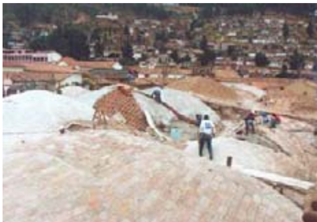
Restauración de las cubiertas de la catedral de Cuzco (Perú)
