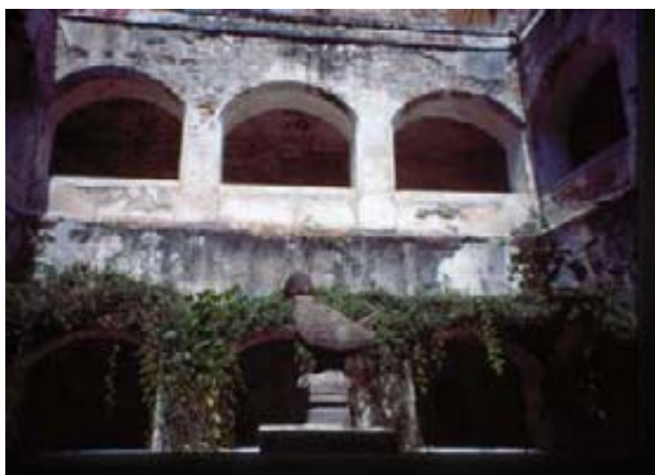
Claustro del Convento de Cuauhtinchan
