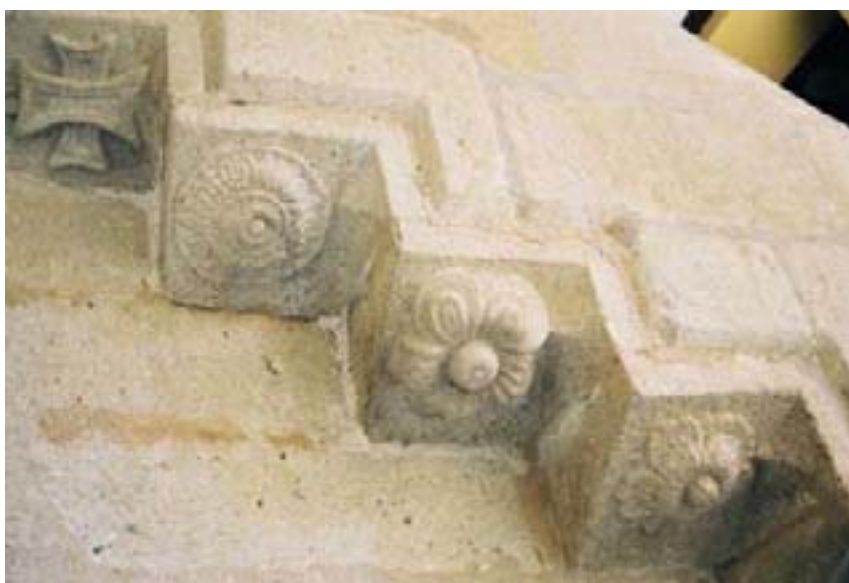
Decoración de las cabezas de los pasos de segundo tramo de la escalera
