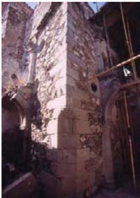
Restos de los soportes del patio porticado y de una de las habitaciones que estaría cubierta con bóveda de ladrillo, puerta adintelada y escudo de los Orellana
