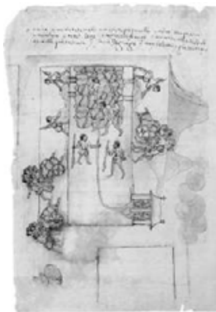
Cimentación de la Catedral de México 648
