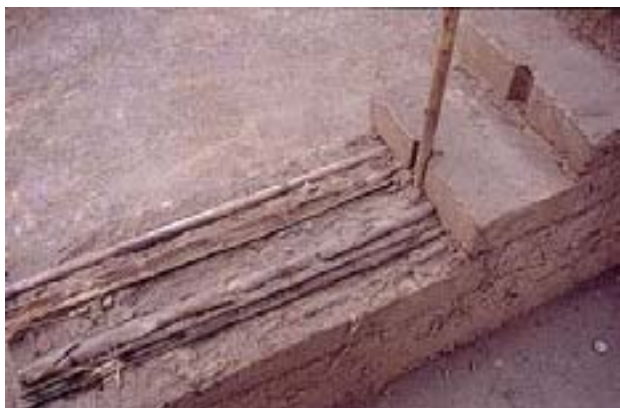
Muro realizado en quincha (adobe y caña)
