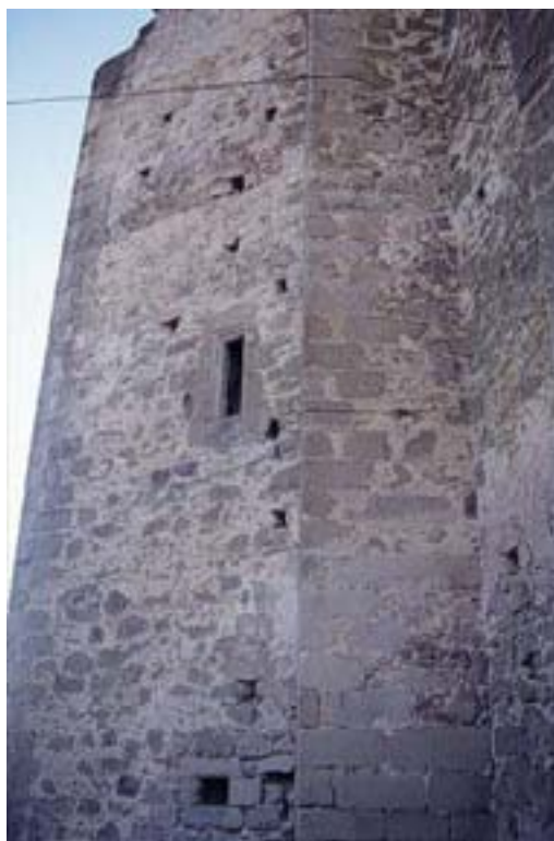
Detalle de los muros y las ventanas
