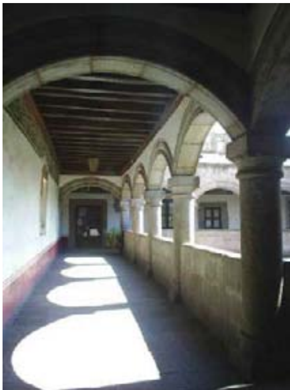
Claustro del Convento de Tlalnepantla
