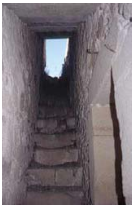
Cubierta de la escalera de acceso a la torre de Santo Domingo de Trujillo y Orellana la vieja, respectivamente
