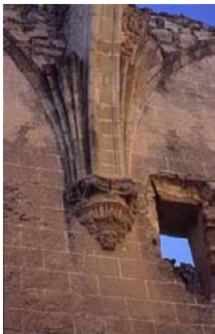
Arranque de los nervios de la bóveda de crucería sobre una ménsula, en la iglesia de Santo Domingo de Trujillo y detalle de las distintas piezas del jarjamento 684
