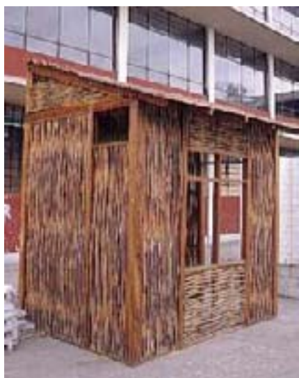
Entramado de un telar de caña. Prácticas de la Facultad de Arquitectura Urbanismo y Artes de la UNI. Lima (Perú)
