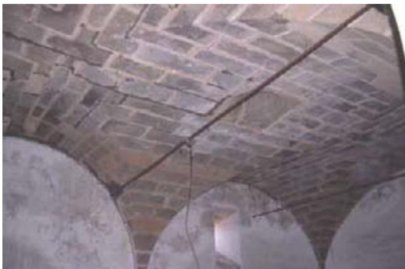
Bóveda de arista del zaguán de entrada del Palacio de Santa Marta de Trujillo
