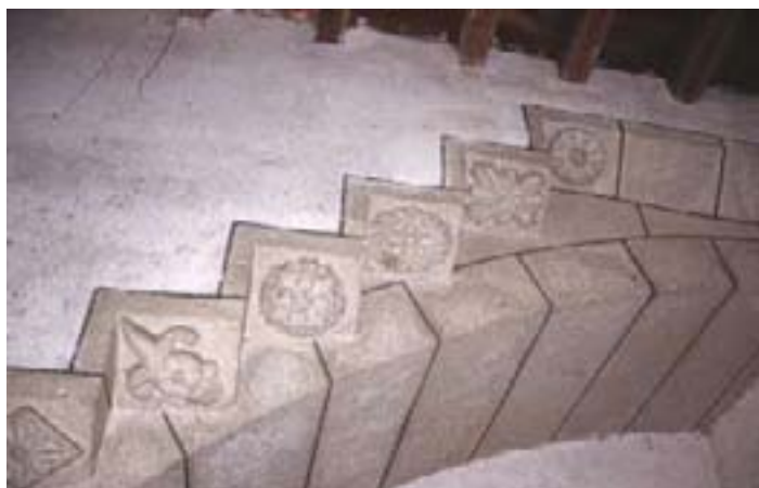
Detalle de los pasos de la escalera del Palacio de “Santa Marta”
