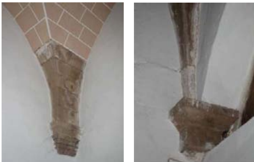
Detalle de los arranques de la bóveda de arista de la capilla
