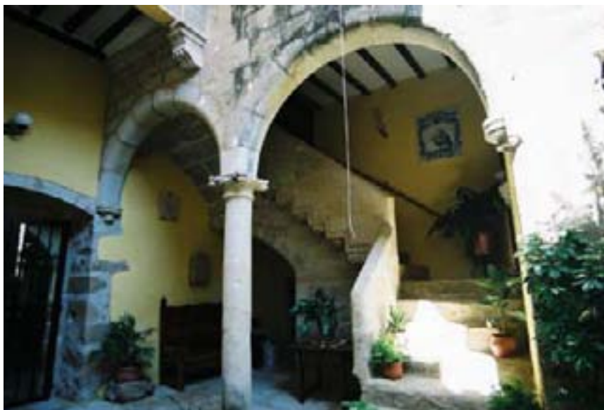
Patio y escalera de la Casa de los Rol Zárate y Zúñiga
