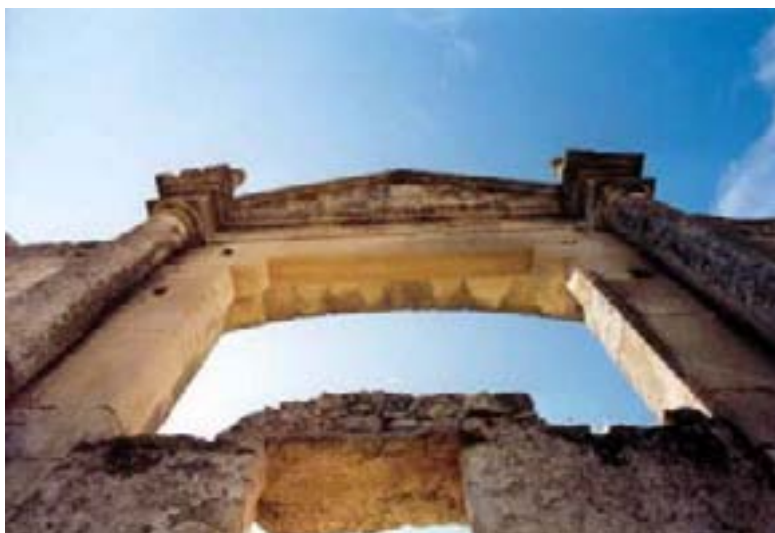
Detalle del dintel y ménsulas de la portada de la Dehesa de las Yeguas
