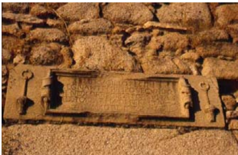
Detalle de la inscripción situada sobre el dintel de la puerta del molino principal
