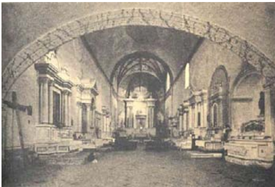
Interior de la iglesia del convento de Tepoztlán, atribuida a Becerra 1785
