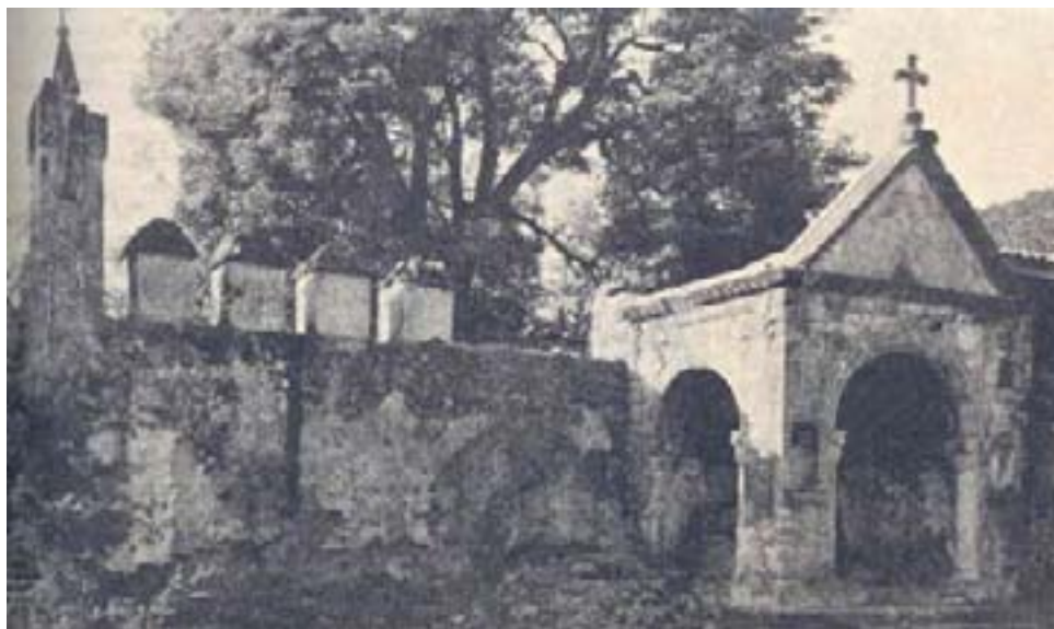
Barda atrial del Convento de San Domingo de Tepoztlán antes de la restauración
