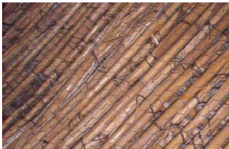
Cañas unidas y entrelazadas para realizar las cubiertas de quincha. Facultad de Arquitectura, Urbanismo y Artes de la Universidad Nacional de Ingeniería de Lima (Perú)
