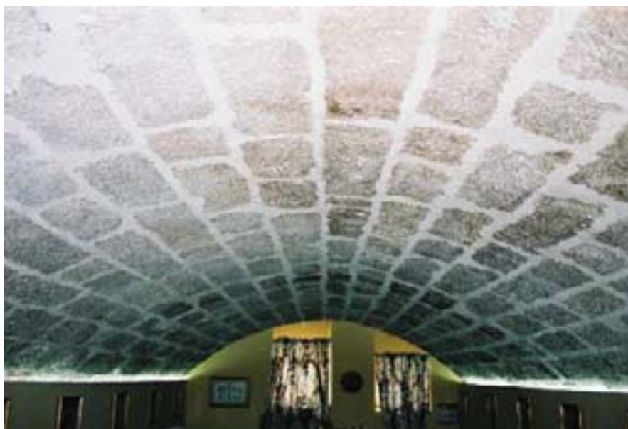
Bóveda de medio cañón que forma parte de las dependencias de la Casa de los Rol-Zárate y Zúñiga
