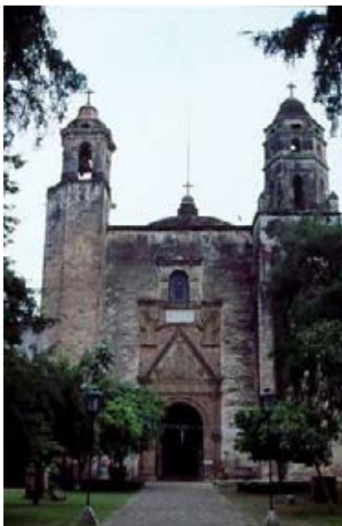
Fachada de la iglesia conventual de Tepoztlán
