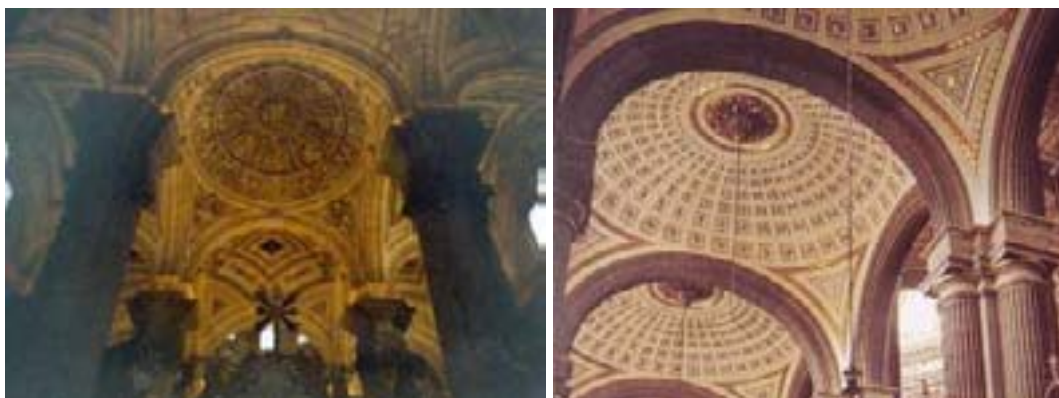
Bóveda vaída y soportes que se elevan con un trozo de entablamento de las catedrales de Jaén, (España) y Puebla (México), respectivamente.
