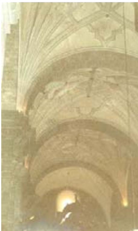
Detalle de la bóveda de la nave central de la catedral de Cuzco
