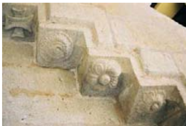
Cabezas de los pasos de la escalera de la Casa de los Rol Zárate y Zúñiga
