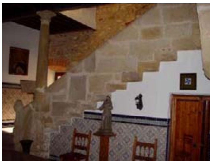
Escalera interior del Convento de San Miguel en Trujillo
