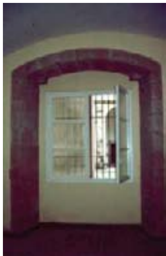
Puerta cegada de una de las estancias trazadas por Becerra y ménsula de cantería de la misma donde se apoya la bóveda de arista de la misma habitación
