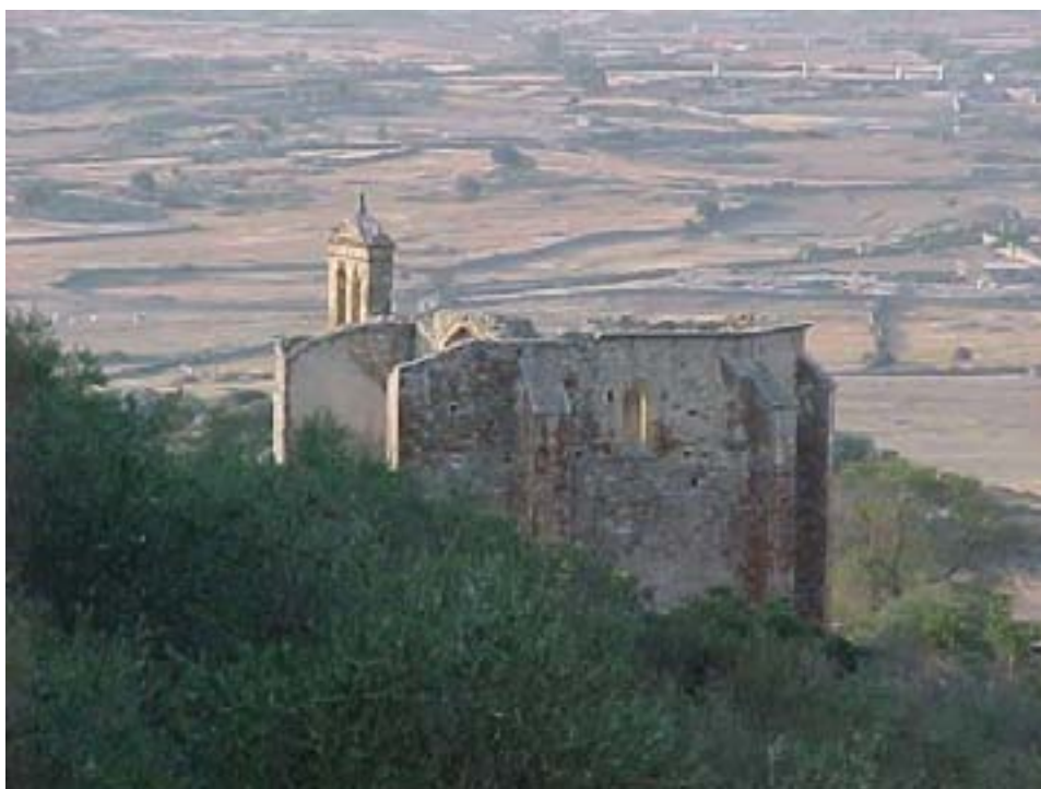
Restos de la Iglesia parroquial de Santo Domingo de Trujillo
