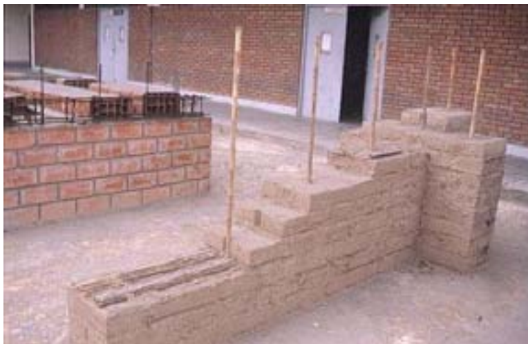
Muro elevado con ladrillos de adobe. Facultad de Arquitectura, ingeniería y artes de la Universidad Nacional de Ingeniería de Lima (Perú)
