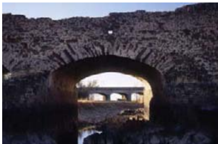
Arquería del puente antiguo desde el que se divisa el puente nuevo
