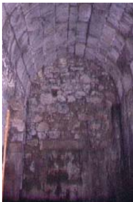
Bóvedas de cañón de las caballerizas del palacio de Santa Marta y del molino de la Albuhera de San Jorge, ambas en Trujillo
