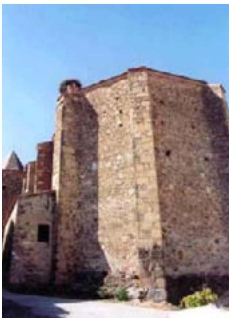
Detalle de los contrafuertes de la Iglesia parroquial de Herguijuela
