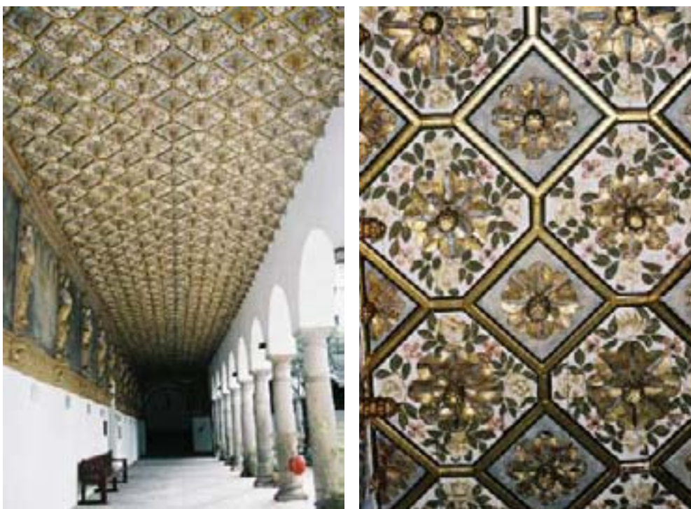
Crujía del claustro bajo que conserva la cubierta original del siglo XVII y detalle de su artesonado
