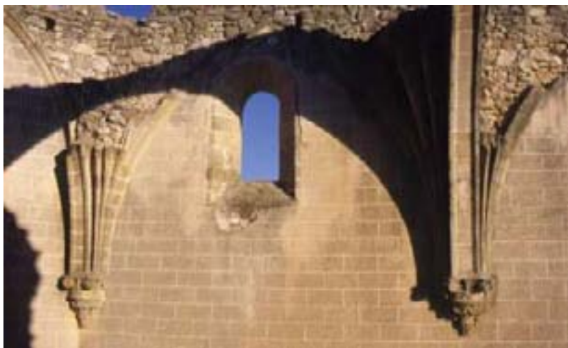
Restos de la bóveda de crucería del presbiterio de Santo Domingo
