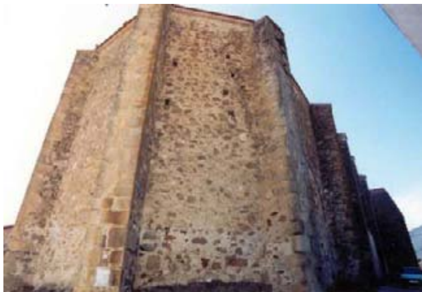
Vista exterior y detalle de los contrafuertes de la iglesia
