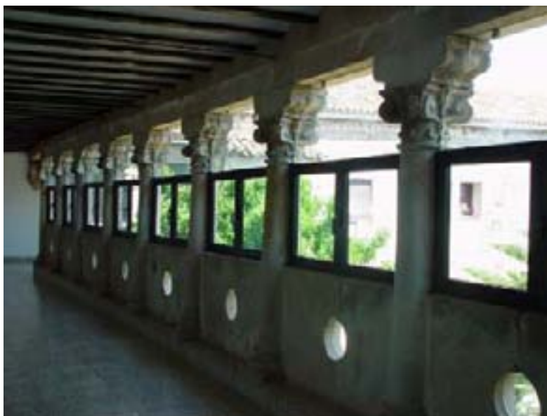
Galería superior del claustro conventual de San Miguel de Trujillo
