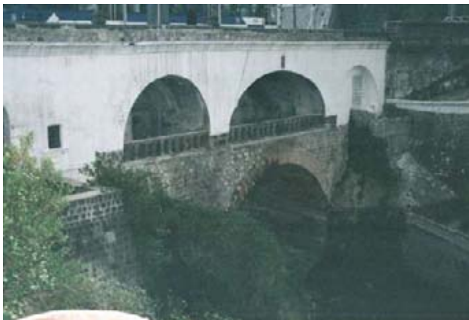
Puente sobre el río Machángara, Quito
