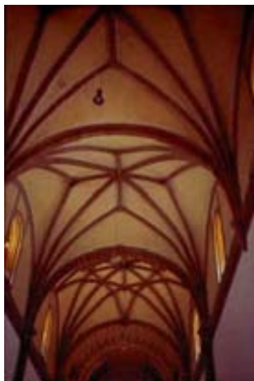
Bóveda de crucería de la Iglesia de San Francisco de Puebla
