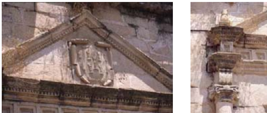
Detalles del frontón y soportes de la portada del Palacio de “Santa Marta”
