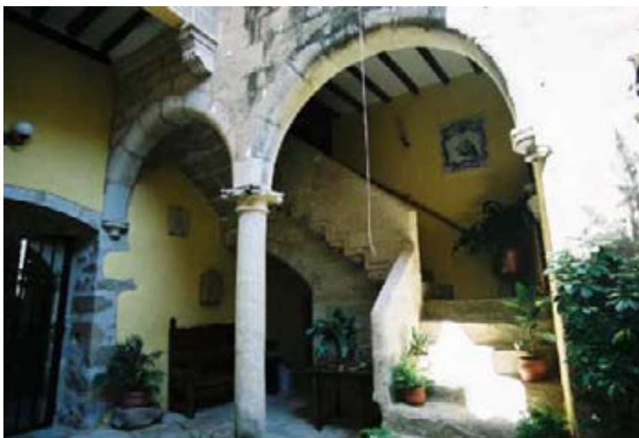
Galería y escalera del patio de la Casa de los Rol-Zárate y Zúñiga de Trujillo
