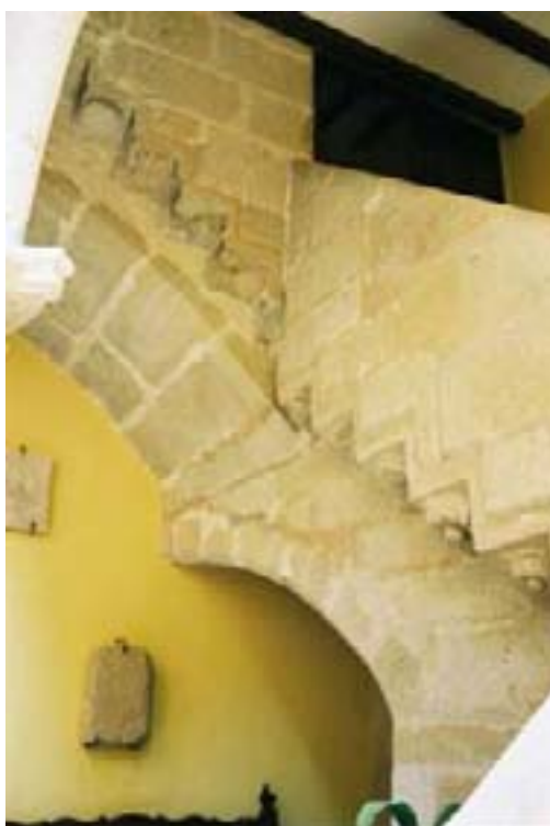
Escalera del patio de la Casa de los Rol-Zárate y Zúñiga de Trujillo
