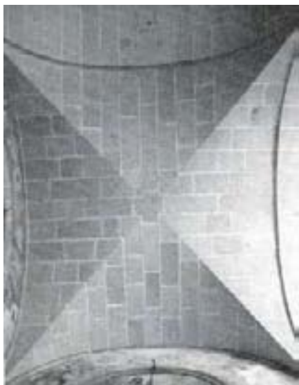
Bóveda de arista en el Escorial y bóveda de arista del zaguán del Palacio de Santa Marta
