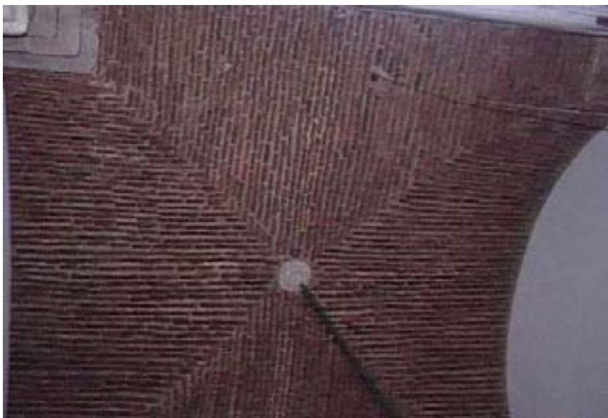
Bóveda de arista de la sacristía de la Iglesia de Orellana la Vieja
