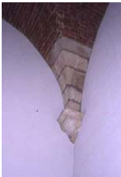
Detalle de los arranques de la bóveda de la sacristía de Orellana la Vieja
