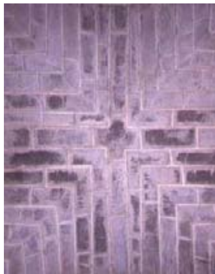
Bóveda de arista en el Escorial y bóveda de arista del zaguán del Palacio de Santa Marta
