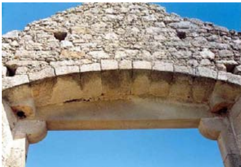
Arco rebajado de la portada por la parte posterior
