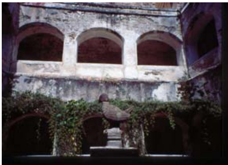
Claustro del Convento de Cuauhtinchan
