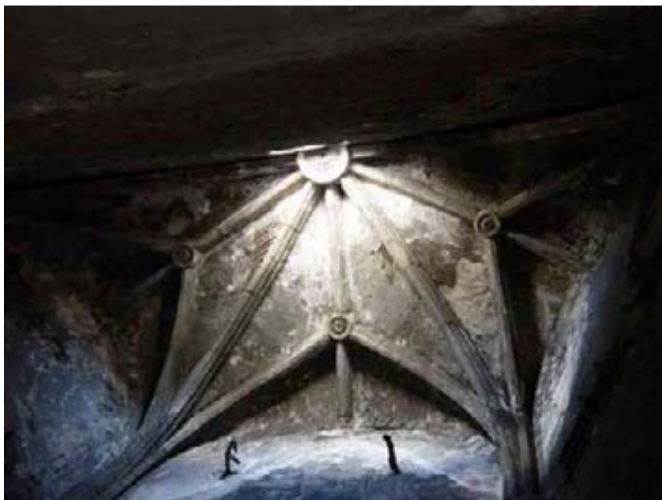
Detalle de la bóveda de crucería del presbiterio de Totimehuacán
