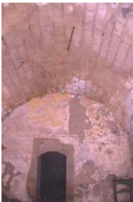
Bóvedas de cañón de las caballerizas del palacio de Santa Marta y del molino de la Albuhera de San Jorge, ambas en Trujillo
