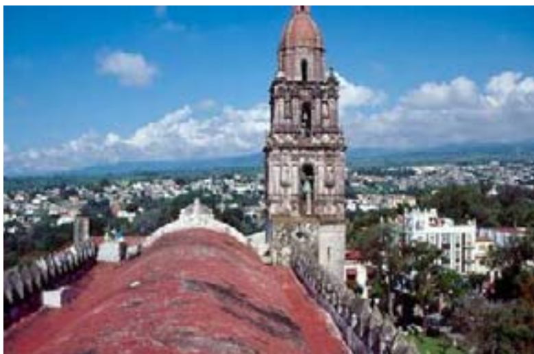
Cubierta del Convento de San Francisco de Cuernavaca
