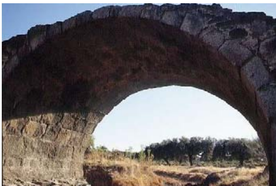
Puente y detalle del mismo, construido sobre el río Magasquilla
