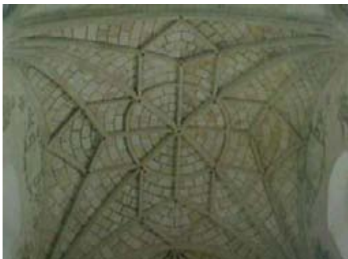
Bóveda del presbiterio de la Iglesia Conventual de San Agustín de Acolman
