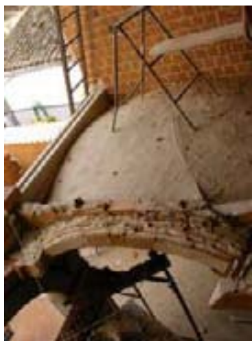
Construcción de una bóveda de ladrillo sin cimbra
