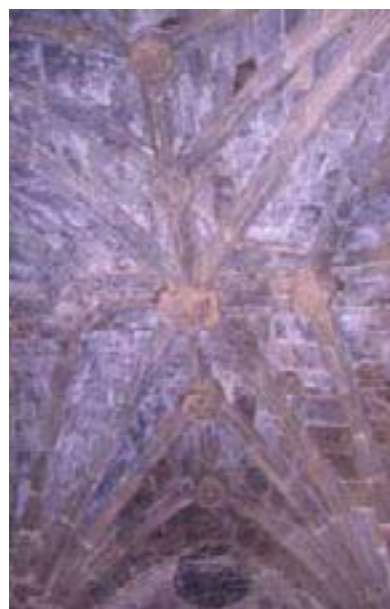
Restos de la bóveda de crucería del presbiterio y bóveda de crucería de la iglesia de Santo Domingo de Trujillo, ambas de Becerra
