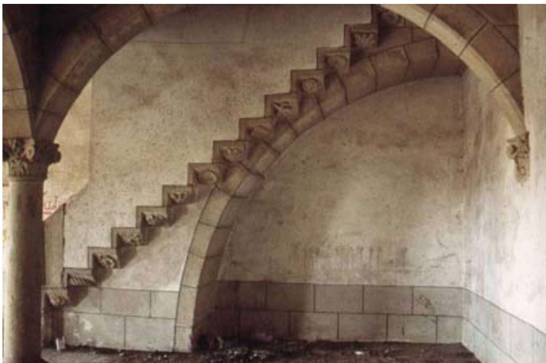
Escalera del segundo piso del Palacio de “Santa Marta”
