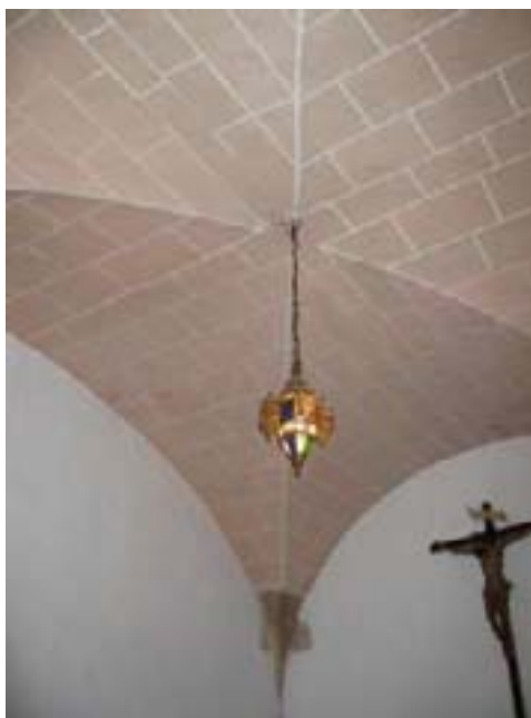
Detalle de la bóveda de arista de la capilla de Guadalupe.
