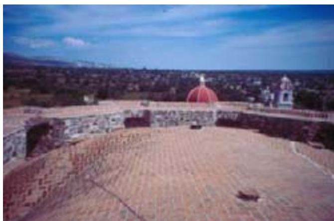
Cubiertas del convento de San Juan Bautista de Cuauhtinchán (Nueva España)
