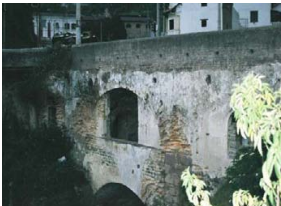
Puente sobre el río Machángara, Quito
