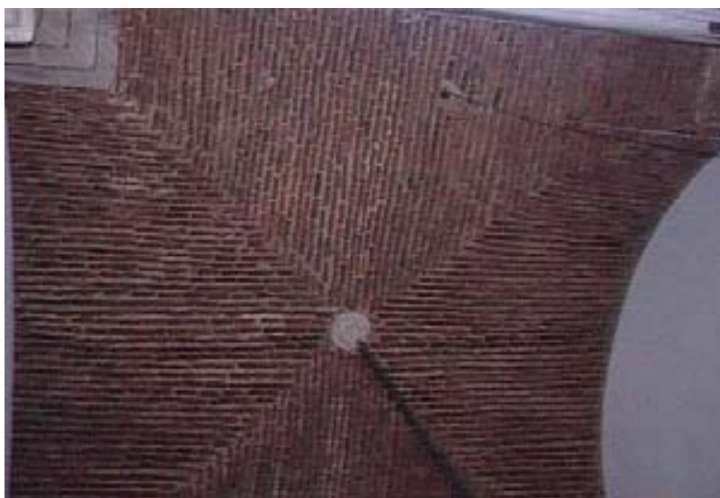
Bóveda de la sacristía de la Iglesia de Orellana la Vieja
