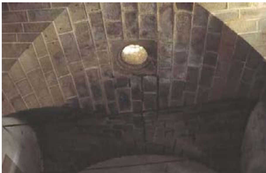
Bóveda de arista de piedra que cubre el hall del palacio de Santa Marta de Trujillo
