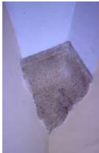
Puerta cegada de una de las estancias trazadas por Becerra y ménsula de cantería de la misma donde se apoya la bóveda de arista de la misma habitación
