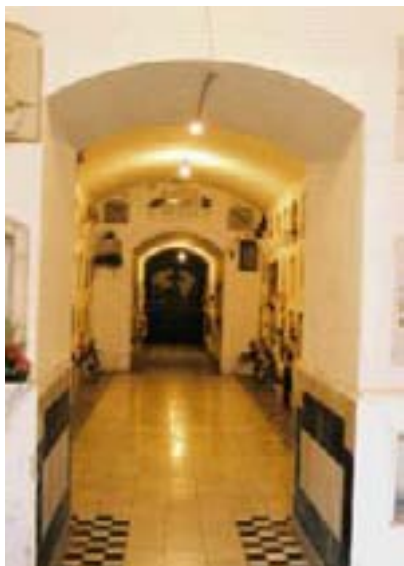
Bóvedas subterráneas utilizadas como cimientos de la iglesia, y aprovechadas para enterramiento de los religiosos dominicos
