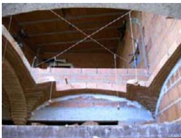
Construcción de una bóveda de ladrillo de una casa actual de Torremocha 695
