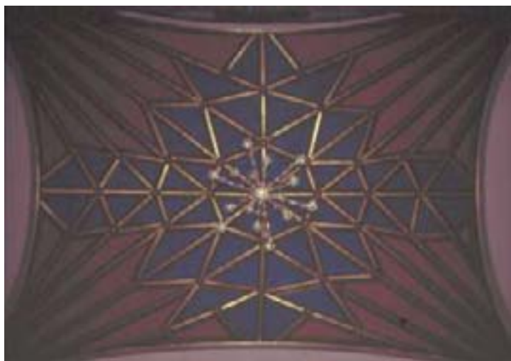
Detalle de la cubierta de quincha de la catedral de Lima
