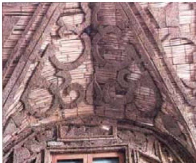
Cubierta de la Iglesia de Santo Domingo de Lima realizada con cañas a la que se debe añadir una capa de barro (quincha)
