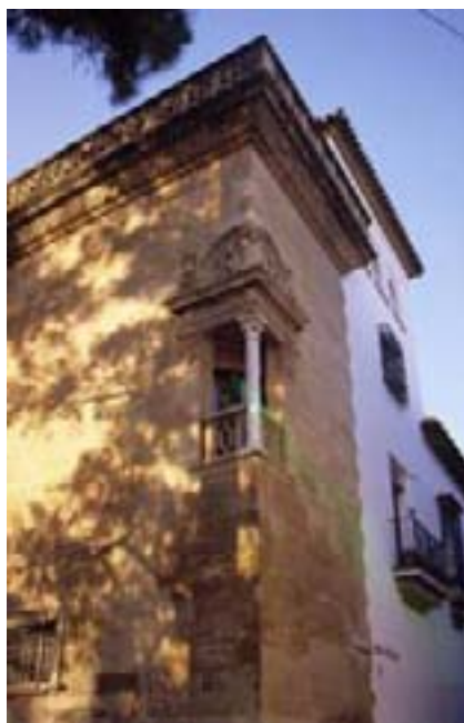
Balcón de esquina (Córdoba)
