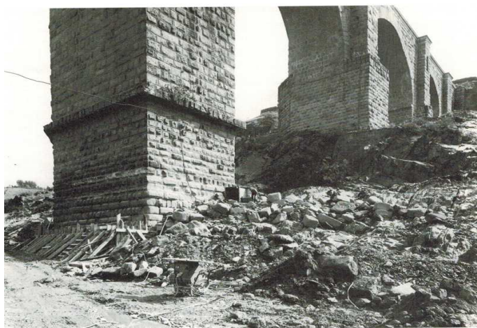
Fig. 3. Escolleras junto a la pila central (de Fernández Casado).
