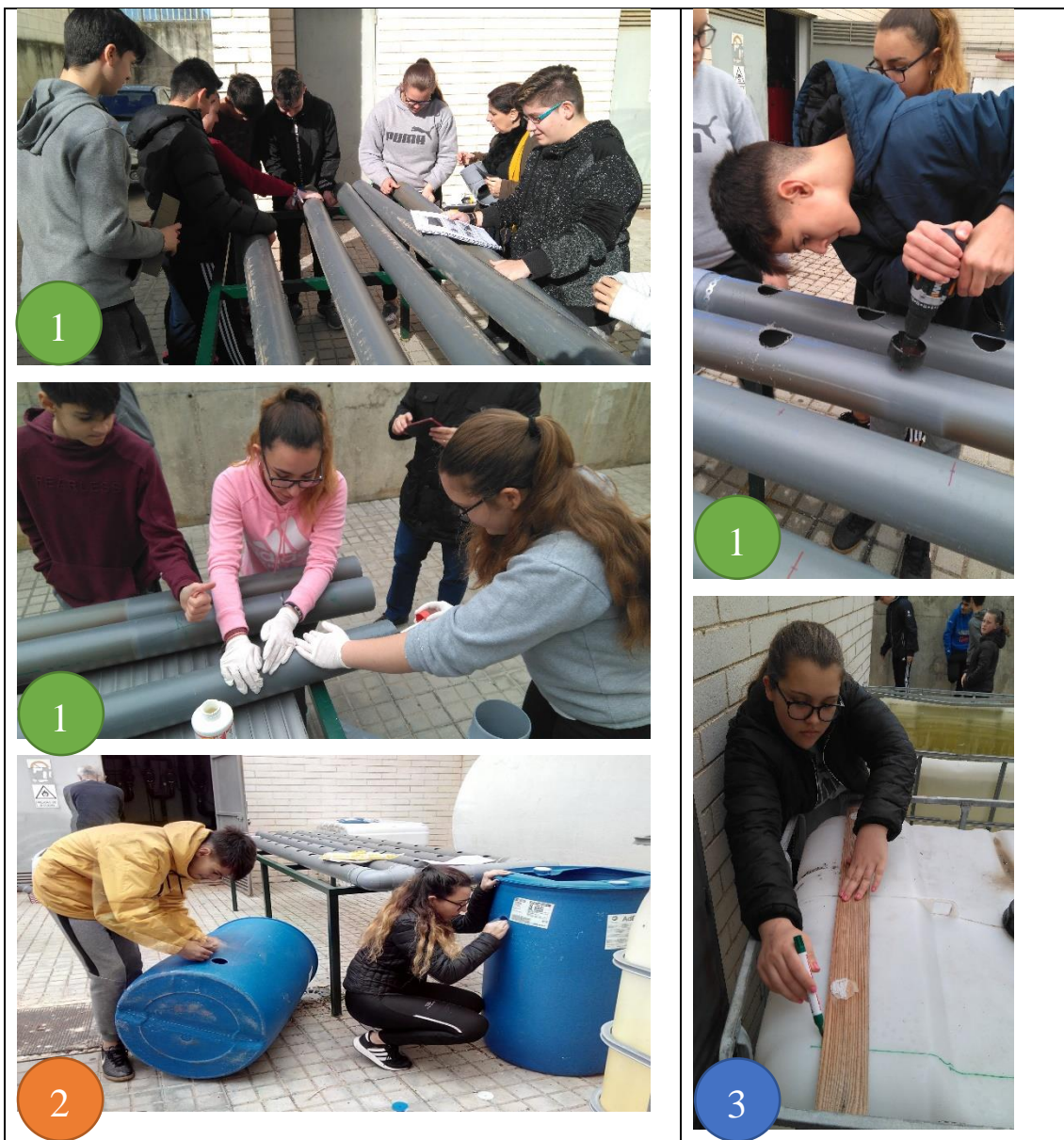
Figura M 6. Construcción del Sistema Acuapónico, por parte de los alumnos de Formación Profesional Básica. (1) Fabricación y montaje del sistema NFT donde se situarán las plantas. (2) Preparación de los depósitos que recogerían el agua del tanque de los peces y que albergan las biobolas. (3) Preparación del depósito para las tencas.
