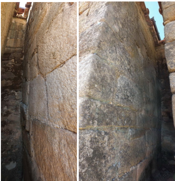
Fotografías 169 y 170: Muros Sur y Norte del ábside central, ambos contruidos solo con sillares de granito (fotografías del autor)
