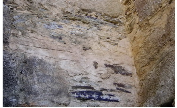
Fotografía 157: dos capas de enlucido, una inferior, más grosera, sobre la que se fue marcando con la misma paleta unas líneas sobre las que agarrara mejor la segunda aplicación de enlucido, más fino y uniforme, ya de acabado (fotografía del autor)
