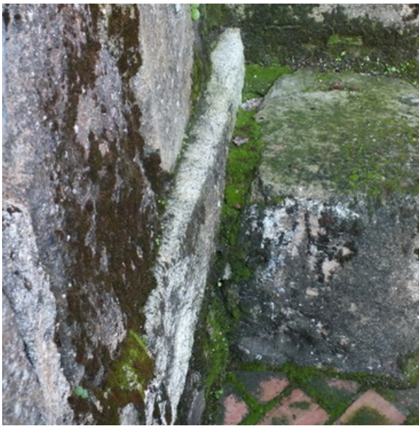
Fotografía 105: Muro Oeste del transepto, en su recorrido visible desde las habitaciones laterales, en su mitad Norte, la primera hilada y cimentación sobresale de la alineación del muro del transepto que soporta (fotografía del autor)
