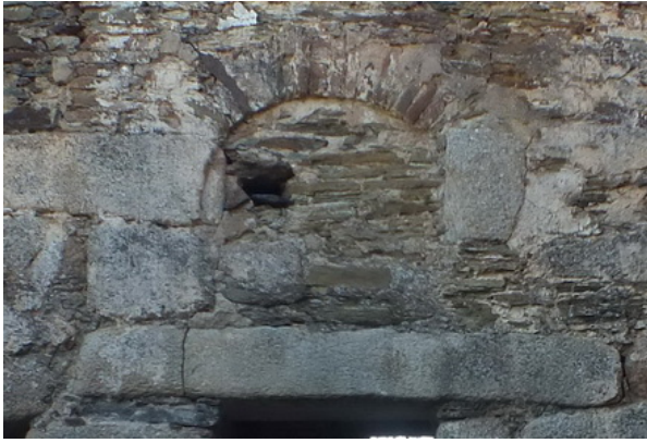
Fotografías 203 y 204: Arcos de descarga de puerta Sur de la nave y de puerta Oeste de ala Sur del Transepto (fotografía del autor)
