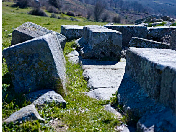
Fotografía 072: Cimentación y restos de primera hilada de sillares del templo romano inserto en el santuario vetón de Piedras Labradas (fotografía cedida por Víctor Gibello Bravo)
