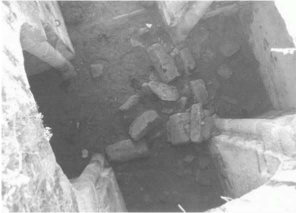
Fotografía 002: Vista del cruceiro central con piedras caídas del cimborrio. Se aprecia umbral entre el coro y transepto con hendiduras para cancelas (fotografía inédita cedida por Juan Rosco y M a Luisa Téllez)
