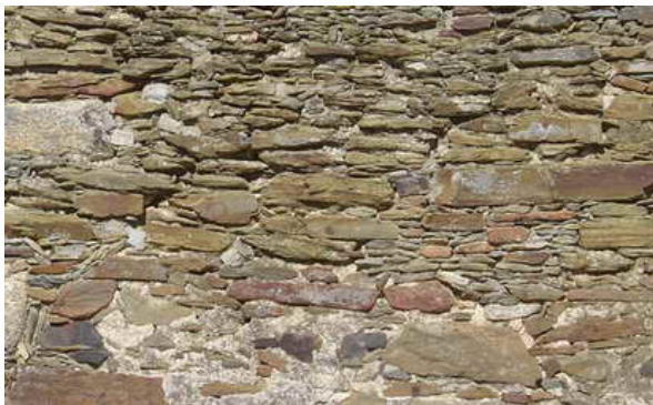
Fotografía 223: Aparejo de mampostería de Santa Lucía del Trampal, buscando tendeles horizontales en muro oeste (fotografía del autor)
