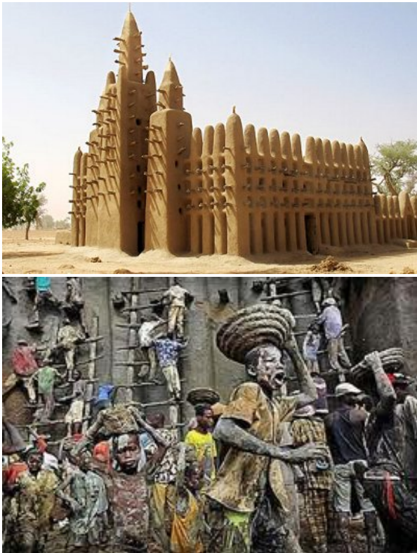
Fotografías 195 y 196: Mezquita Kani Combale, en el país Dogon, Mali. En las mezquitas de Mali, íntegramente de barro, las estacas clavadas no son un mero motivo decorativo; están preparadas para facilitar las tareas de mantenimiento, ya que el "embarrado" es una labor de mantenimiento permanente, asumida por todo el pueblo (fotografías de la 10ª Conferencia Internacional para el estudio y conservación del Patrimonio de arquitectura de tierra, organizada por el Getty Conservation Institute y el Ministerio de Cultura de Malí)
