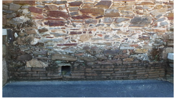
Fotografía 109: Vista de las verdugadas de ladrillo en el muro Norte de la nave (fotografía del autor)
