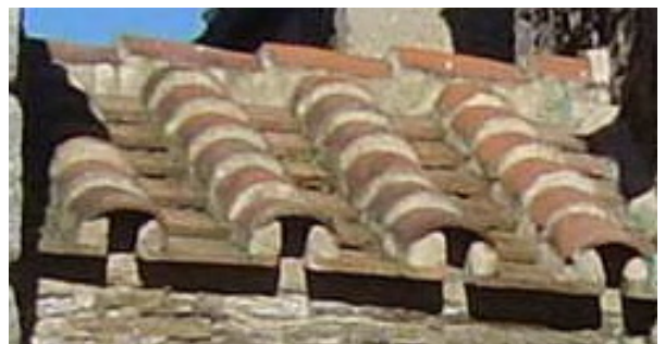
Fotografía 208 Tejado de tégulas e ímbrices (fotografía del autor)
