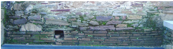
Fotografía 220 Mampostería en lado norte de nave, más regular y consistente en su aparejo (fotografía del autor)
