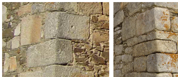
Fotografías 145 y 146: Sillares de granito como refuerzo de esquinas en encuentro de muros (fotografía del autor)
