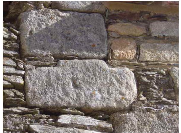
Fotografía 183: Sillar de granito acodado reaprovechado de forma indiscriminada en el arranque del cimborrio Sur, en su cara Oeste (fotografía del autor)
