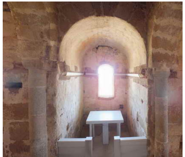
Fotografía 179: Ventana de ábside central, con friso marcando la línea de imposta, atravesando las jambas y saliendo al exterior (fotografía del autor)
