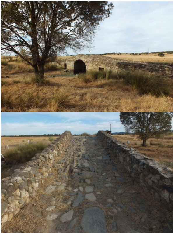
Fotografías 058 y 059: Puente de Santiago de Bencáliz, próximo al miliario XXVIII del Itinerario XXIV, entre Casas de Don Antonio (Ad Sorores) y Aldea del Cano, con pavimento remozado, pero tan antiguo que aún se reconocen las rodadas de los carros (fotografía del autor)
