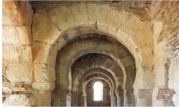
Fotografía 225 Arcos del transepto, en los que se aprecian dovelas labradas en una sola cara para acuñar, e intradoses poligonales (fotografía del autor)
