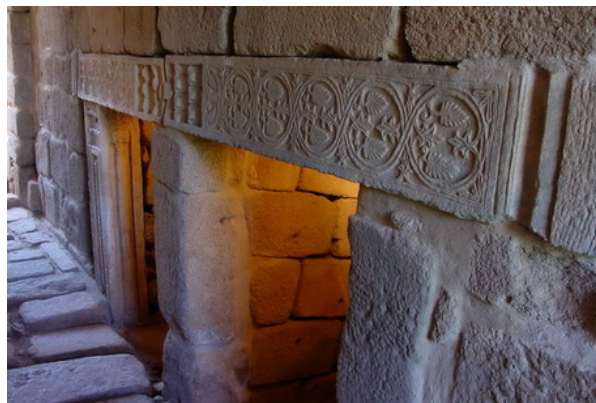
Fotografía 051: Pilastras visigodas reutilizadas por el Islam en el acceso al aljibe de la Alcazaba de Mérida (fotografía del autor)
