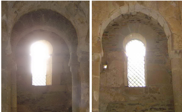
Fotografías 180 y 181: Ventanas Sur y Norte del transepto. Para mantener los huecos en el eje exterior e interior, se recurre a su mínimo abocinamiento esviando una de las jambas y manteniendo la otra perpendicular al muro testero (fotografía del autor)
