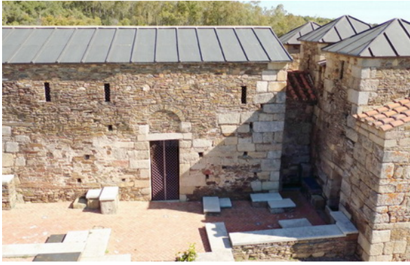
Fotografía 191: No se aprecia ninguna evidencia de enjarjes entre el muro Oeste del transepto y los muros laterales de la nave (fotografía de dron para el autor)
