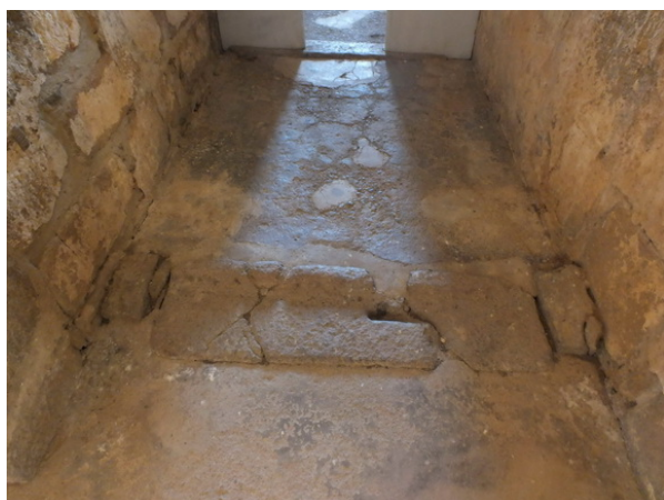
Fotografía 118: Vista del umbral entre nave y coro. Se aprecia la entalladura única (fotografía del autor)
