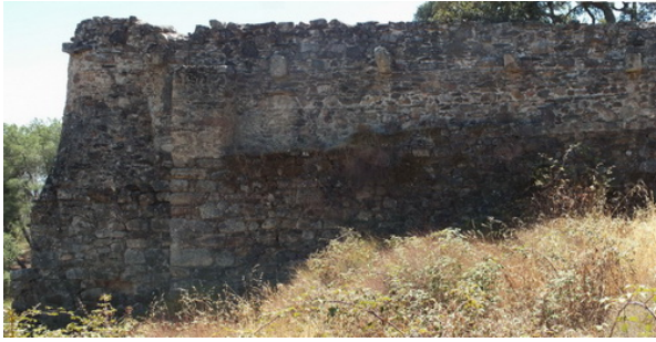
Fotografía 090: Detalle del molino harinero, en el que se adivina el canal superior, con piedras transversales de granito a modo de llaves para mantener las paredes del canal. Aunque con sucesivas reformas, se aprecia el lecho ligeramente inclinado del canal (fotografía del autor)
