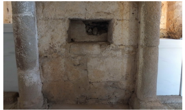
Fotografía 108: Credencia en tramo intermedio de muro oriental del transepto. Se aprecia el revestimiento interior (fotografía del autor)
