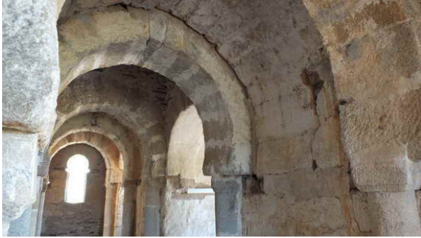
Fotografía 107: Muro Este del transepto, de Sur a Norte, con las columnas adosadas acortando la luz de los arcos para igualarlas a las del coro y ábside principal (fotografía del autor)
