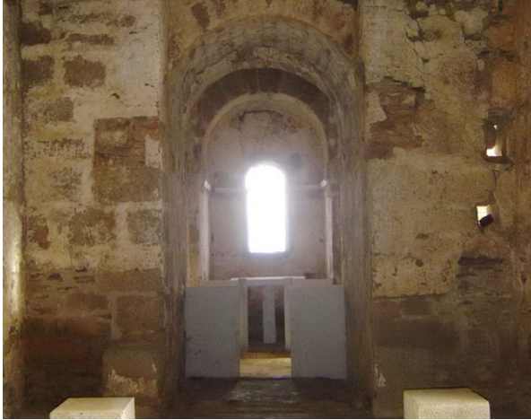
Fotografía 188: Muros testeros Este de la nave. No hay evidencias de los enjarjes debidos (fotografía del autor)
