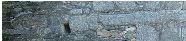
Fotografía 222: Muro de la fachada norte de la nave manteniendo nivelación horizontal con alineaciones de piedras (fotografía del autor)
