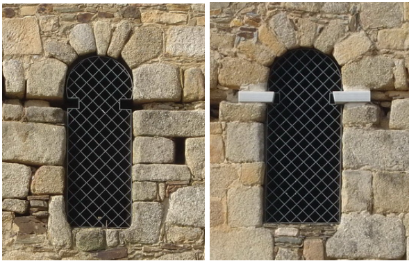
Fotografías 205 y 206: Arcos de ventanas de los ábsides Sur y Centro (fotografía del autor)
