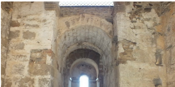
Fotografía 189: En las esquinas de las embocaduras del coro, a partir de la cota del friso se suceden huecos con relleno de mampuestos y ladrillos hasta arriba, lo que indicaría el engarce con las arcadas (fotografía del autor)
