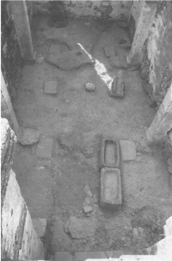
Fotografía 153: Durante los trabajos de restauración, bajo el terreno natural, aparecen sillares de los cimientos de dos arcadas en la nave (lámina 92 del libro de CABALLERO y SÁEZ (1999))
