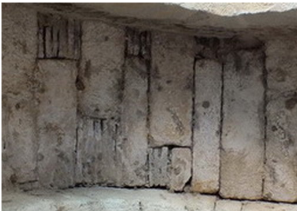
Fotografía 226: Detalle de bóveda del transepto, con incrustaciones ejecutadas con ladrillo repartidas más o menos uniformemente por la superficie semicilíndrica de la bóveda (fotografía del autor)
