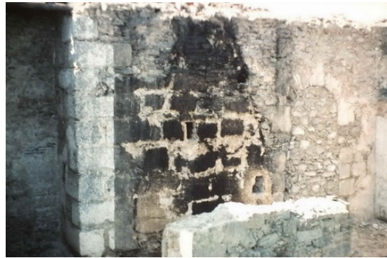
Fotografía 008: Marcas de la chimenea que construyó el aparcero, adosada al muro Norte de la nave. Se ve la puerta Norte del aula, tapiada (fotografía inédita cedida por Juan Rosco y M a Luisa Téllez)
