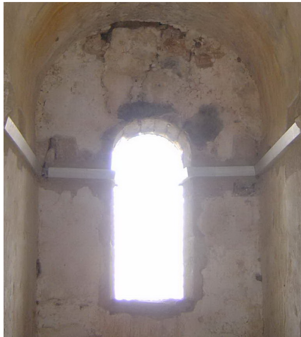
Fotografía 231: Testero de ábside principal con friso de mármol blanco colocado tras la restauración en el cajeadado del friso original (fotografía del autor)
