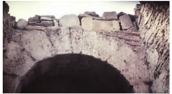
Fotografía 011: Trabajos en la cabecera. Ver acopio de materiales varios, entre ellos un ara votiva (la de inscripción nº 12 de la Tabla XX), sobre una bóveda (fotografía inédita cedida por Juan Rosco y M a Luisa Téllez)
