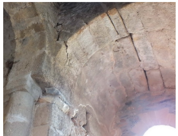
Fotografía 193: Ábside Sur. Se aprecia lo que parece, más que una fisura, la apertura de juntas entre piedras, resintiéndose sus partes más débiles (fotografía del autor)
