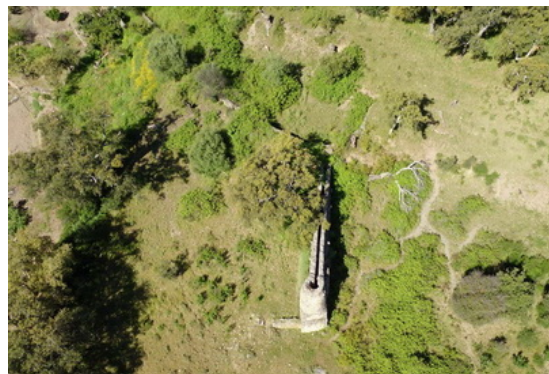
Fotografía 089: Molino harinero movido por agua; se aprecia el depósito previo y el canal hasta el pozo (fotografía de dron para el autor)
