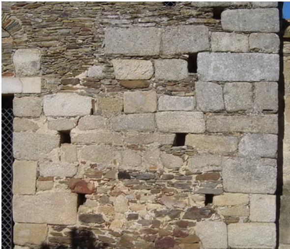
Fotografía 207: Muro con mechinales, rastro de los andamiajes utilizados para su ejecución (fotografía del autor)
