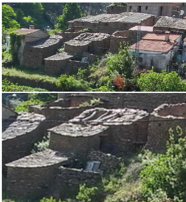
Fotografías 198 y 199: Viviendas de pizarra en Asegur, en Las Hurdes (Cáceres); piezas de pizarra colocada "a lecho" en los muros y exfoliada en lajas para la cubierta (fotografías del autor)
