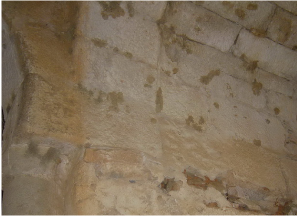
Fotografía 174: Ejemplo de dos salmeres consecutivos en el encuentro entre arcos perpendiculares de uno de los cruceros. Se aprecia cómo cada uno sigue una dirección, con entalladura del arranque del arco de herradura correspondiente, pero retallando discretamente cada uno de ellos la continuación del otro arco, resolviendo formalmente de forma limpia el encuentro entre ambos (fotografía del autor)
