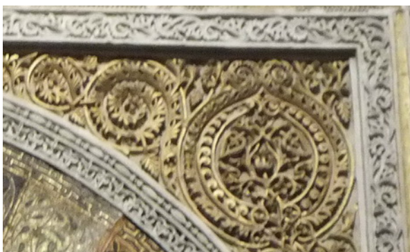
Fotografía 382: Detalle de albanega entre el alfiz y el extradós del arco de herradura de la entrada al mihrâb de la Mezquita de Córdoba (fotografía del autor)
