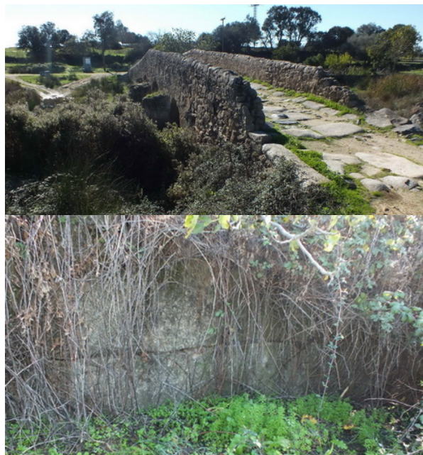
Fotografías 060 y 061: Puente medieval de Casas de Don Antonio (Ad Sorores) sobre el río Ayuela, y sillares romanos "a hueso" en su situación original del itinerario XXIV (fotografía del autor)
