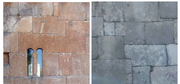
Fotografías 218 y 219: Detalles de muros de sillares reutilizados en San Pedro de la Nave (izda) y Quintanilla de las Viñas (dcha), (fotografías del autor)
