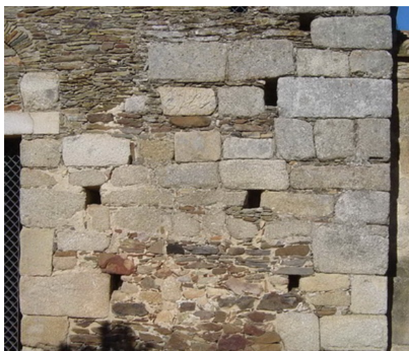
Fotografía 143: Mechinales para la construcción de los muros de mampostería (fotografía del autor)
