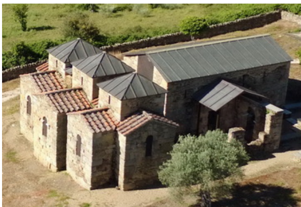
Fotografía 176: Plasticidad volumétrica del conjunto (fotografía de dron para el autor)
