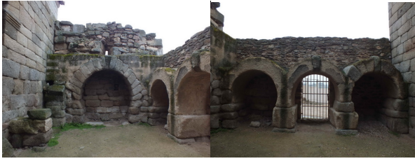
Fotografías 215 y 216: Habitación lateral, posible atrio, en Santa María de Melque, donde se parecía como se trata de muros sin enjarjar con los del cuerpo del templo (fotografía del autor)
