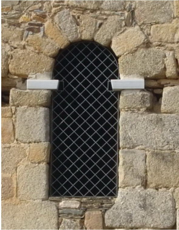
Fotografía 232: Ventana del ábside principal donde se ve como el friso de mármol blanco atraviesa las jambas y sale al exterior (fotografía del autor)
