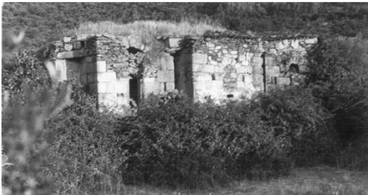
Fotografía 001: Conjunto descubierto. Vista de la Fachada Este con los tres ábsides. Las ventanas de los ábsides Norte y central, están completos, no así la del ábside Sur. Tras los muros de testero, con parte superior derruida, se observan las bóvedas completas y en pie (fotografía inédita cedida por Juan Rosco y M a Luisa Téllez)
