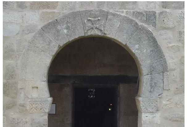
Fotografía 241: Arco de entrada a San Juan de Baños (fotografía del autor)
