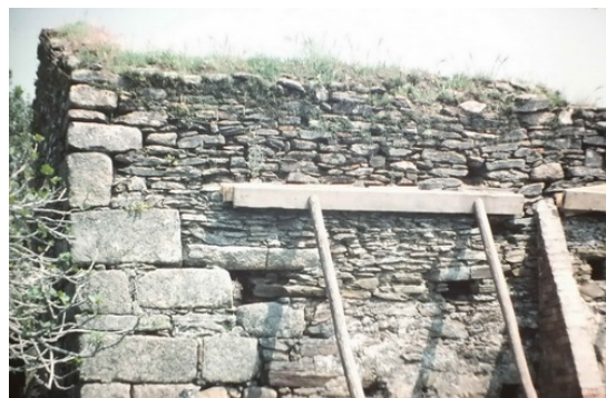
Fotografía 009: Apeo y contrafuerte de ladrillo, provisionales, para apoyo del muro Sur de la nave (fotografía inédita cedida por Juan Rosco y M a Luisa Téllez)
