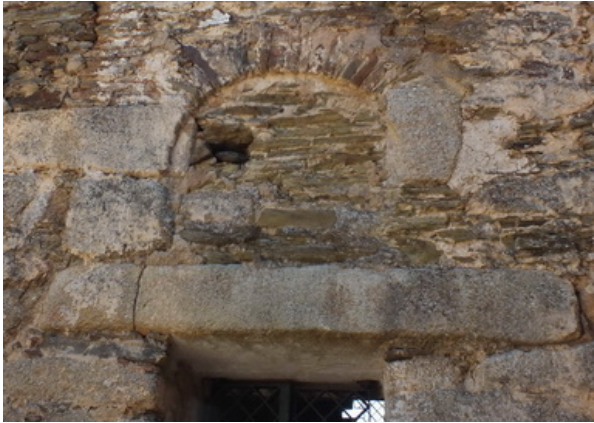
Fotografía 158 y 159: Arcos de descarga sobre las dos puertas de acceso a la nave desde los porches, y sobre las dos que comunican internamente las habitaciones laterales con los extremos del transepto, en los que se aprecia el retalle de la curva de los arcos de descarga sobre los sillares que se prolongan en altura sobre las jambas (fotografía del autor)
