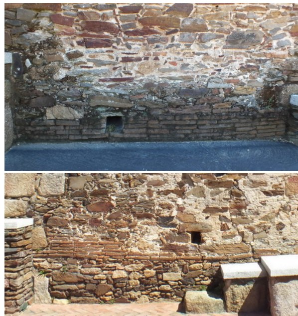
Fotografías 186 y 187 Muro lateral Norte y muro lateral Sur de la nave, entre las puertas laterales y el muro testero (fotografías del autor)
