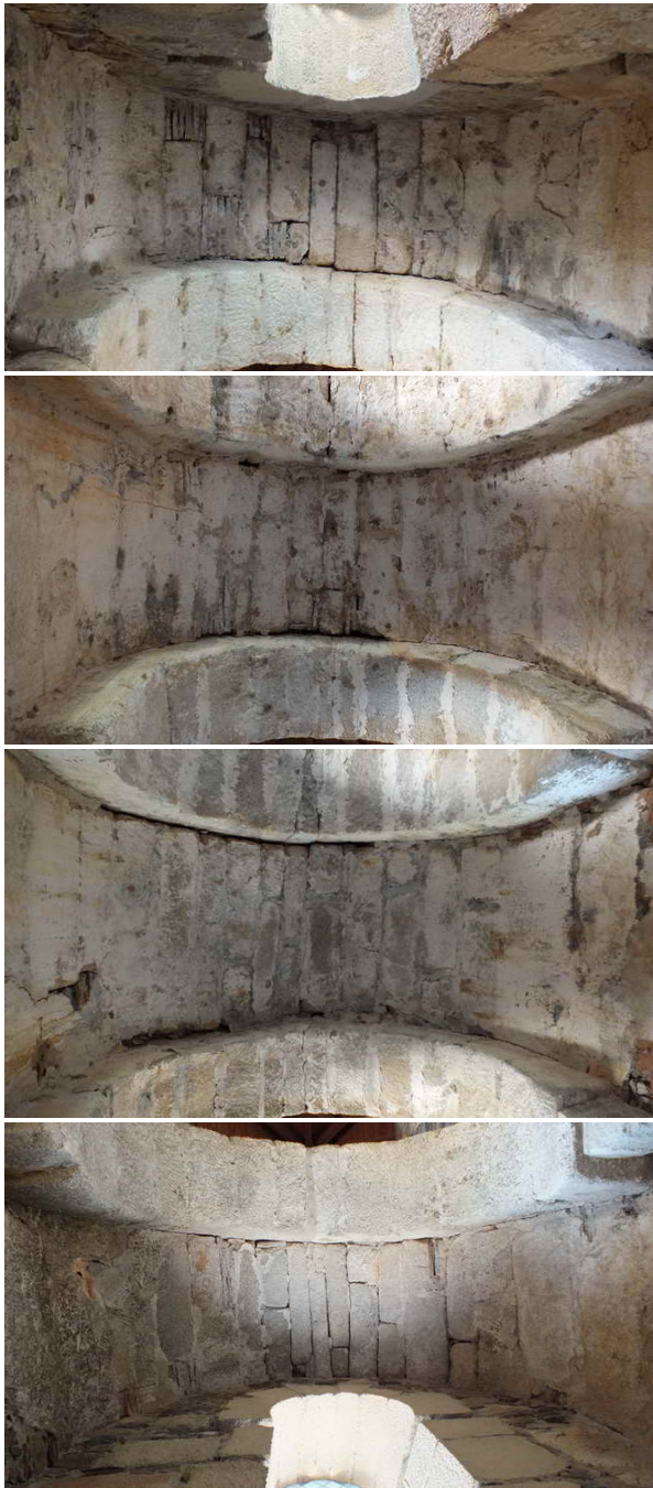
Fotografías 130, 131, 132 y 133: Secuencia Norte-Sur de las cuatro bóvedas del transepto, dos extremas y dos intermedias, rematadas en sus bordes por arcos independientes (fotografías del autor)
