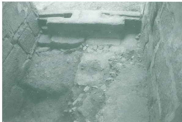
Fotografía 104: Durante los trabajos de restauración, bajo el umbral del ábside Centro aparece el cimiento reaprovechado de un muro anterior (lámina 65 del libro de CABALLERO y SÁEZ (1999))
