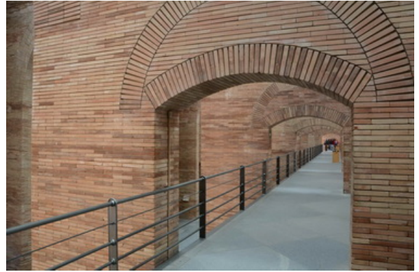
Fotografía 141: Interior del MNAR. Muros transversales de carga, con referencias directas al sistema constructivo romano (fotografía del autor)
