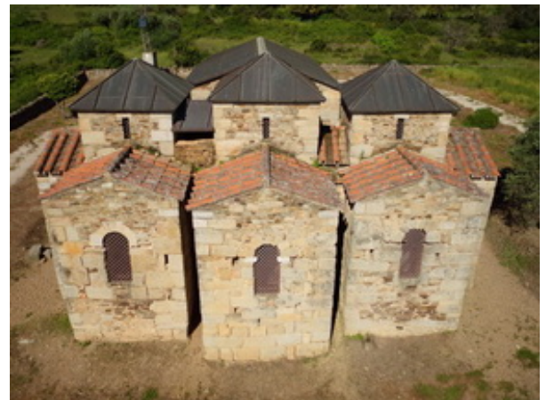
Fotografía 269: Singularidad de los tres ábsides con los tres cimborrios (fotografía de dron para el autor)
