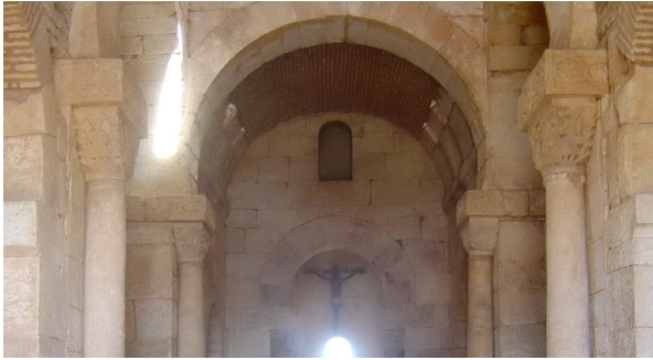
Fotografía 242: Cimacios bajo arcos del crucero, en San Pedro de la Nave (fotografía del autor)
