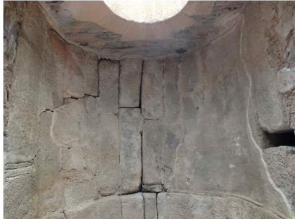
Fotografías 134, 135 y 136: Bóvedas de los tres ábsides, Norte, Centro y Sur, y encuentro con sus arcos de acceso correspondientes (fotografías del autor)
