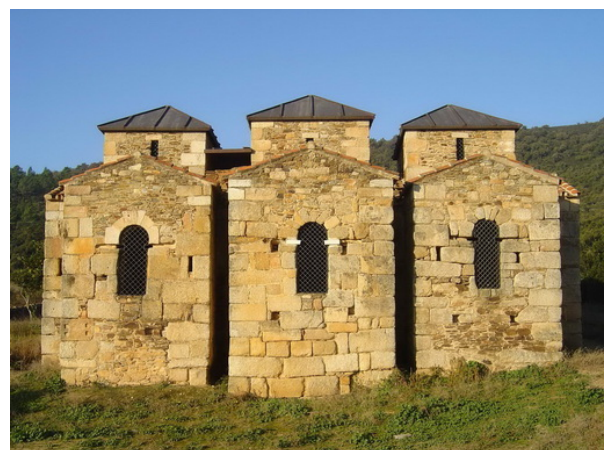
Fotografía 095: Alzado (fotografía del autor)
