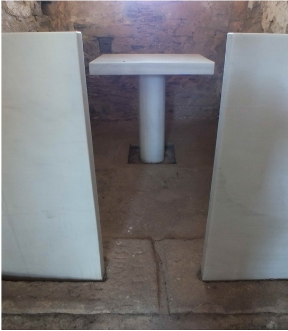
Fotografía 268: Vista del altar con tenante central único en ábside Norte, posible modelo para el ábside Sur, con el canal de desagüe en el umbral (fotografía del autor)
