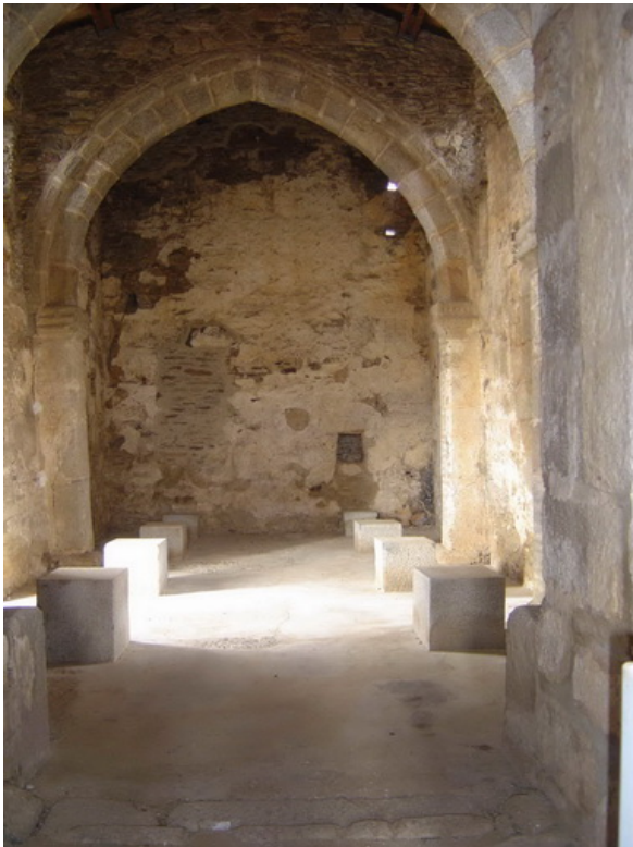
Fotografía 213: Nave central y laterales, remarcadas por arranques de pilastras sobre su cimentación, delimitando las tres naves, en Santa Lucía (fotografía del autor)
