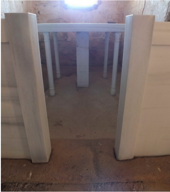
Fotografía 266: Vista del altar pentaapoyado del ábside Centro, con el canal de desagüe en el umbral (fotografía del autor)
