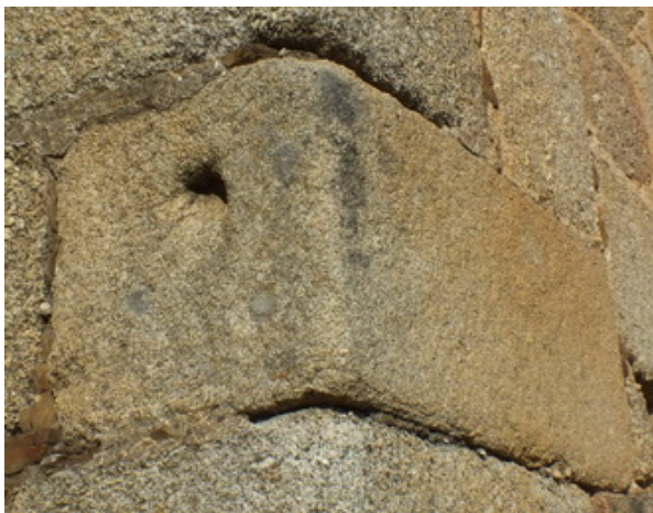
Fotografía 200: Sillar romano reaprovechado, con los signos de izado de los "ferris forceps" (fotografía del autor)
