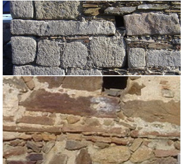
Fotografías 171 y 172: Muros de mampostería en los que mantiene la nivelación horizontal con alineaciones de piedras o ladrillos (fotografías del autor)
