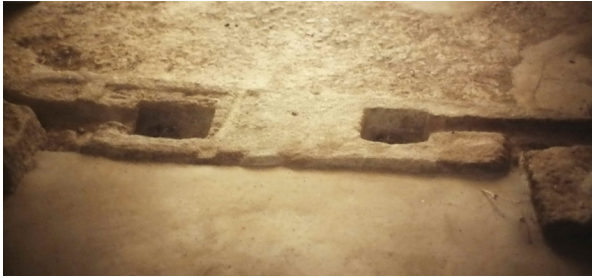
Fotografía 119: Entalladuras para encastramiento de los cancelles del ábside Sur. Véase la profundidad y perfilado en comparación con el umbral del coro (fotografía inédita cedida por Juan Rosco y Mª Luisa Téllez)
