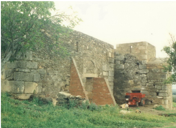
Fotografía 110: Vista de los muretes de arriostramiento mantenidos hasta la última restauración (fotografía inédita cedida por el Constructor, Antonio ABREU)
