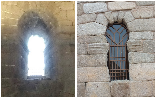
Fotografías 233 y 234: Ventana de extremo Norte del transepto de Santa María de Melque, desde el interior, en
