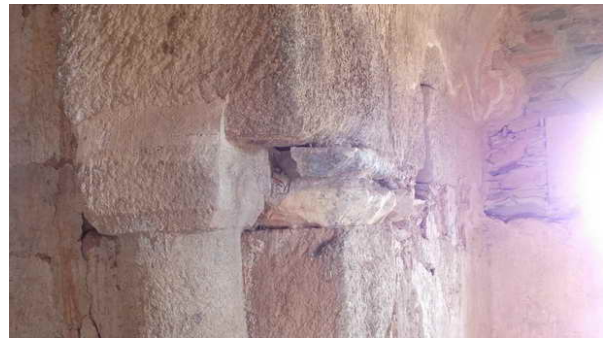
Fotografía 175: En las esquinas de encuentro entre los ábsides y el transepto, el encuentro de los cimacios respectivos se soluciona superponiendo ambos con su geometría intacta, y se hace coincidir el espesor del friso con el de los cimacios superpuestos, formando un único frente decorado de igual dimensión (fotografía del autor)
