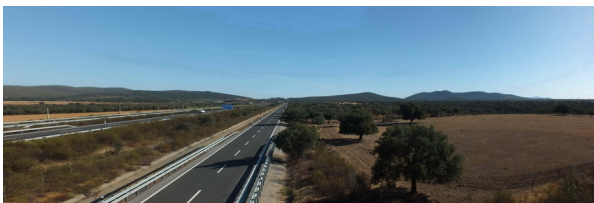
Fotografía 016: Autovía Ruta de la Plata (A-66) y la carretera de Extremadura EX-100, antes carretera nacional N-523, ambas hacia el Cruce de las Herrerías desde el Sur (fotografía del autor)
