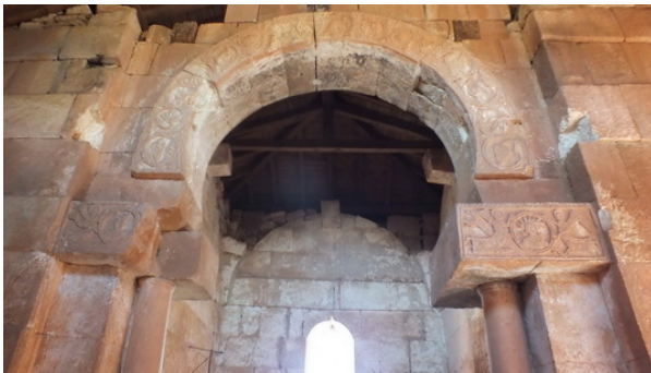
Fotografía 243: Cimacios bajo Arco del Triunfo, en Quintanilla de las Viñas (fotografía del autor)
