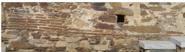
Fotografía 221: Mampostería en lado sur de nave, más irregular, con partes de siete hiladas y otras de dos e incluso una (fotografía del autor)
