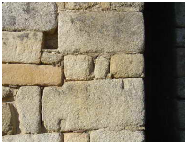
Fotografía 144: Sillares acodados, colocadas de la mejor forma posible para evitar nuevos trabajos de retallado (fotografía del autor)
