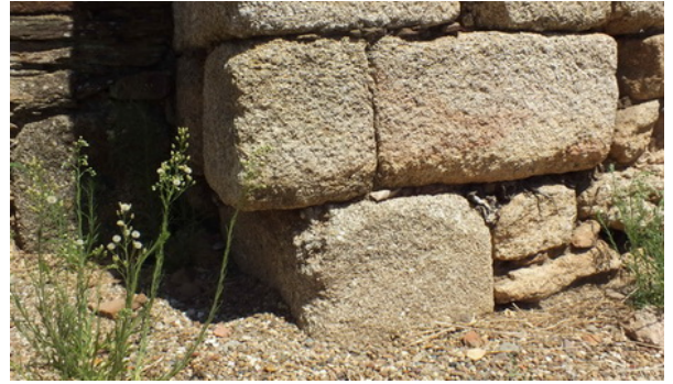
Fotografía 106: Esquina exterior Suroeste del transepto, en la que se aprecia que la hilada de base diverge de la alineación del muro que soporta (fotografía del autor)
