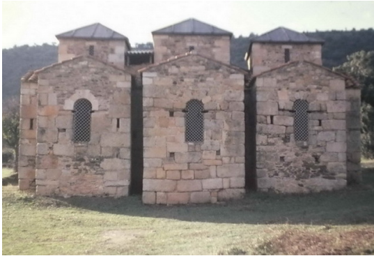
Fotografía 014: Remates de cubiertas y celosías en ventanas; aún no se ha incorporado el friso de mármol blanco en la imposta de la ventana del ábside central (fotografía inédita cedida por Juan Rosco y M a Luisa Téllez)
