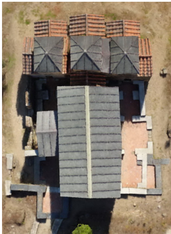
Fotografía 178: Plasticidad en los planos de fachada, en los que se va provocando una alternancia de entrantes y
