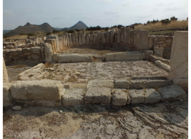
Fotografía 210: Coro de la Basílica de El Tolmo de Minateda, diferenciado perimetralmente por canceles y resaltado por un pavimento elevado (fotografía del autor)
