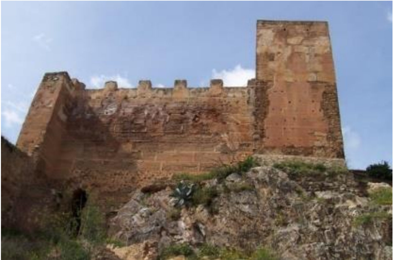
Figura 33. Fotografía de la Torre de los Pozos
