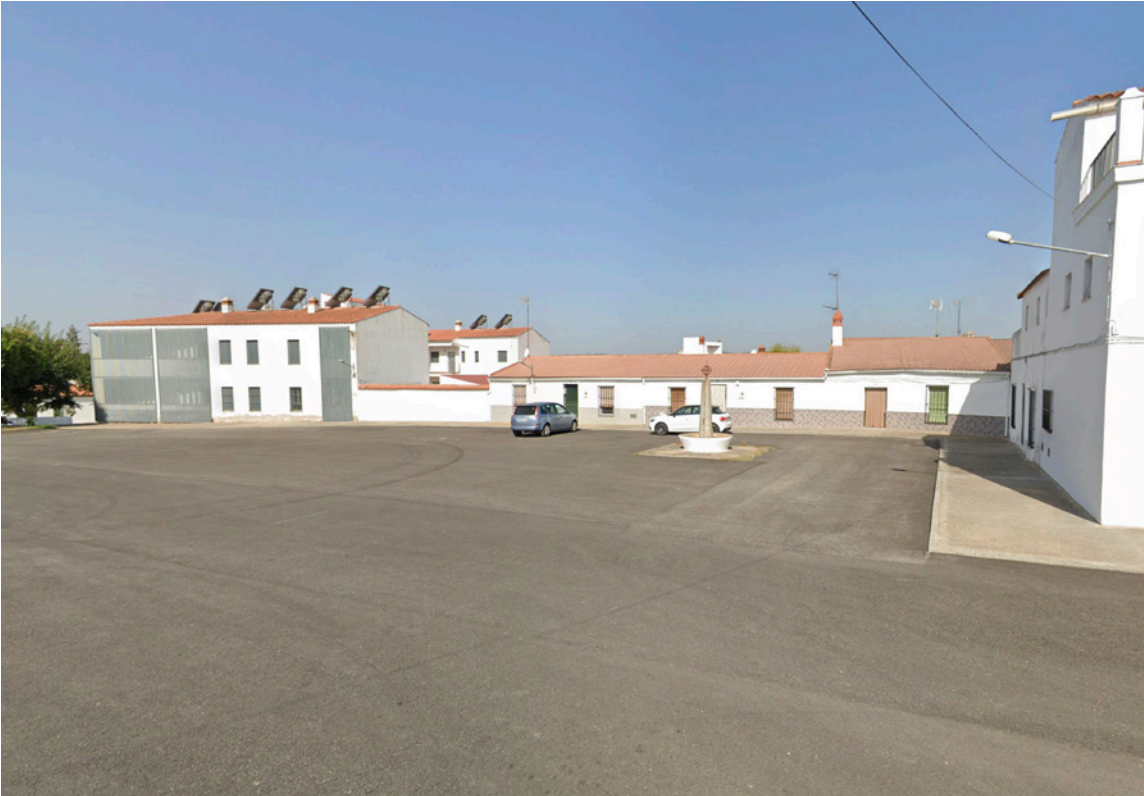
Figura 157.2. Vista interior de la Plaza del Pacífico convertida en aparcamiento tras su urbanización. Fuente: Google Street View (2022).
