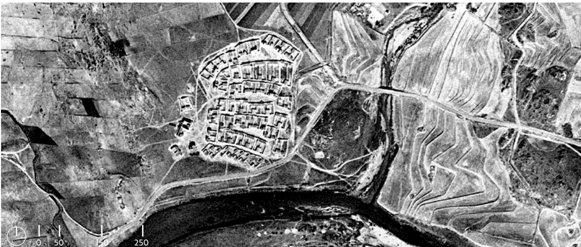
Figura 175. Pueblo de Colonización de Valuengo en el proceso de construcción del núcleo según Vuelo Americano en 1956 (Serie B 1956-1957). Fuente: Infraestructura de Datos Espaciales de Extremadura.
