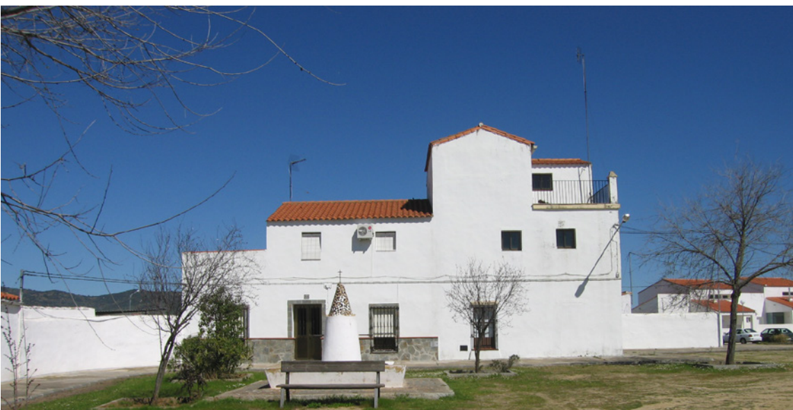
Figura 160. Vivienda de Colonización Agraria en la que se aprecia la ejecución de un zócalo y recercado de huecos mediante aplacado de piedra así como la instalación de una unidad exterior de climatización en fachada en la Plaza de la Conquista. Fuente: Rubén Cabecera Soriano.
