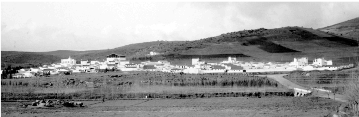
Figura 199.2. Vista general del Pueblo de Valuengo desde la carretera, al otro lado del Río Ardila. Fuente: Mediateca MAGRAMA.
