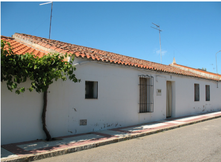
Figura 136. Viviendas para obreros agrícolas en 1958 (arriba) y en la actualidad (abajo) en la que se aprecia la demolición de todas sus chimeneas en fachada. Fuente: Mediateca MAGRAMA Rubén Cabecera Soriano.
