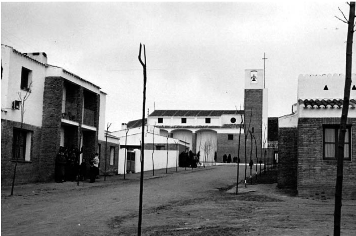
Figura 71.2. Vista de la iglesia y el Ayuntamiento en Belvis del Jarama desde el acceso al Centro Cívico. Fuente: Rafael Fernández del Amo.
