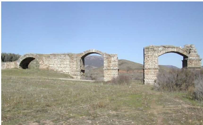
Ilustración 35: El Puente Mantible de Garrovillas. Imagen extraída de http://www.pueblos-espana.org/extremadura/caceres/garrovillas/267379/
