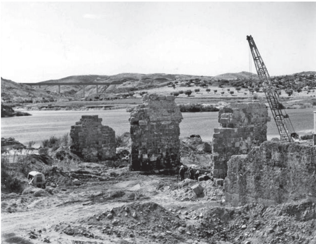
Figura 34. El puente de Alconétar durante el proceso de desmontaje de los pilares. A la izquierda se puede ver la desembocadura del Almonte y el nuevo puente construido para sustituir a los que en breve serían inundados por las aguas del embalse. Imagen de Luis Caballero Zoreda.
