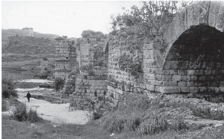
Figura 33. Vista del puente romano de Alconétar desde su cara norte. Se puede apreciar el detalle de los pilares, que tenían tajamar (rompeaguas) en ángulo en toda su altura para recibir la corriente del río. Al fondo la torre del castillo de Floripes, que controlaba el paso del puente al otro extremo. Fotografía de Wifredo López.
