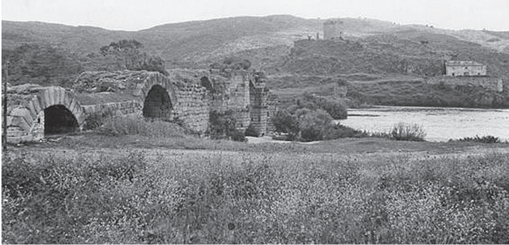
Figura 2. Puente romano de Alconétar sobre el río Tajo, antes de su traslado al cercano cauce del arroyo Guadancil, afluente del Tajo, con motivo de la construcción del embalse de Alcántara. Fotografía de 1969, donde se aprecian el puente y el castillo de Alconétar.
