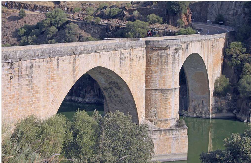
Figura 13. Puente de Almaraz sobre el río Tajo.
