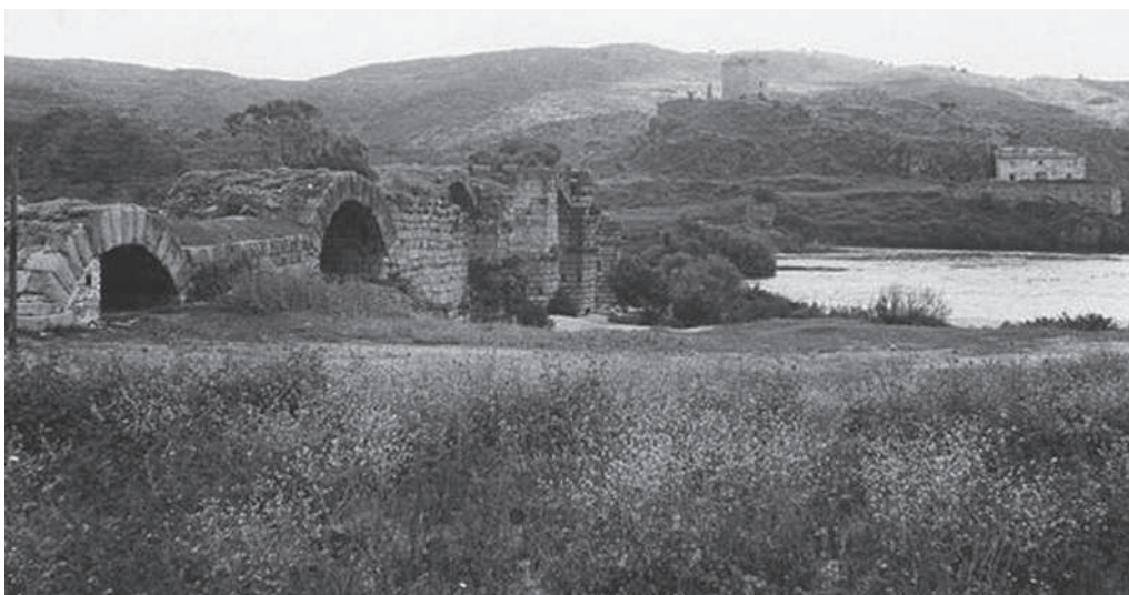
Figura 13. Puente romano de Alconétar sobre el río Tajo, antes de su traslado al cercano cauce del arroyo Guadancil, afluente del Tajo, con motivo de la construcción del embalse de Alcántara. Fotografía de 1969, donde se aprecian el puente y el castillo de Alconétar.
