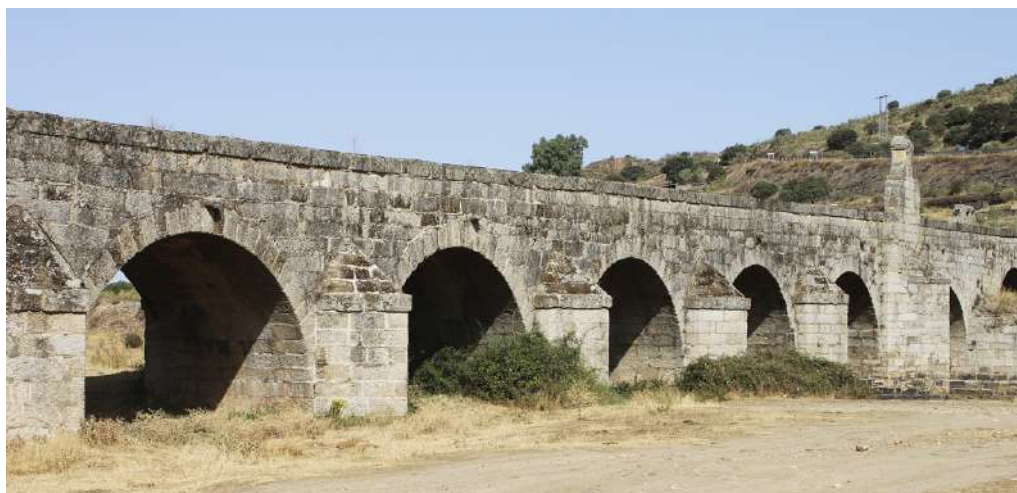
Figura 12. Puente sobre el río Almonte en Jaraicejo.
