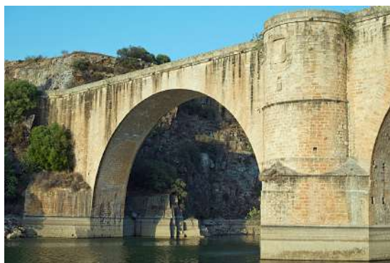
Figura 21. Puente de Almaraz sobre el río Tajo.
