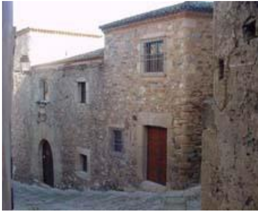
42. Fachada actual de la casa del Mono (MJT).
