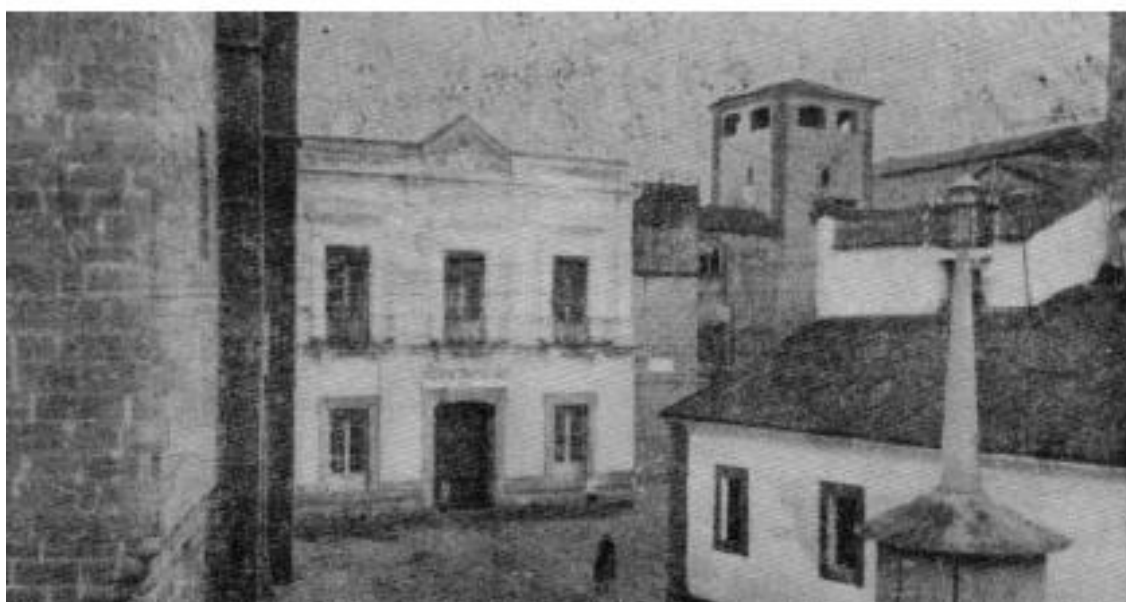
51. Plaza de Santa María hacia 1920. Se puede observar un irreconocible edificio de la Diputación y el transformador existente en el medio de la vía pública(AHMC).
