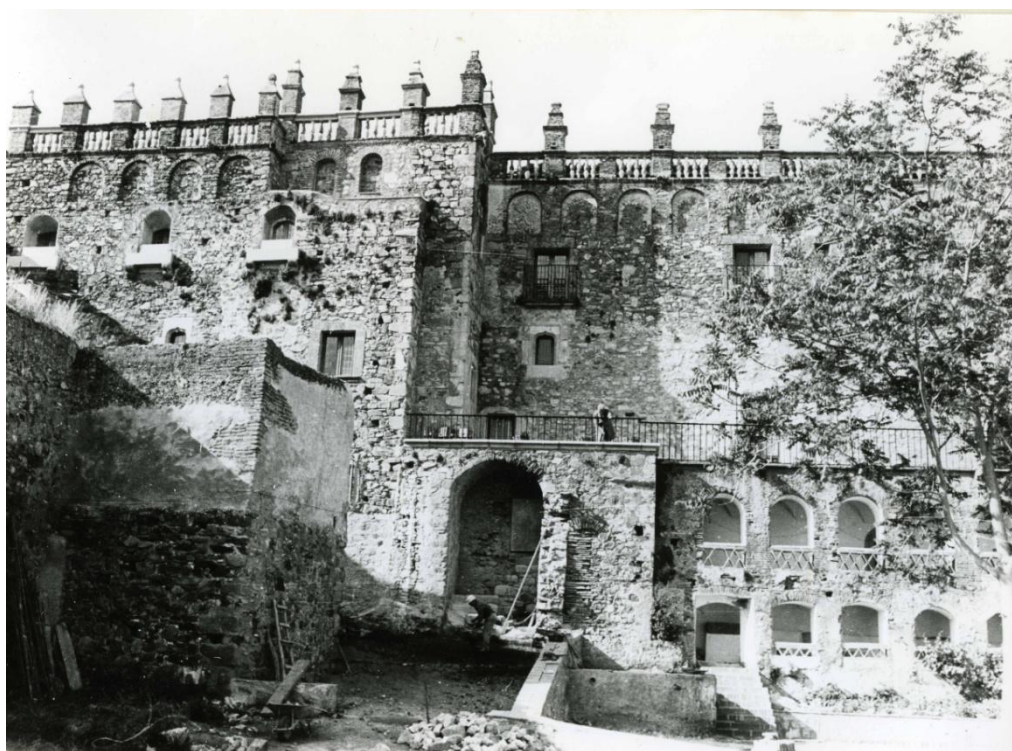
33. Estado del callejón del Gallo y la zona del jardín durante las obras (MC).
