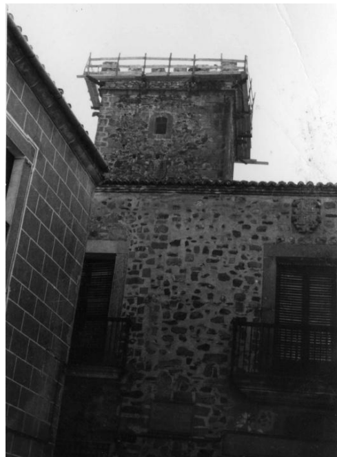
81 y 82. Estado de la torre antes de la actuación, que presenta un remate sin almenas y con balaustrada metálica. A la derecha, fotografía tomada durante el proceso de intervención en la torre, que supuso la reconstrucción de un almenado sin documentar, que probablemente nunca tuviera o fuera eliminado tras las ordenanzas concedidas por Isabel la Católica (AHMC).
