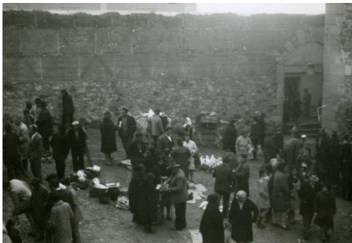
43. Zona del adarve correspondiente a las traseras del mercado. Este lienzo fue restituído con mampostería y cajones de tapial en 1953, bajo proyecto de J.M. González Valcárcel (AHMC).
