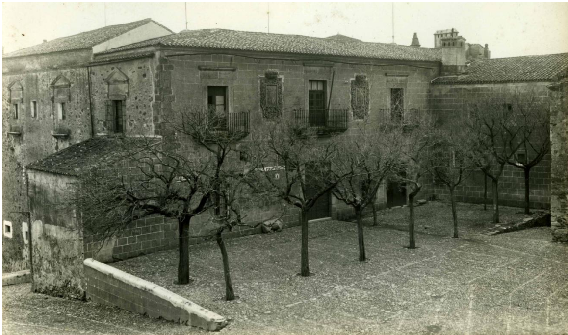
20. Fotografía de las Veletas hacia 1939. Observamos cómo los pináculos y la balaustrada cerámica no existen en esta zona del inmueble. Presenta un acabado de esgrafiado de sillería fingida en fachada y se aprecia a la izquierda el volumen eliminado en 1971 (AHMC).
