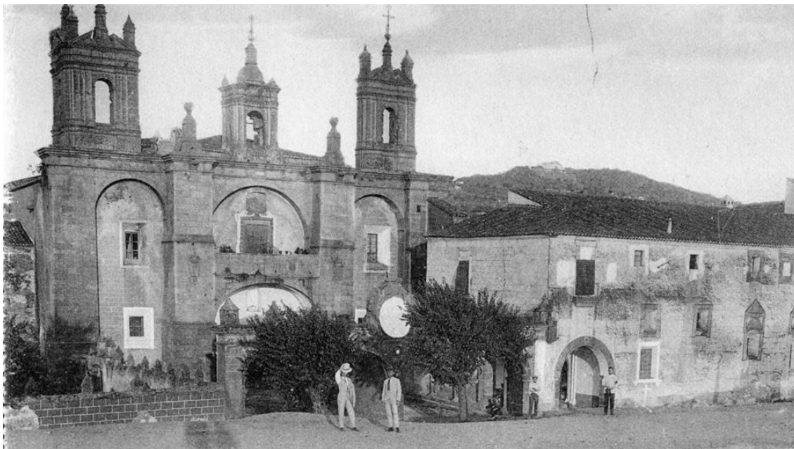
37. Monasterio de San Francisco c.1920. En la imagen se aprecia una fachada con vanos irregulares y desproporcionados, consecuencia de los diferentes usos albergados desde el siglo XIX (AHMC).
