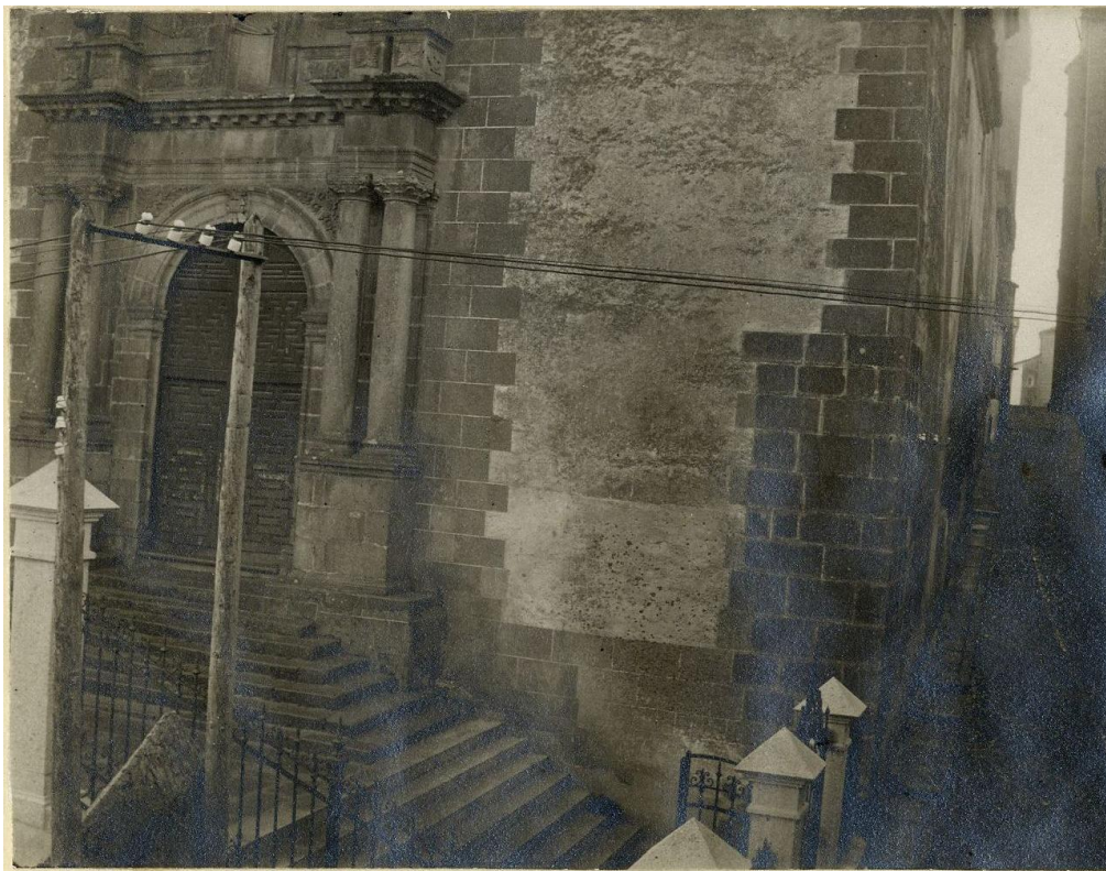
50. Obras para la instalación de una reja y una puerta en el atrio del Instituto (AGA).
