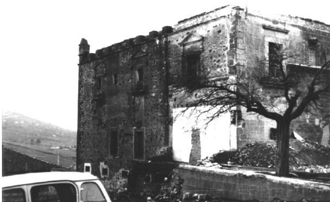
19. Imagen tomada durante el transcurso de las obras hacia 1971 (IPCE).
