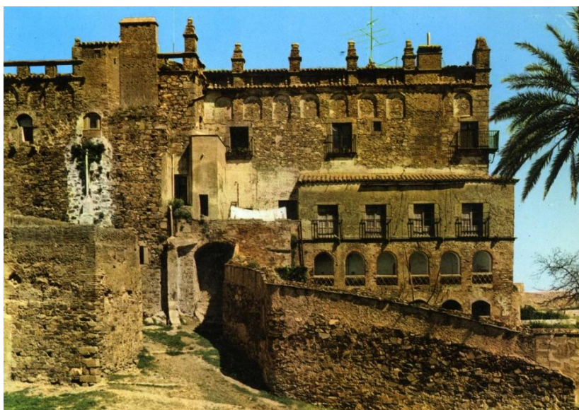
18. Estado de la fachada antes de las intervenciones. Se percibe cómo la balastrada de coronación se había diluido en alguna intervención efectuada en el tejado, así como la galería cubierta, que se convertía un añadido poco decoroso y desaparece, transformándose en una terraza(AHMC).
