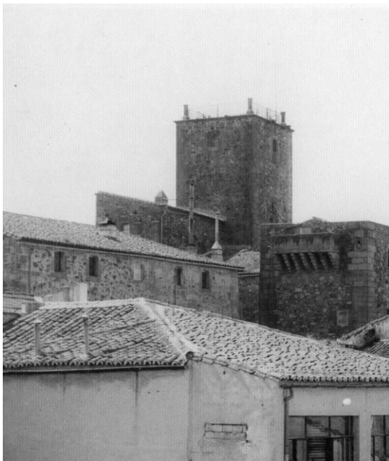
81 y 82. Estado de la torre antes de la actuación, que presenta un remate sin almenas y con balaustrada metálica. A la derecha, fotografía tomada durante el proceso de intervención en la torre, que supuso la reconstrucción de un almenado sin documentar, que probablemente nunca tuviera o fuera eliminado tras las ordenanzas concedidas por Isabel la Católica (AHMC).
