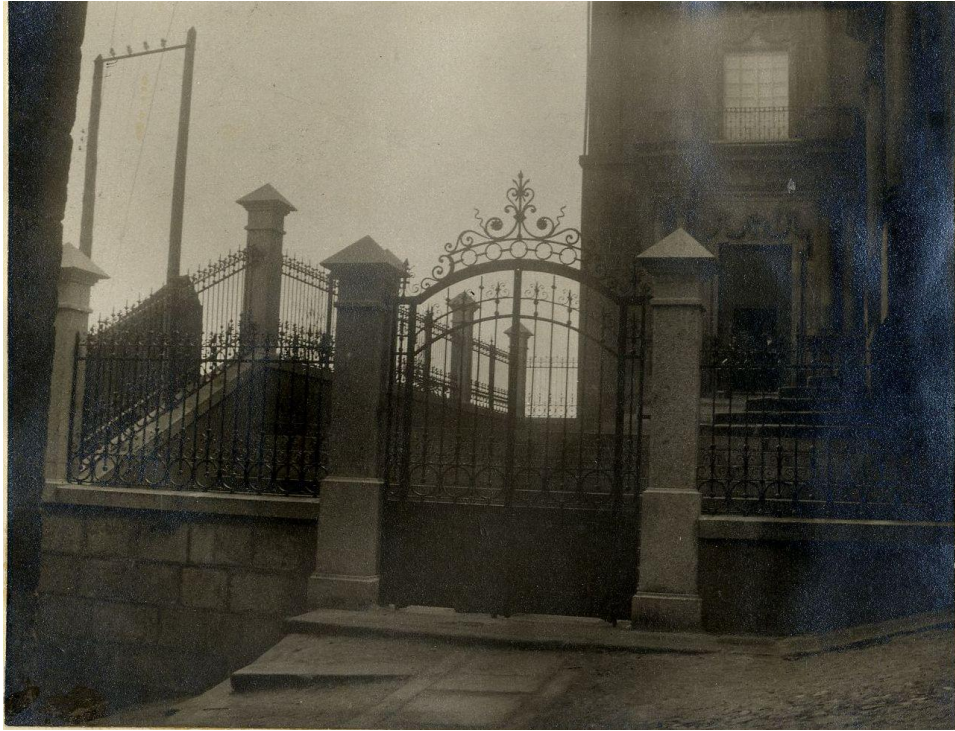
49. Nueva puerta instalada en el atrio hacia 1915 (AGA).
