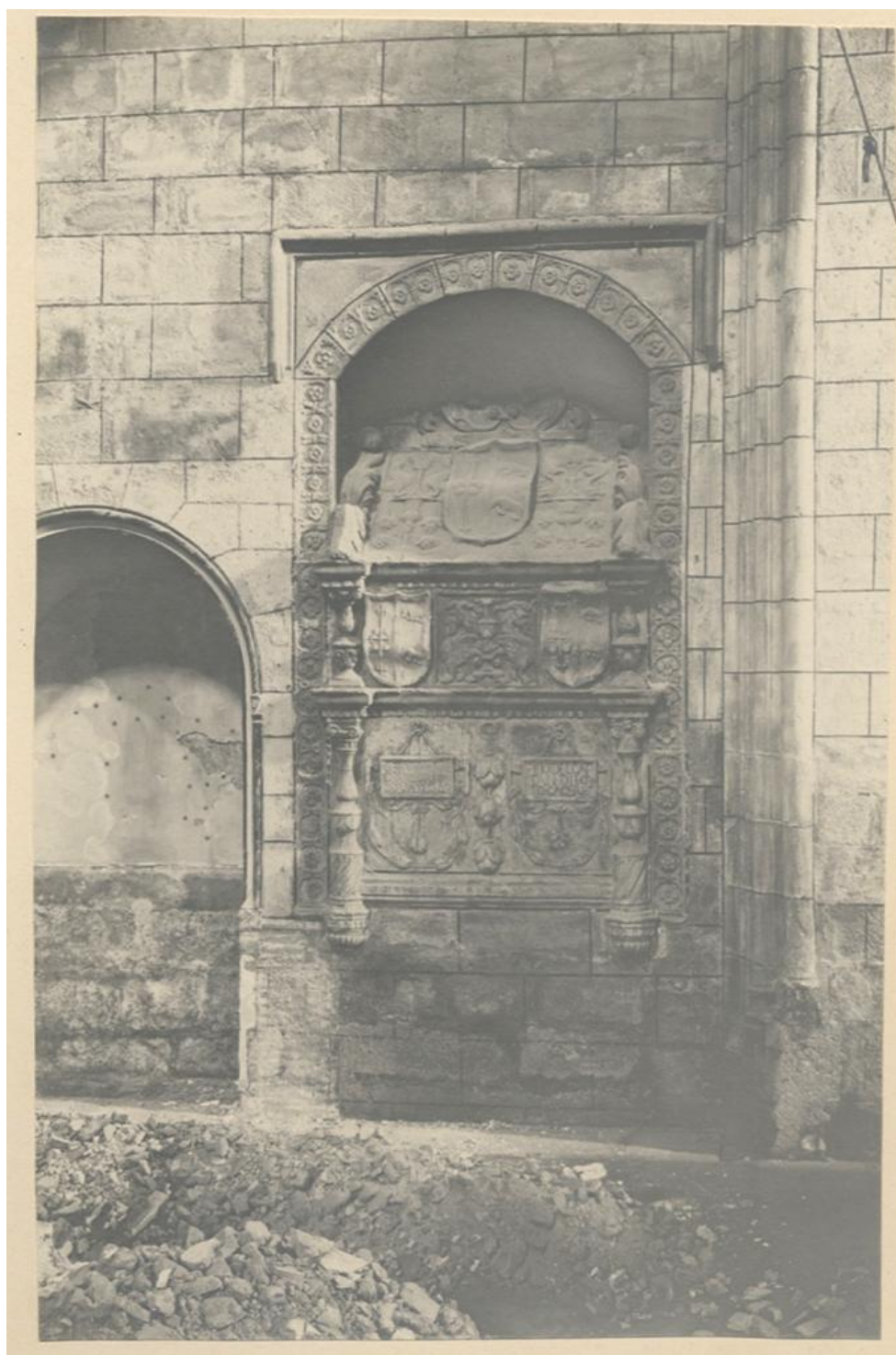
45. Fotografía del sepulcro de los Ovando, tomada por Julián Perate durante las obras de restauración. Se aprecia el revoco de imitación de sillería que cubría sus paramentos, encalado, que sería retirado décadas después. Atención merecen los escombros esparcidos por el suelo, que nos hablan de la dimensión de la obra (MC).
