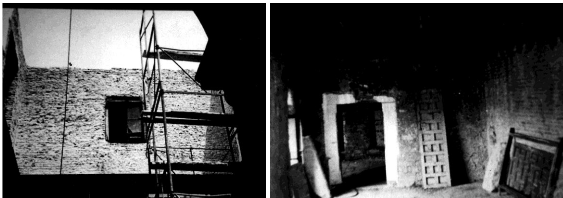
26 y 27. Imágenes tomadas durante la restauración del inmueble en 1971 (MC).
