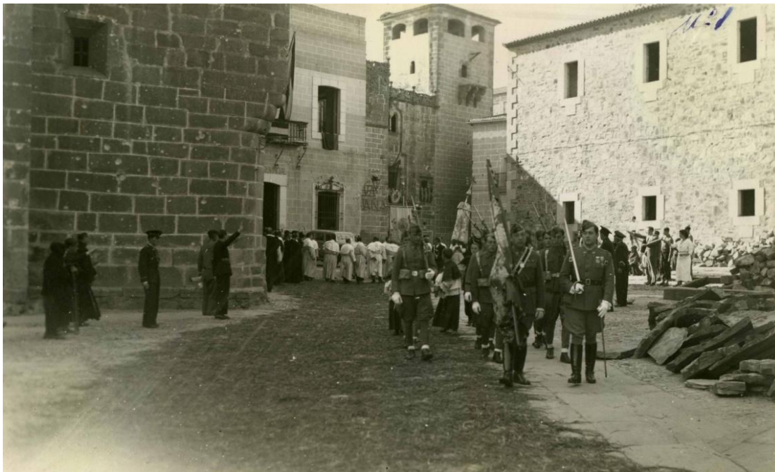
22. Fotografía tomada hacia 1940, en la que se aprecia una reciente intervención en la fachada de la Diputación Provincial, con materiales de diferentes cromatismos. En el pavimento se encuentran los escombros almacenados del palacio de Mayoralgo tras su bombardeo. Apreciamos asimismo la finalización del proyecto del palacio de los duques de Valencia, que siguió a rajatabla el esquema propuesto por el arquitecto municipal Ángel Pérez (AHMC).
