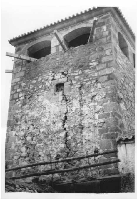
57. Estado que presentaba la torre de los Golfines de Abajo durante las obras de restauración (AHMC).
