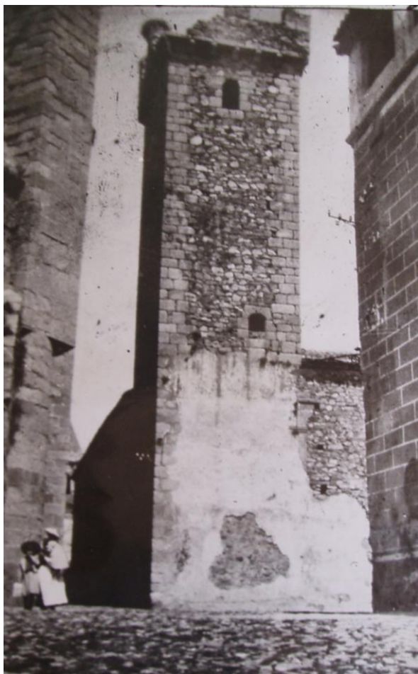
25. A la izquierda, el estado de la torre de las Cigüeñas en 1902; a la derecha, fotografía realizada para el Catálogo Monumental de Mérida, hacia 1915. Puede observarse el deterioro que sufrieron con el paso del tiempo las almenas (Marchena y Mérida).
