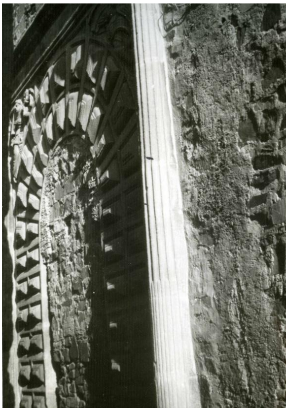
12. Puerta instalada en el palacio Episcopal en el verano de 1969 (AHMC).
