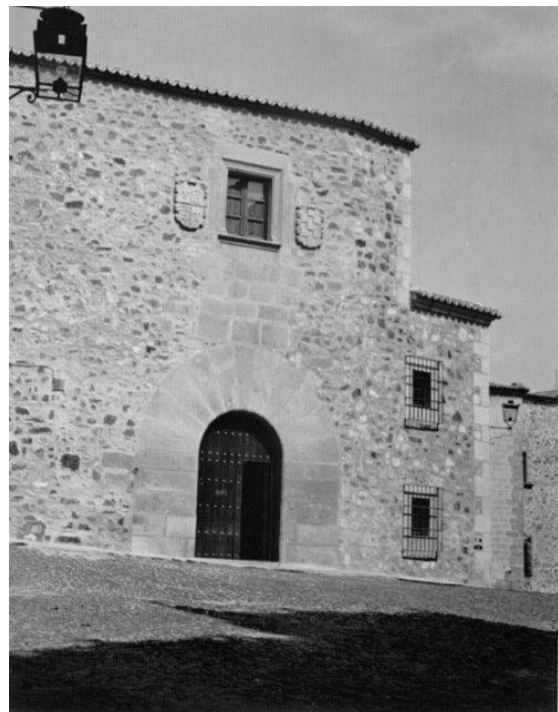
61 y 62. Estado anterior y reformado del inmueble. En la fachada principal se aprecia cómo fue rebajado el último piso, quedando significativamente mutilada y modificada la composición. (MC y MJT)
