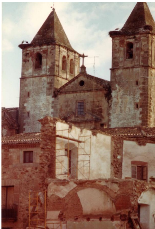
59. En primer plano, estado del inmueble durante las reformas. Se aprecia cómo se derribó gran parte de aquel para rebajar la altura del edificio en un piso, probablemente porque los tres niveles con que había quedado configurada la fachada resultaban desproporcionados (AHMC,).
