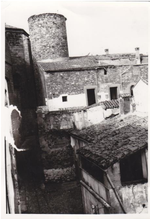
65 y 66. A la izquierda, estado de la torre y del patio interior antes de la intervención (MC). Se aprecia la irregularidad de la calle Amargura así como la desfigurada fachada del patio, con la cubierta hundida parcialmente. A la derecha se constata sutilmente el tapiado del balcón existente antes de la reforma, con la torre Redonda al fondo, así como la entrada temporal que existió hacia el patio.
