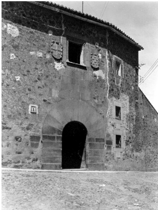
61 y 62. Estado anterior y reformado del inmueble. En la fachada principal se aprecia cómo fue rebajado el último piso, quedando significativamente mutilada y modificada la composición. (MC y MJT)
