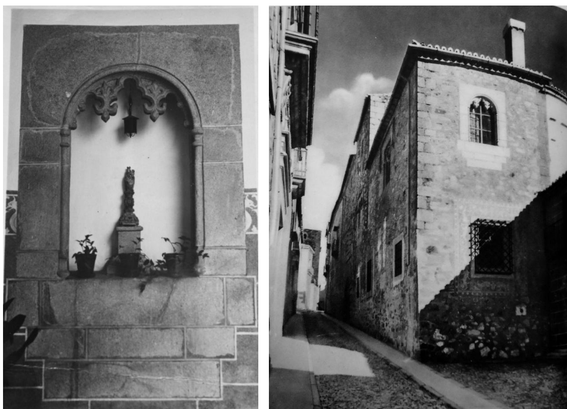
98. Imagen adjuntada al expediente de intervención en 1945, tomada por Javier. En ella se muestra la ventana que quería copiarse para ser instalada en la fachada del inmueble. Actuación que valió las felicitaciones de la Comisión de Monumentos. A la derecha (99) fotografía del libro de Muñoz de San Pedro de principios de los años 50, en la que se aprecia la blanca cantería de la ventana neogótica añadida. En la actualidad la ventana pasa desapercibida por la pátina del tiempo (Javier).
