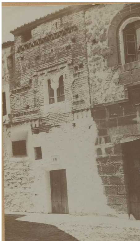
23 y 24. Ampliación de la ventana abierta en el friso mudéjar. A la izquierda se observa la existencia de un pequeño vano, justo en el límite izquierdo de la imagen, que se transforma a la derecha en un historiado arco de herradura de grandes dimensiones. (MC; conde de Canilleros).
