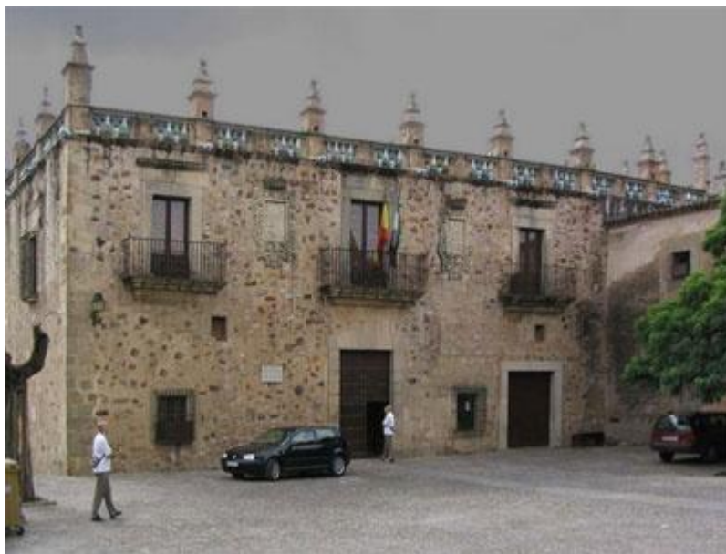
21. Estado actual del Museo de las Veletas. Observamos la cubierta rematada por pináculos y balaustres cerámicos. Se aprecia también el aditamento de la nueva cantería en las jambas y dintel del amplio portado derecho de fachada, cuyo cambio de tonalidad habla por sí mismo, si bien el vano sí existió por entonces. También se eliminaron los árboles que precedían a la fachada, quizá para despejar la contemplación del conjunto (MJT).
