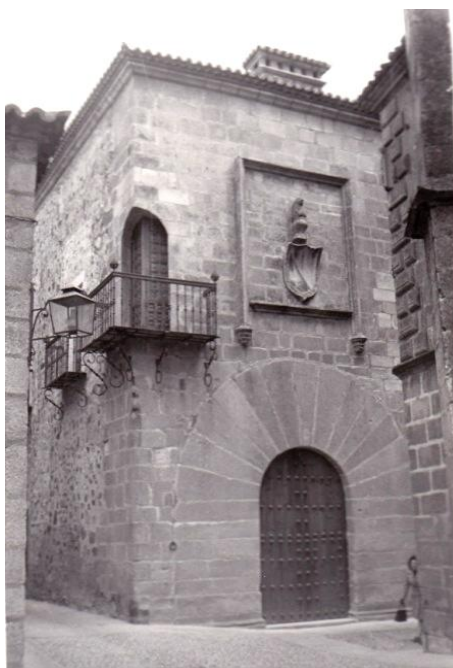
64. Estado del inmueble antes y después de su restauración en 1970. En la fachada se aprecia el tapiado de un vano, existente junto al alfiz. Pavimento y cornisa también fueron restaurados (MC; AHMC).
