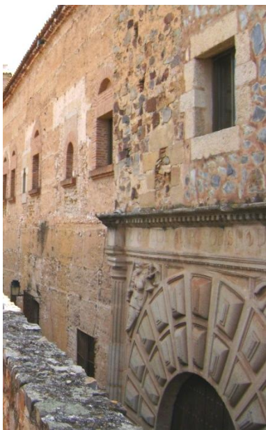
13. Estado actual de la fachada. En el muro se aprecian los vanos tapiados y añadidos, así como los cambios de fábrica (MJT).
