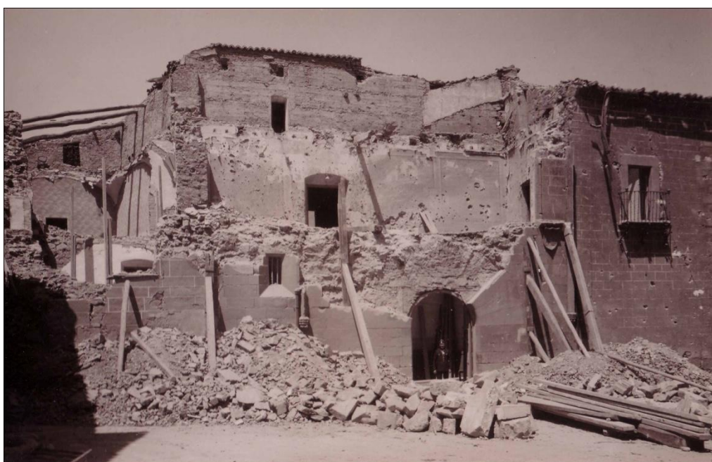
5. Estado del inmueble tras el bombardeo del 23 de julio de 1937. Observamos la destrucción de la mayor parte de su fachada y el apuntalamiento de urgencia realizado para mantenerlo en pie (AHMC).
