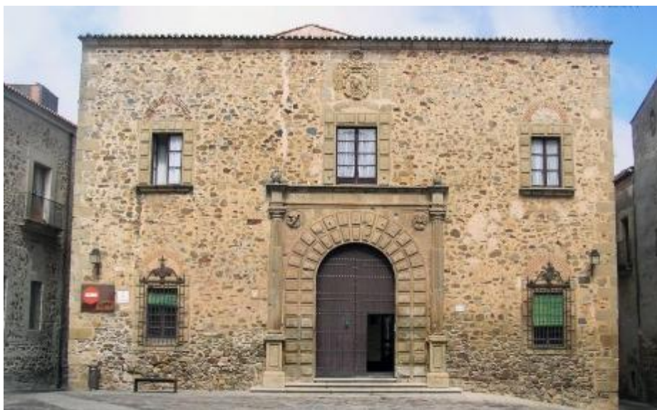
9. Palacio Episcopal en la actualidad, ubicado en la plaza de Santa María (MJT).
