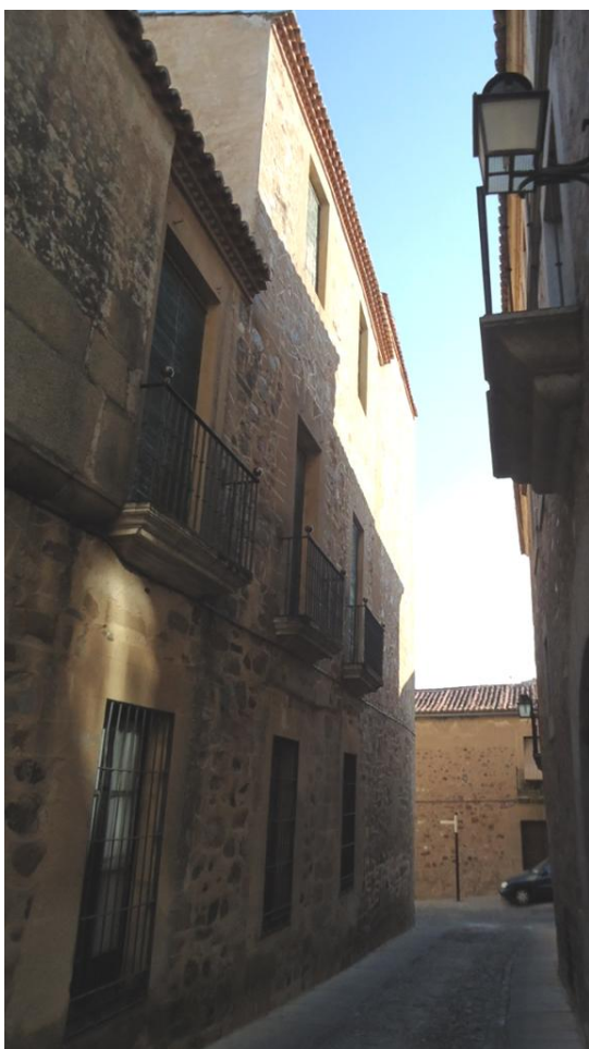
14. Fachada en la que originalmente se encontraría el acceso al palacio de los Sánchez Durán (MJT).
