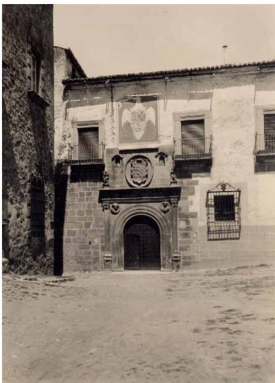
8. Palacio de Ovando. Debemos resaltar una peculiaridad de su fachada, pues presenta sus vanos de forma desalineada en planta baja y principal. Esta circunstancia quizá anuncie una modificación o añadido en época incierta, pero en cualquier caso muy anterior a nuestra época de estudio. (MC).
