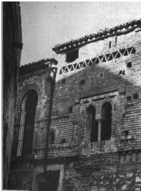
23 y 24. Ampliación de la ventana abierta en el friso mudéjar. A la izquierda se observa la existencia de un pequeño vano, justo en el límite izquierdo de la imagen, que se transforma a la derecha en un historiado arco de herradura de grandes dimensiones. (MC; conde de Canilleros).
