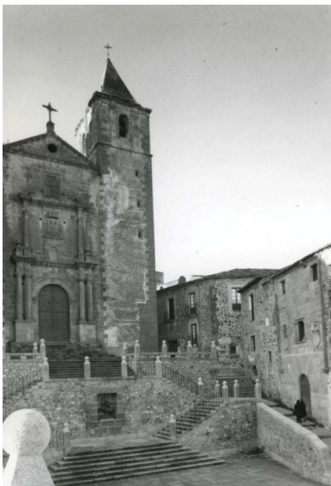
216. Plaza de San Jorge en 1966, tras la finalización de las obras (AHM C).
