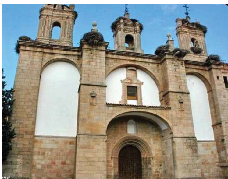
90 y 91. Fachada principal de la iglesia, durante el primer cuarto del siglo XX y tras su restauración en la década de los 70. Se aprecia la desaparición del balcón central y el cegado de los vanos laterales, a nuestro juicio acción desafortunada por alterar ostensiblemente el diseño de la fachada (AHMC; MJT).
