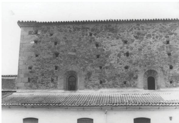
99. Estado exterior de la nave central. En la fachada se percibe con detalle el mal estado en el que se encontraba la cubierta, con zonas que presentaban teja árabe y el resto con uralita o fibrocemento. A la derecha, (100) estado precedente de la espadaña, bastante deteriorada, que también fue objeto de la intervención (AGA).
