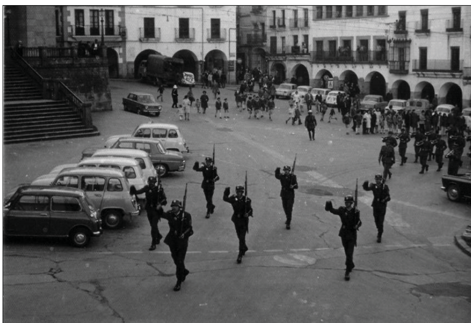
231. Pavimento de la plaza Mayor antes de su intervención, en los años 60 (AHMC).
