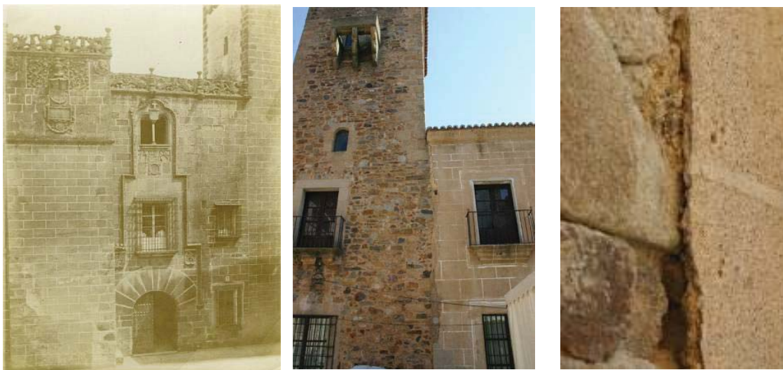
274. Palacio de los Golfines de Abajo. A la izquierda observamos el inmueble con anterioridad a 1967, en cuya completa fachada se aprecia el esgrafiado de sillería fingida. En el centro contemplamos la situación del inmueble en la actualidad, quedando manifiesta la ruptura de la torre con el resto del inmueble, que en el caso de la torre muestra la mampostería vista mientras que en el resto del edificio su mampostería está cubierta por el esgrafiado. A la derecha un detalle del salto entre una y otra zona y la escasa lógica constructiva con la que cuenta la acción restauradora de Valcárcel (AHMC;MJT)
