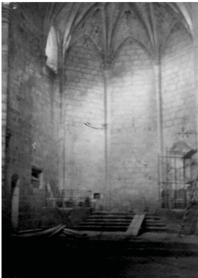
84. Interior de la iglesia durante las obras de restauración (IPCE).
