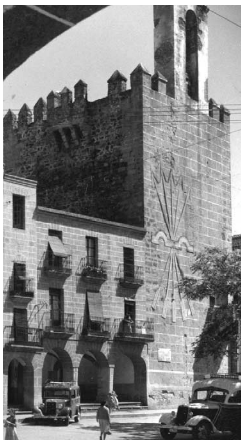
163 y 164. Torre de Bujaco antes y después de la intervención de los años 1962-63. El templete añadido desaparece y se elimina el revoco de sillería fingida, que genera una imagen muy diferente de la torre (AHMC).
