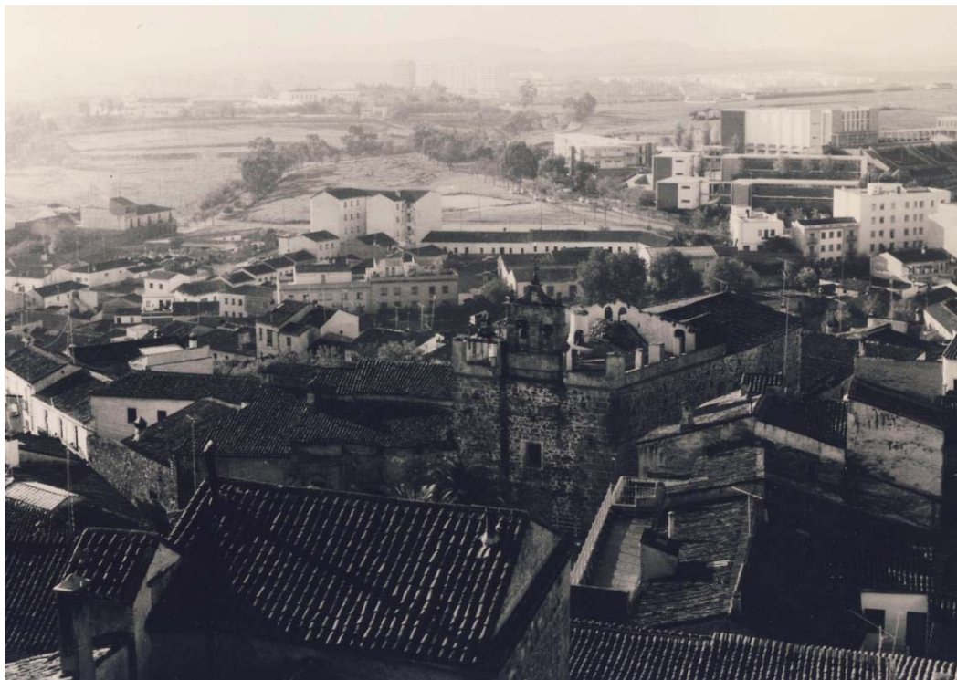
61. Vista de la cubierta de Santa Clara durante las obras (AHMC).
