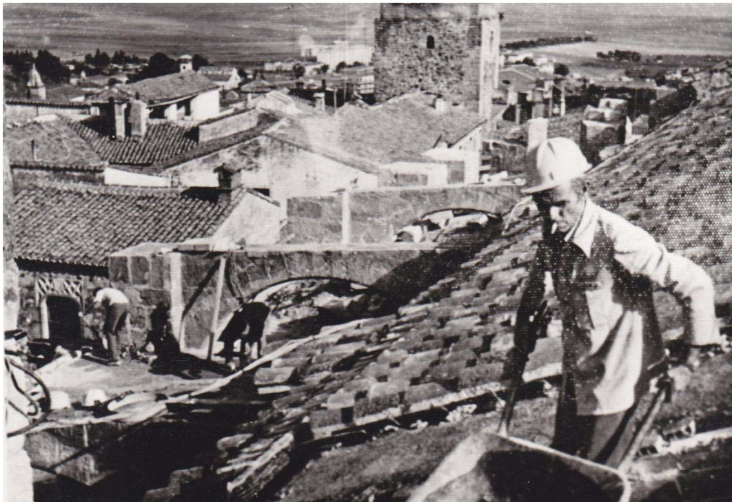
23. Obras de restauración de la cubierta de Santa María, hacia 1973 (AHMC).
