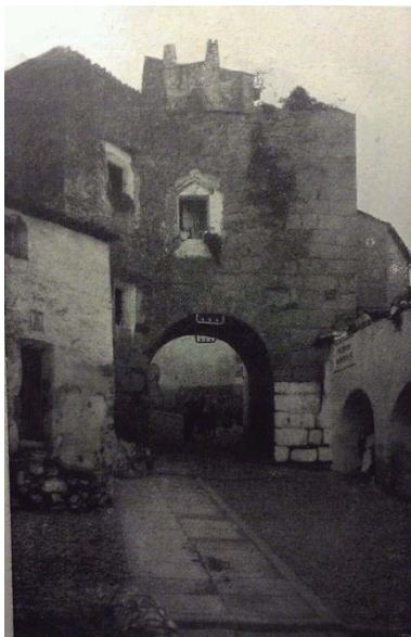
188. Arco del Cristo en una imagen tomada hacia 1900, en la que se observan las construcciones existentes al Sur (Portofolio Fotográfico).
