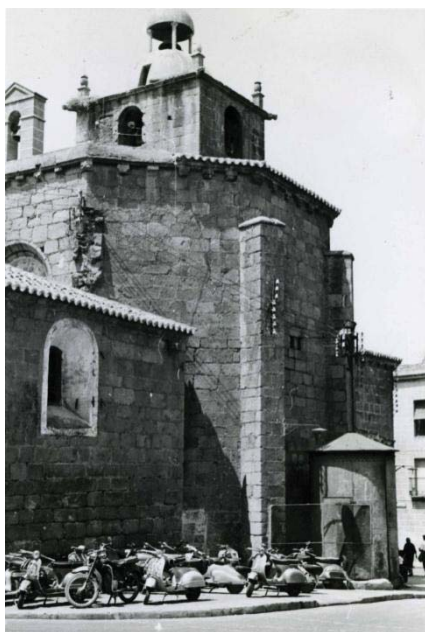
223. Foto de la cabecera de la iglesia con el transformador, tomada en 1960 (AHMC).
