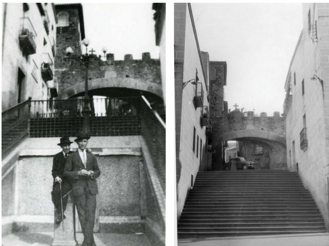
238 y 239. Antes de la intervención, la escalera contaba con un doble brazo. Fue eliminada en 1950 y sustituida por escalones de granito corridos(AHMC).
