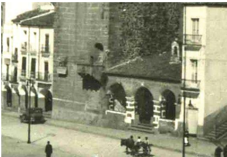
36. Ermita de la Paz hacia 1932. Se aprecia el basto llagueado que cubría las juntas de los sillares de su pórtico. Este fue sustituido por un esgrafiado de sillería fingida, (AHMC).
