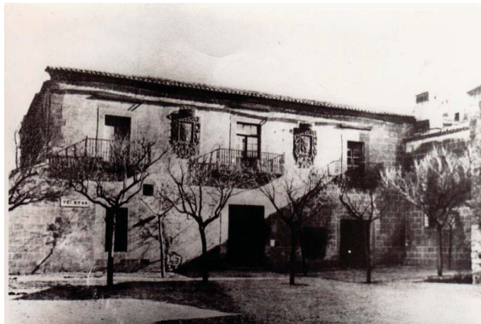
220. Fachada principal del Museo de las Veletas. Configuración del espacio público que pretendía reformarse. A la izquierda se observa el volumen desaparecido en 1971 (AHMC).
