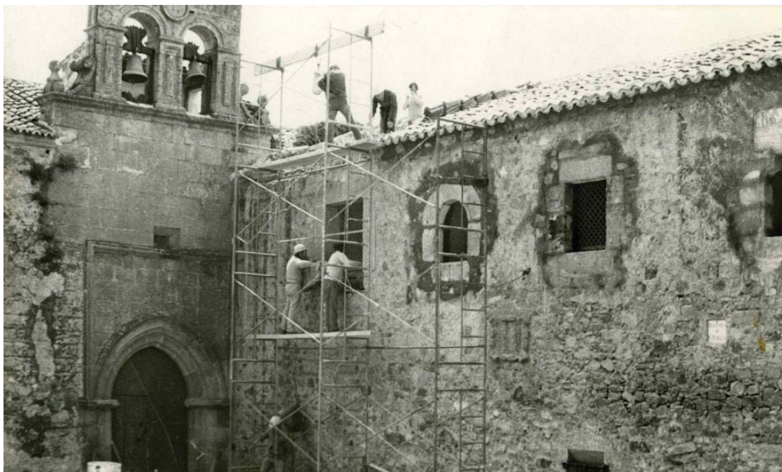
75. Esta imagen recoge los trabajos realizados en el convento hacia la década de 1970, cuando se procedió al arreglo de vanos y el retejado del locutorio (AHMC).
