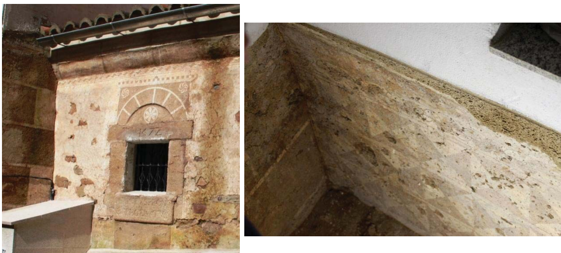
51 y 52. Estado actual del exterior e interior de la ermita, que desvelan los esgrafiados originales de sus muros, eliminados en diversas restauraciones. Aparecieron en la intervención practicada en el año 2010 (MJT).
