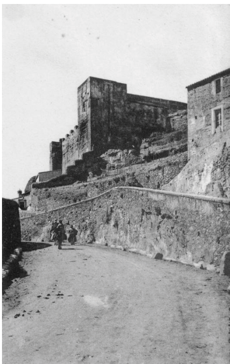
154. Baluarte de los Pozos antes de su intervención (AHMC).
