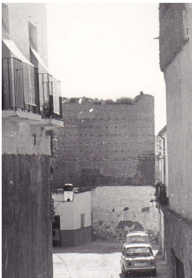
144. Fotografía tomada hacia la década de 1960 en la que se aprecia una torre restaurada, pues es notable el cambio cromático del tapial (AHMC).
