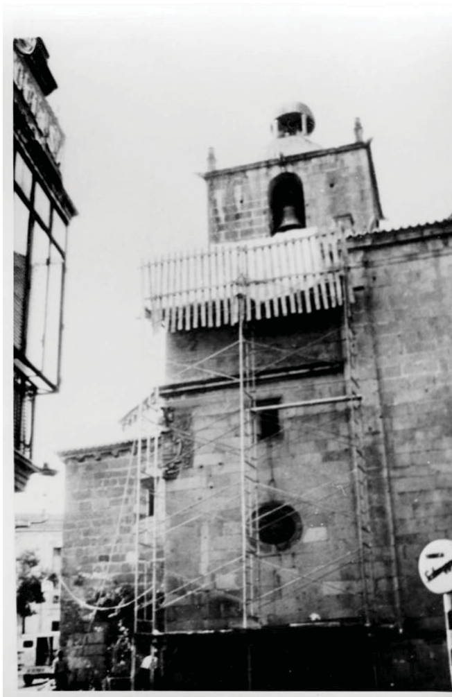
34. Imagen tomada durante las obras que supusieron la eliminación del recrecido sobre la capilla (IPCE).
