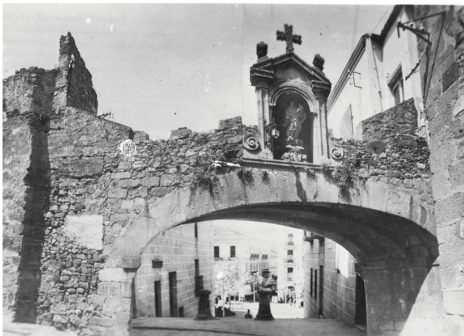
162. Estado del arco del Cristo con anterioridad a 1963. Nótese el esgrafiado de sillería fingida, que sitúa la fotografía con posterioridad a 1937, así como la presencia del volumen en 'L' que rodea a la ermita, que desaparece con este proyecto. Puede apreciarse la casi total ausencia de los merlones que coronaban el arco, repuestos con toda probabilidad en estos años, cuando se arregla el camino de ronda y la torre de Bujaco (Col. particular).
