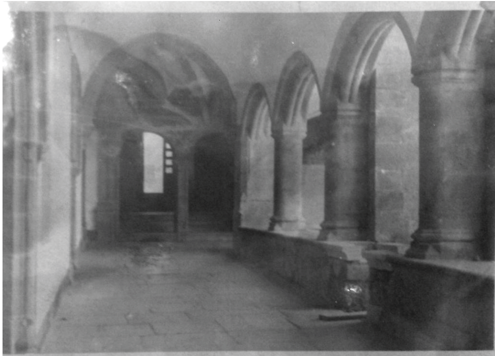
87. Interior de San Francisco antes de las reformas (ICPE).
