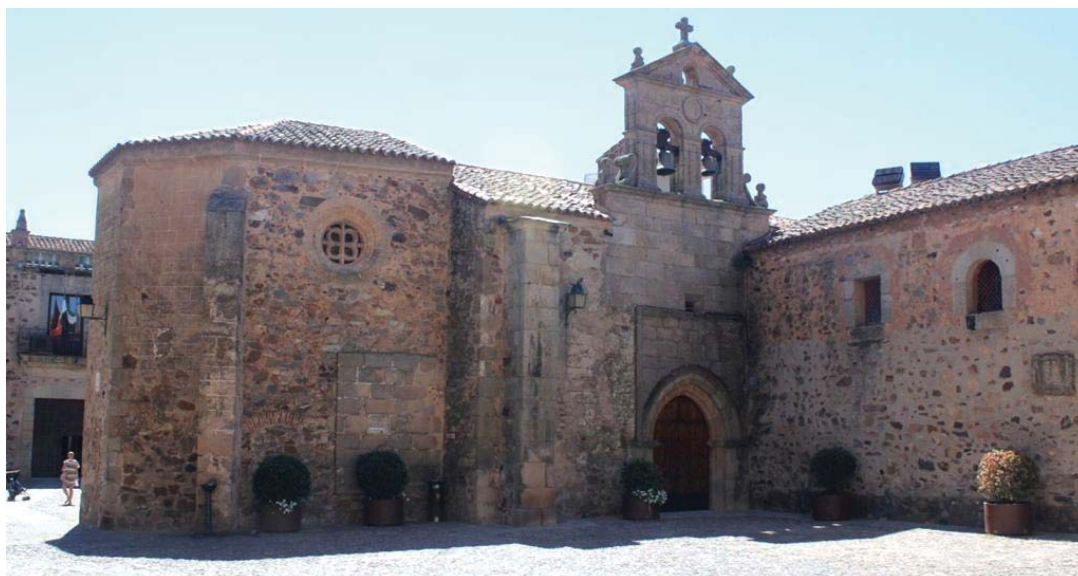
74. Estado actual de la fachada de la iglesia y locutorio del convento de San Pablo. Se aprecia el nuevo rosetón –con un evidente variación cromática en su cantería que pondría en evidencia el añadido-, los volúmenes eliminados y la desaparición del esgrafiado ( www.grego.es ).
