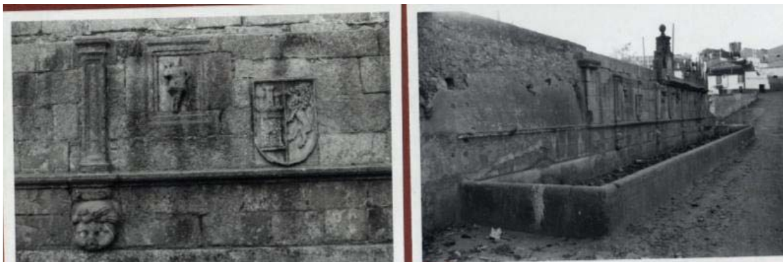
249. Estado de los diferentes elementos que fueron introducidos en el solar en 1970. A la izquierda detalle del pilar de San Francisco, que aparece a la derecha en su emplazamiento original.
