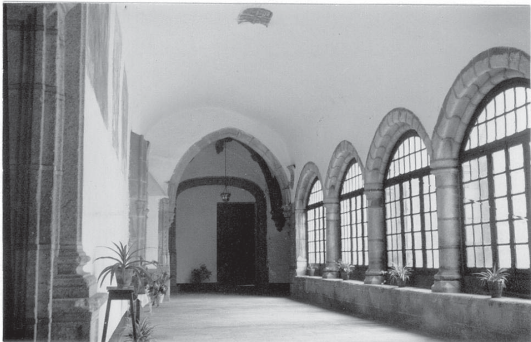
88. Claustro del monasterio antes de la intervención. Se aprecia el acristalamiento de sus vanos (MC).
