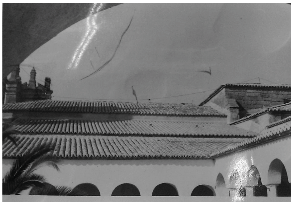
86. Estado de la cubierta de la iglesia tras su restauración (IPCE).
