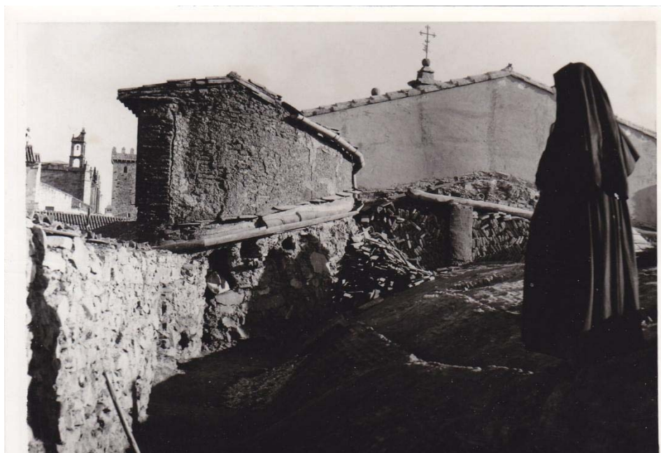
59. Obras en la cubierta de Santa Clara (AHMC, obras).
