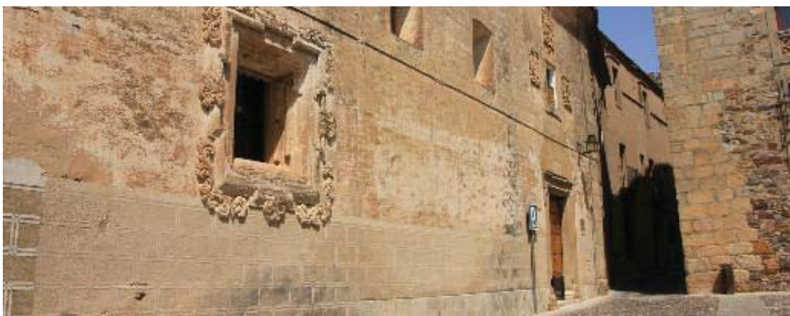
266. Fachada de la enfermería de San Antonio, en la que se aprecia una interesante decoración de doble encintado, esgrafiado mantenido en la restauración de los años 70 (MJT).
