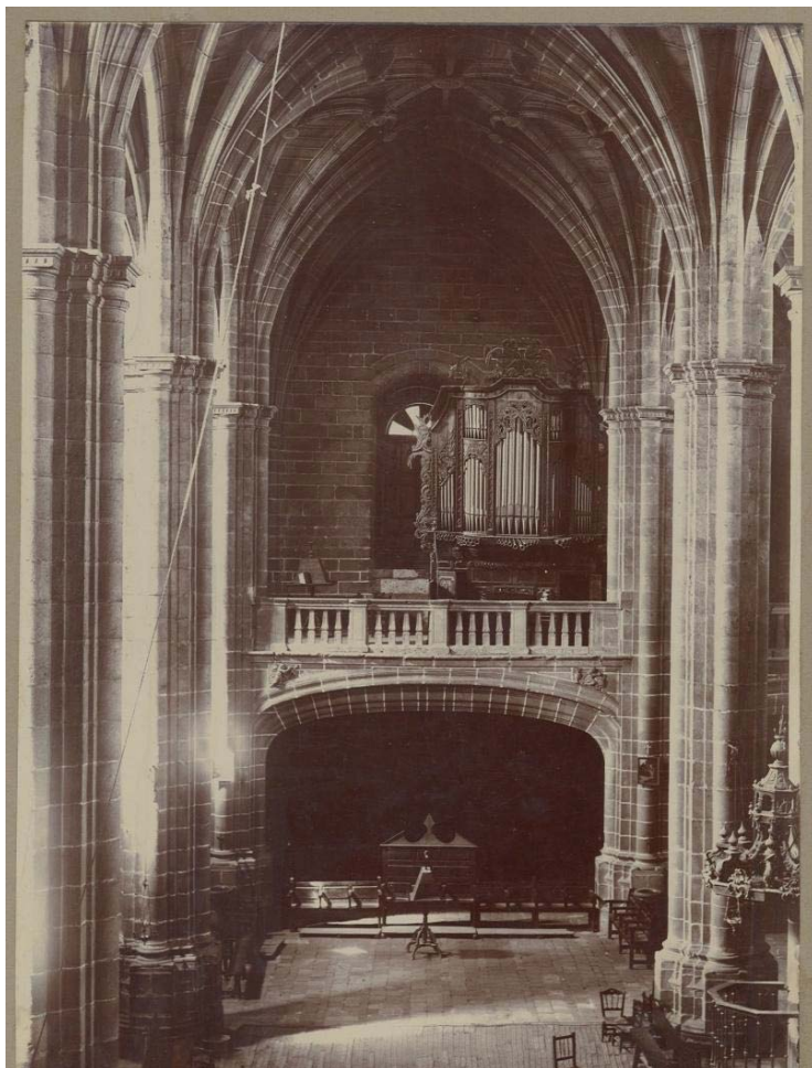
9. Interior de Santa María hacia la década de 1910. Se percibe el revoco que cubren sus muros, que sería retirado posteriormente(MC).
