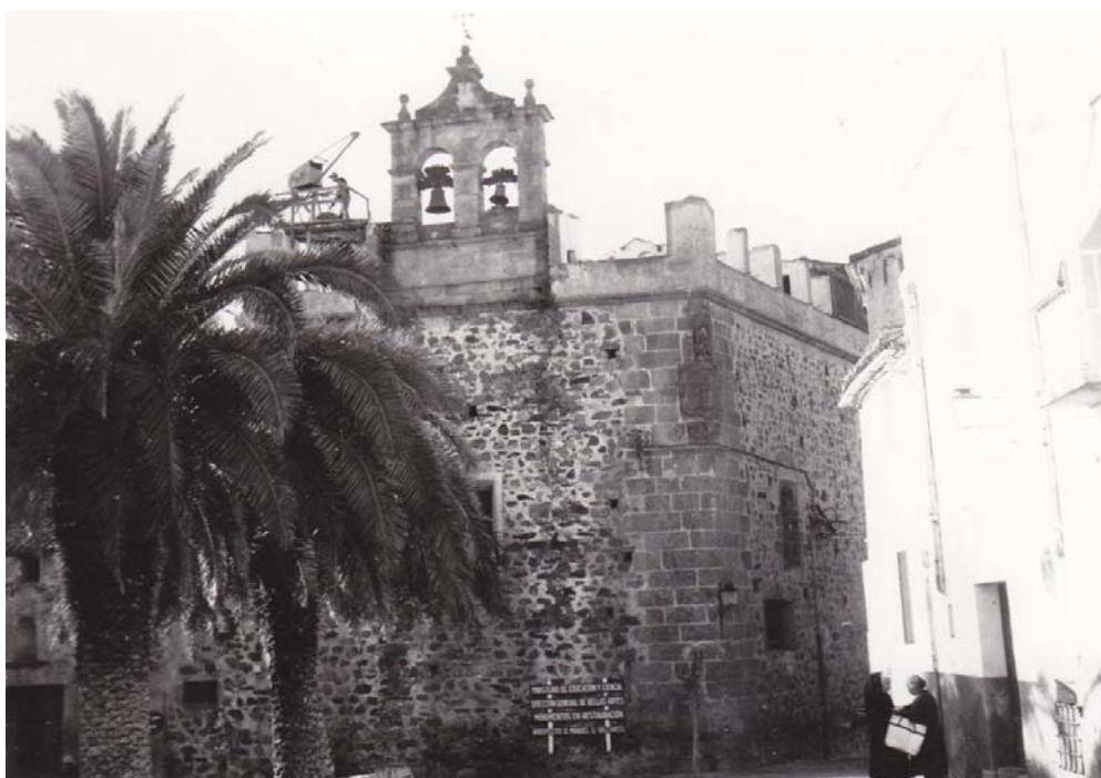
60. Obras de restauración de la cubierta del convento, en las que se rehizo el mirador de las monjas. Nótese la presencia del cartel anunciador de las obras: 'Ministerio de Educación y Ciencia. Dirección General de Bellas Artes, Monumentos en restauración. Arquitecto: J. Manuel G. Valcárcel' (AHMC).
