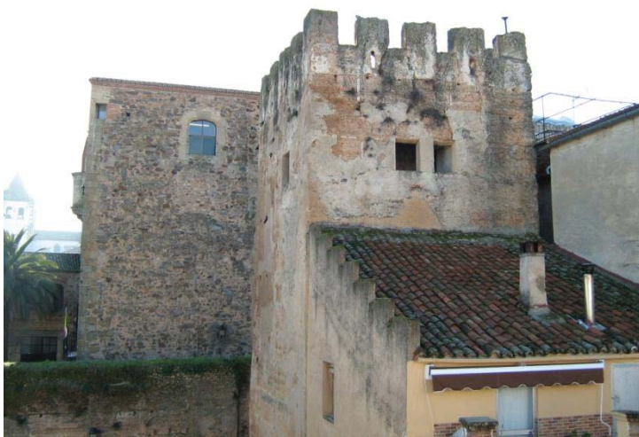
190. Estado actual de la torre del Horno. La casa n° 3 de las Piñuelas embutía la torre en su lado Norte. La obra fue aprobada si bien en 1947 se procedió a su derribo para abrir una comunicación con el adarve (MJT).
