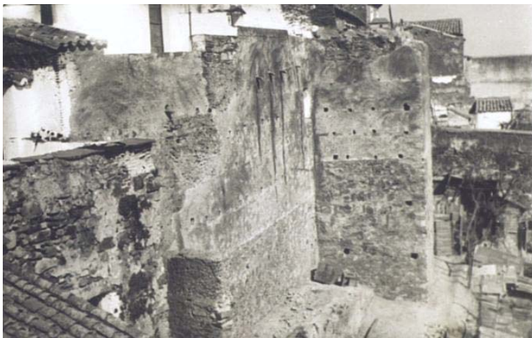
159. Se percibe el derrumbe de parte del remate superior en un sector que podría coincidir con la calle Caleros o el barrio de San Antonio (AGA).
