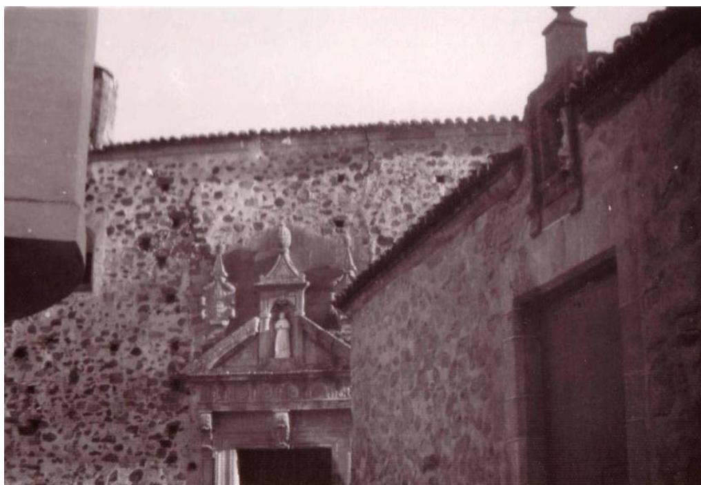
62. Portada de la iglesia restaurada, donde se aprecia el añadido de una escultura de San Francisco, por su factura reciente. La falta de especificaciones del proyecto de restauración de la portada impide conocer en qué consistió la obra en este sector (AHMC, Obras).
