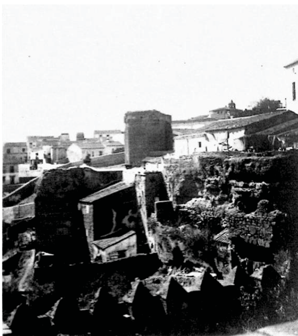
142. Fotografía de la huerta del Conde en esta época de reformas, en la que se percibe el mal estado de la muralla, la disgregación del tapial y las huertas existentes (AHMC).
