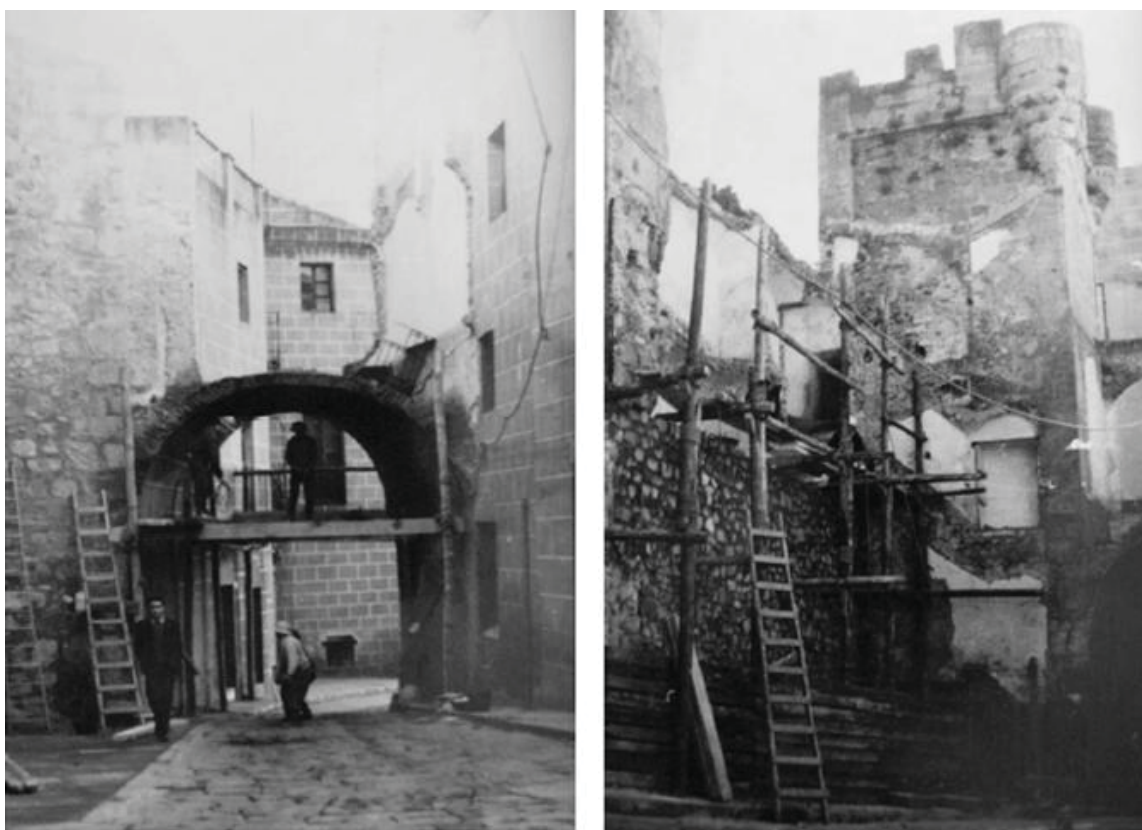
173. Proceso de desmonte del denominado 'arco del Corregidor'. A la derecha, fotografía tomada durante la ejecución de las obras, con los apeos del muro en primer plano y un evidente deteriorado estado de conservación (AGA).
