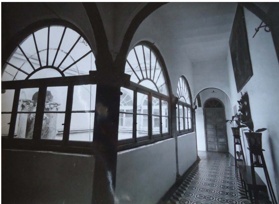
128. Galería superior del patio durante su uso como colegio. Se aprecia el acristalamiento de la zona (C. Carmelitas).
