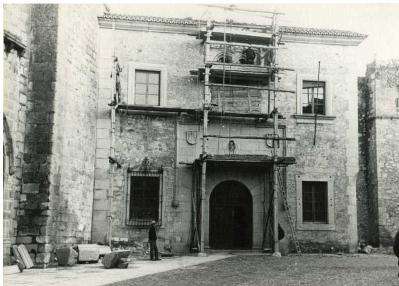
111. Imagen tomada durante las obras de sustitución de la fachada neogótica (AHMC).
