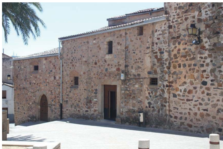
64. Fachada del convento de Santa Clara en la actualidad, que presenta una portada con un vano apuntado. Su configuración ha sido ligeramente modificada desde la foto de finales de 1969, cuando se encontraba cegado, probablemente por problemas de consolidación (MJT).
