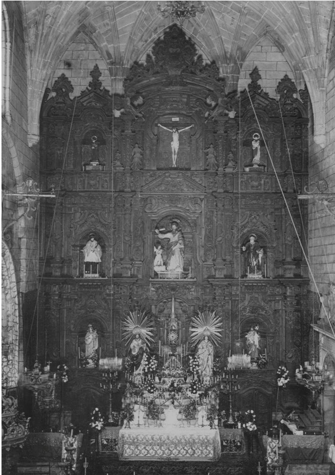
3. Imagen tomada a principios del siglo XX, en la que se distingue la decoración marmolizada del arco del lado del evangelio, así como el esgrafiado de sillería fingida que cubría los paramentos y bóvedas, eliminado en esta intervención (MC).
