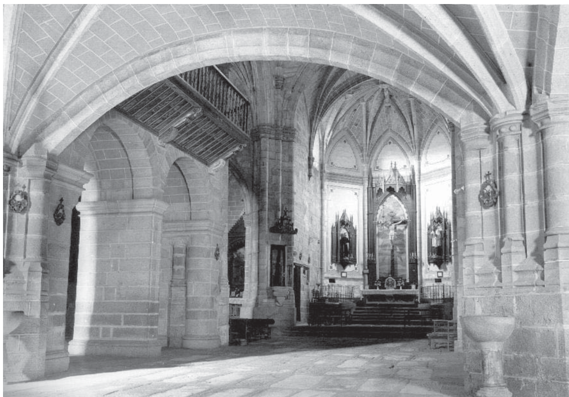
89. Interior de la iglesia conventual de San Francisco antes de las obras acometidas. Se aprecia la tribuna de madera del órgano que es eliminada en la intervención de 1972 (MC).
