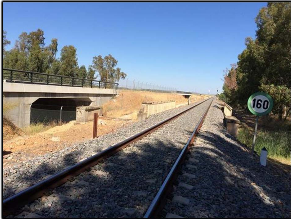
Fotografía 4. Preaviso de limitación de 160 km/h en la estructura sobre río Lácara. PK 470/000, cerca de Torremayor. (Badajoz).
