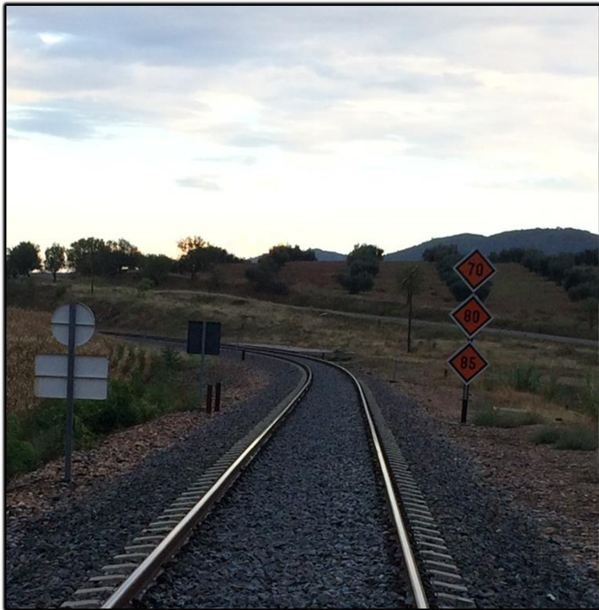
Fotografía 2. Limitación de velocidad de 70 km/h en Zarza de Alanje. (Badajoz). PK 436/600. Radio horizontal de 291 m.
