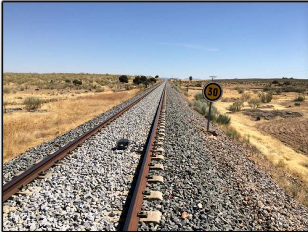
Fotografía 6. Aviso de limitación temporal de 30 km/h en la Vía Pecuaria Vereda de Zalamea. PK 370/200, cerca de Campanario (Badajoz)
