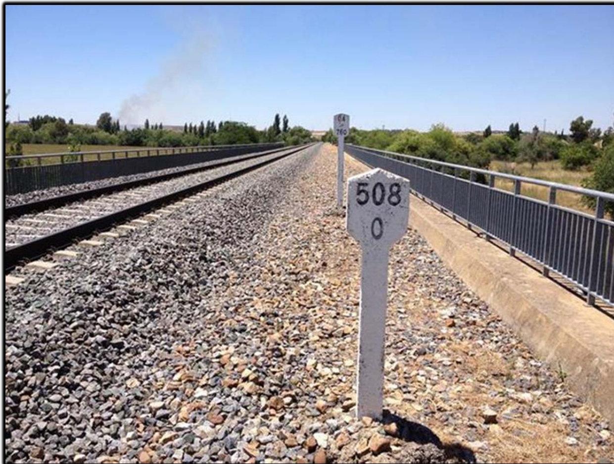
Fotografía 1. Señal de punto kilométrico en el puente sobre el río Gévora (Badajoz). Detrás se aprecia una señal informativa de la pendiente de la línea
