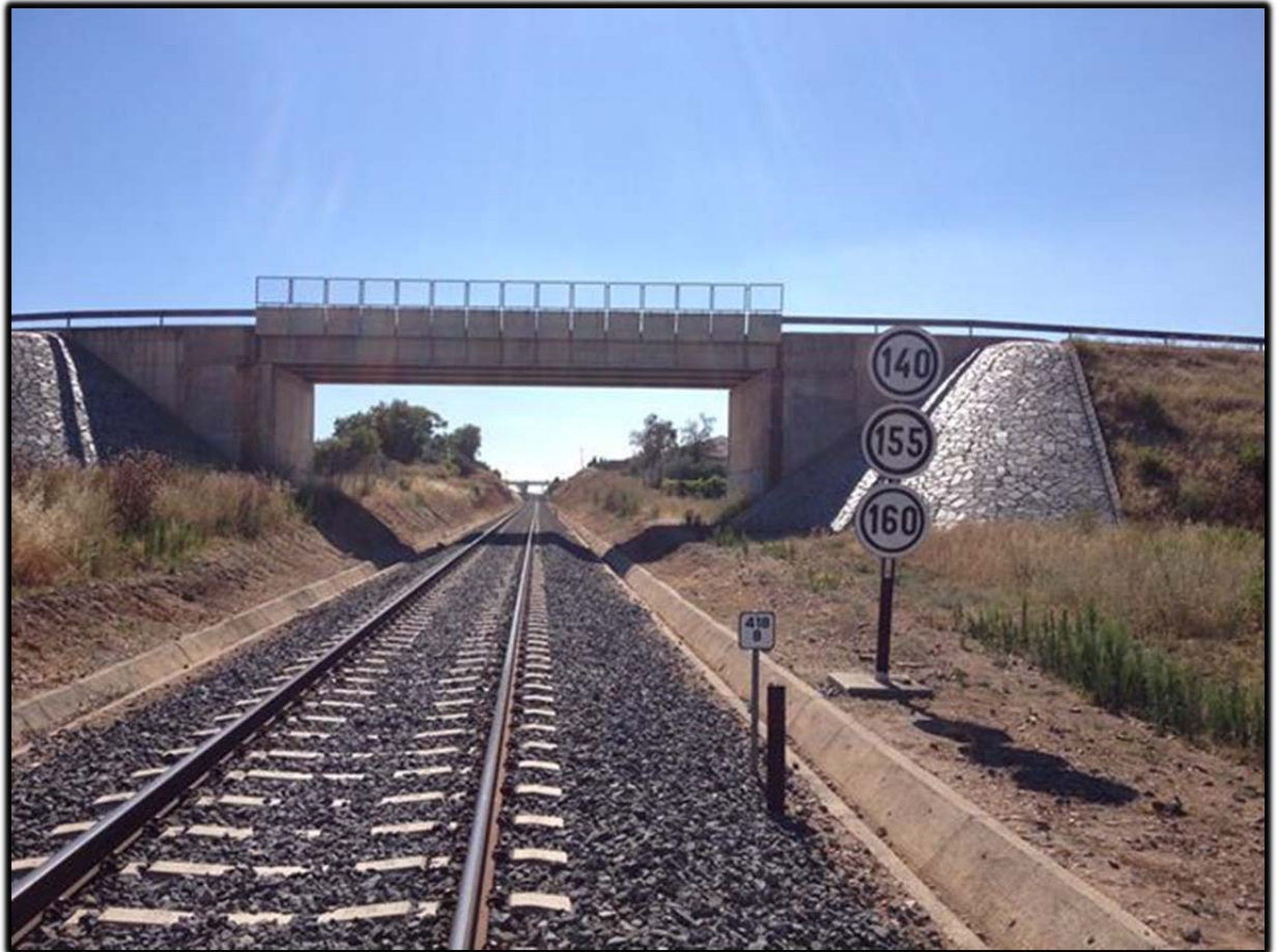
Fotografía 9. Estribos de hormigón “In situ” y derrames encachados de pizarra en la estructura en el PK 418/800 en la BA-142.
