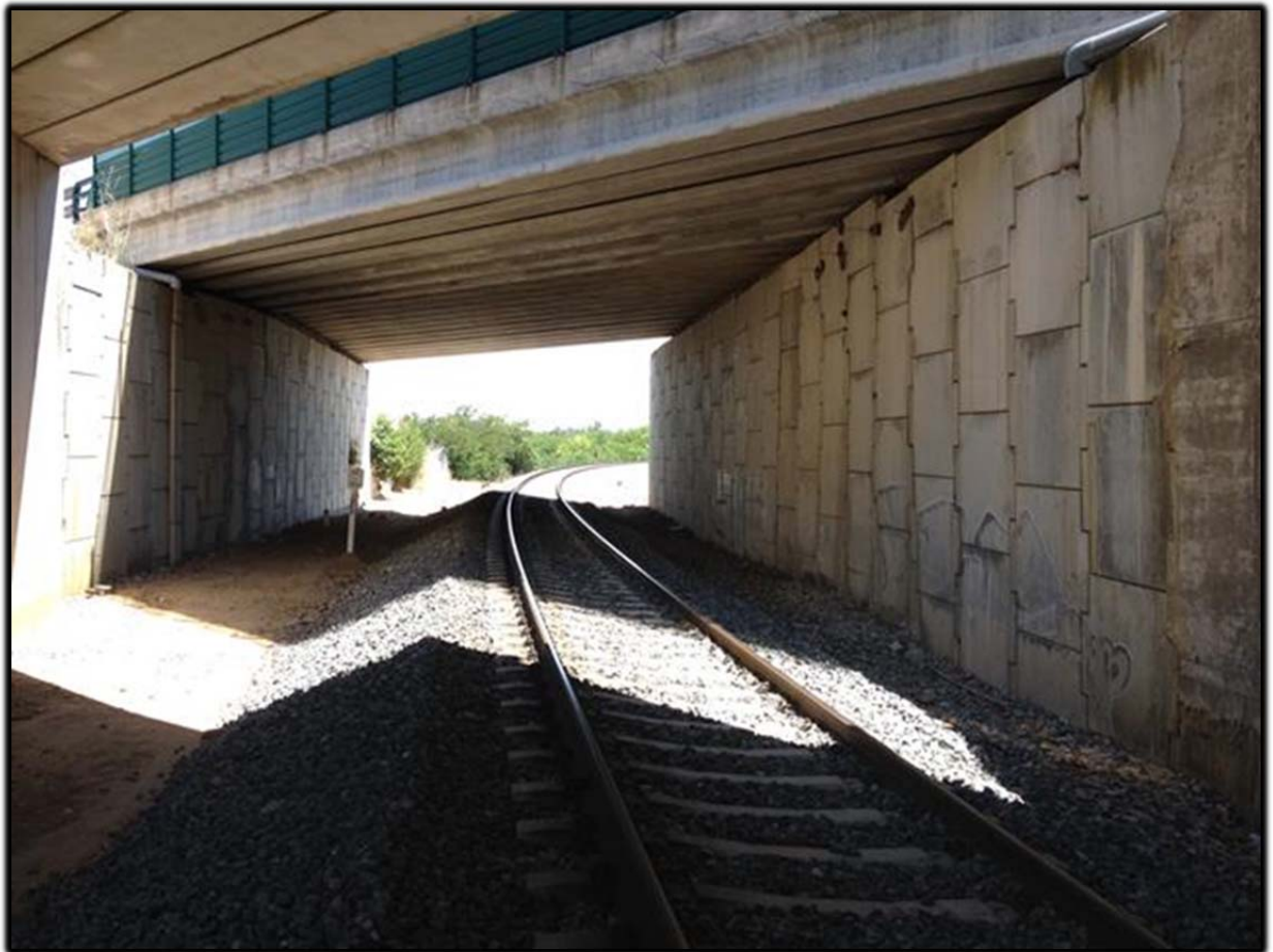
Fotografía 10. Estribos de tierra armada en la estructura de la EX-100, P.K: 508/600. Badajoz
