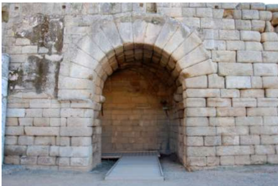
Figura 7: Puerta de acceso a la orchestra .
