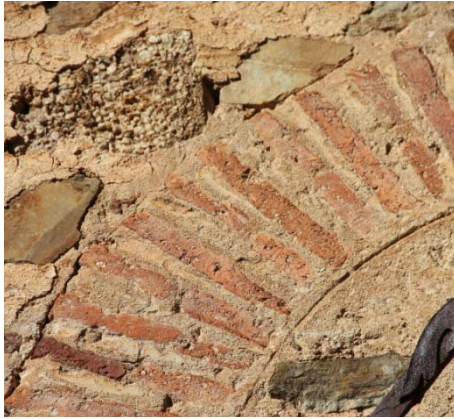
Figura 14: Detalle fábrica de ladrillo
