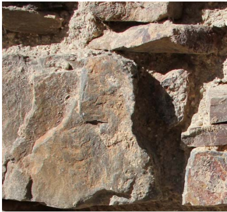
Figura 19: Detalle mampuesto cuarcítico
