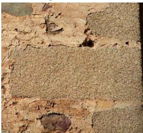
Figura 24: Detalle sillar de granito
