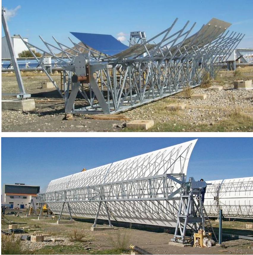
Figura 1 – Fotografías del colector EUROTrough. Fuente: National Renewable Energy Laboratory
