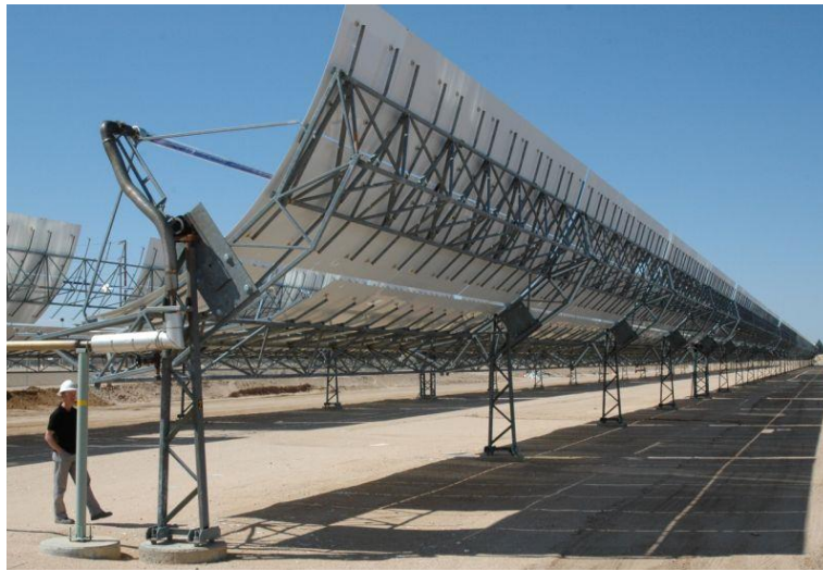
Figura 5 – Colectores tipo LS-3. Fuente: National Renewable Energy Laboratory
