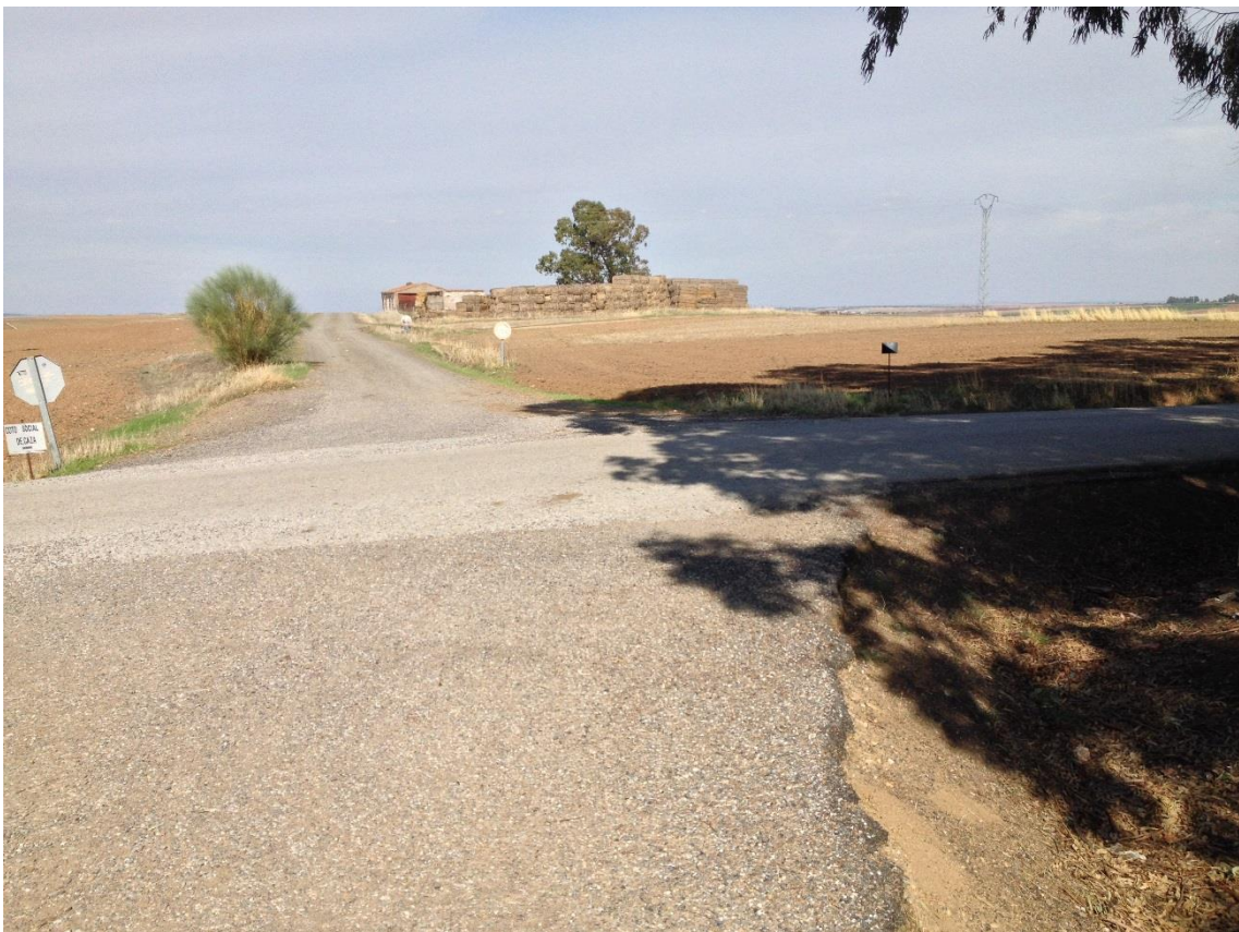
Fotografía 11 – Detalle de la intersección de la carretera del embalse con el camino agrícola
