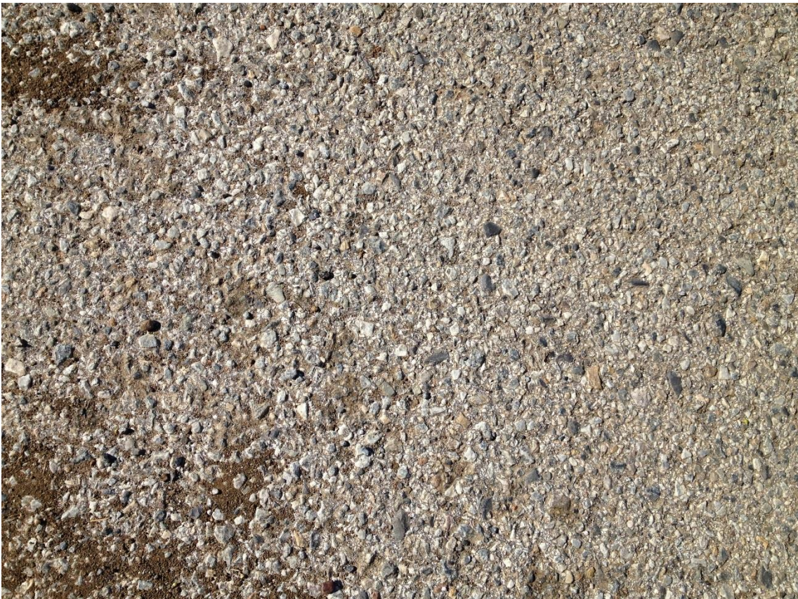
Fotografía 13 – Detalle del firme de la carretera del embalse
