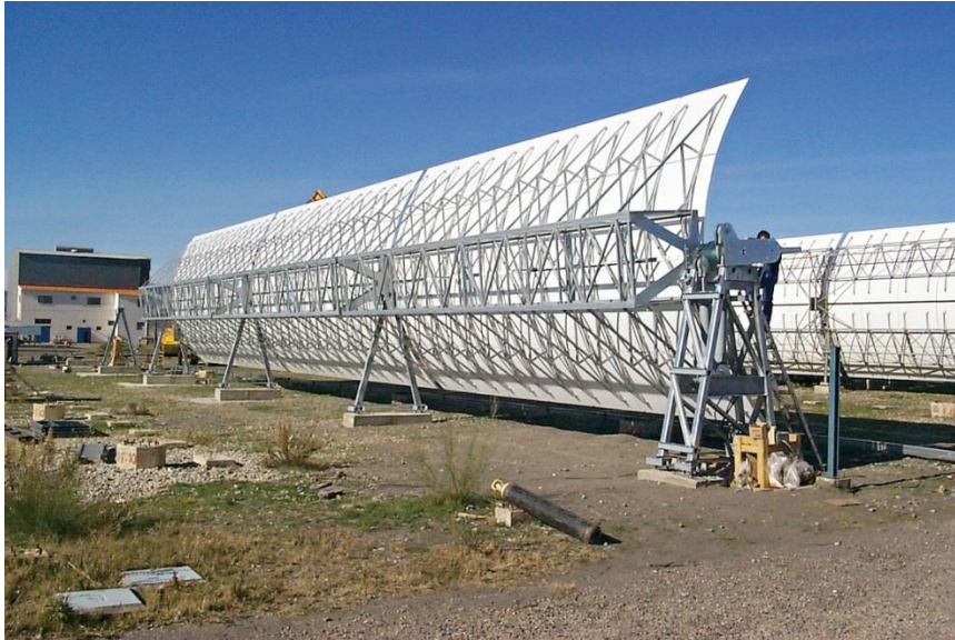
Figura 4 – Colectores tipo EURO Trough. Fuente: bine.info
