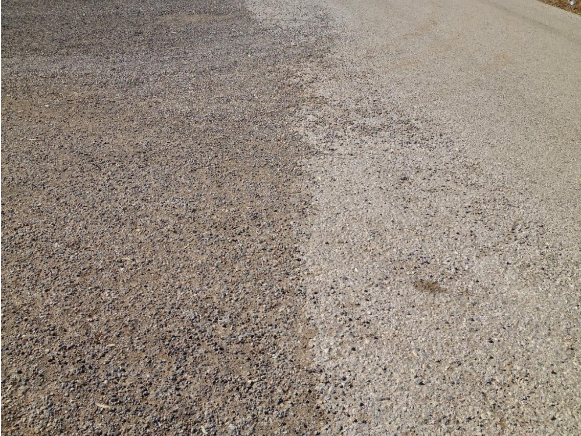
Fotografía 12 – Detalle del cambio de firme a gravilla en la intersección
