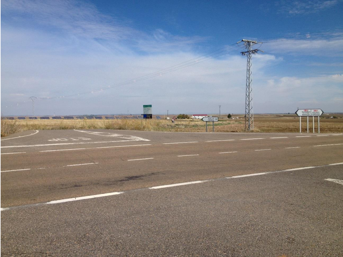
Fotografía 1 – Intersección del camino al embalse con la N-432
