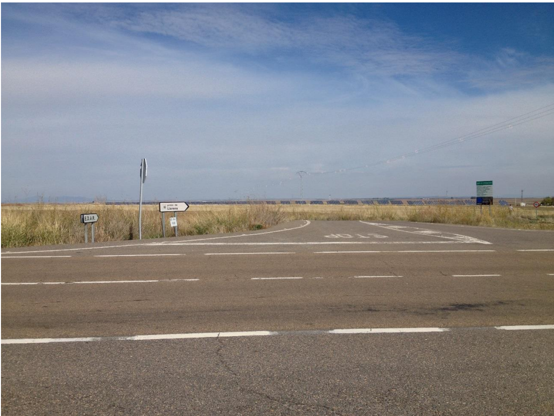
Fotografía 2 – Intersección del camino al embalse con la N-432
