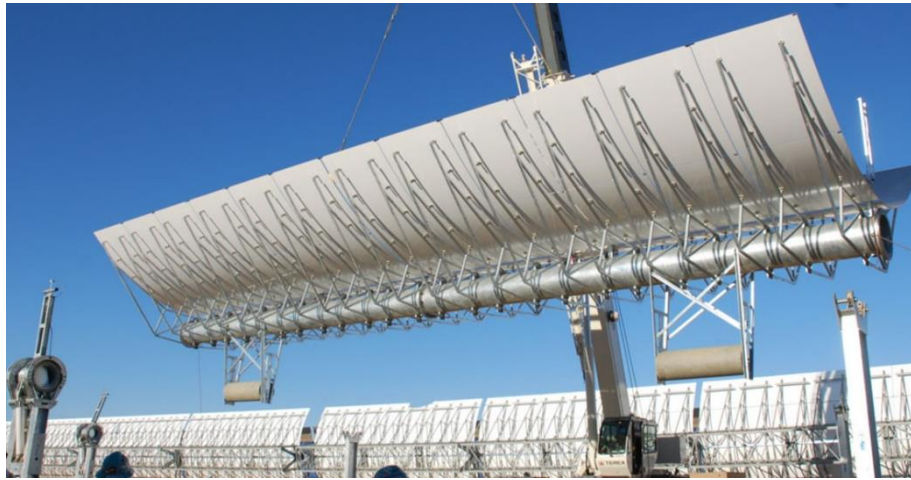
Figura 2 – Colector HELIOtrough en el momento de su colocación. Fuente: Heliotrough.com
