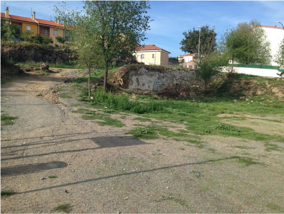
Fotografía 18. Muro de contención en explanada de arena III.
