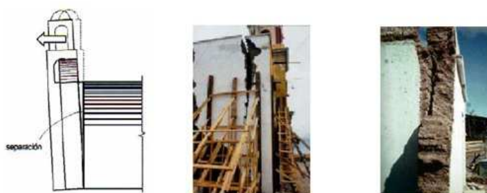
Figura 98. Fallo por separación producido por fuerzas de inercia perpendiculares al plano del muro.
