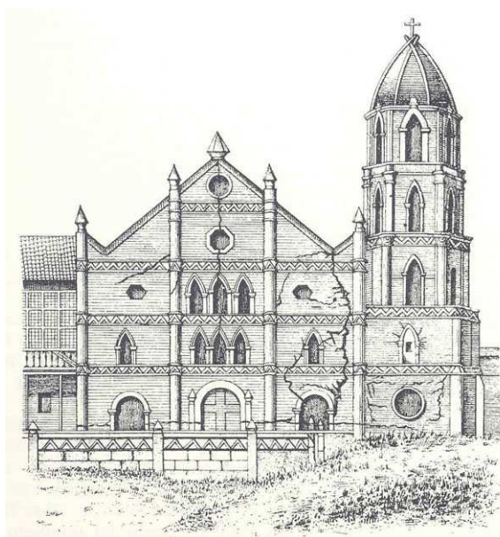
Figura 171. Efectos del terremoto de 1880 en la Iglesia de San Jacinto en Pangasinan (Filipinas). (Martínez, 2010).
