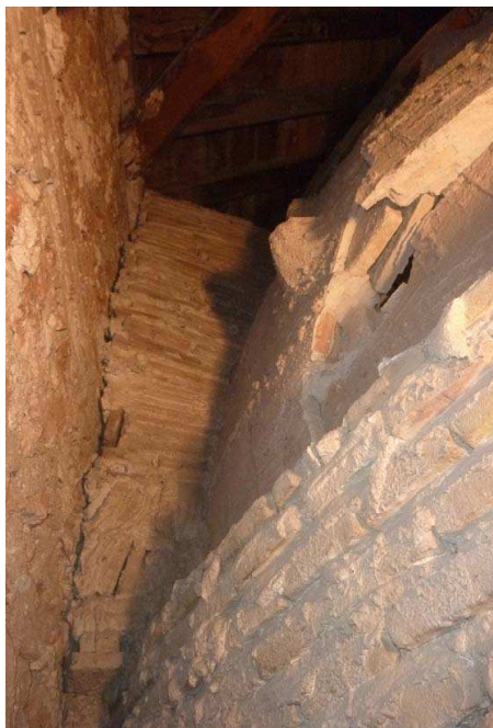
Figura 336. Por el trasdós se observa el arranque sobre el tambor, el contrarresto del diafragma y la rotura y desplazamiento de la cúpula. Foto del autor.
