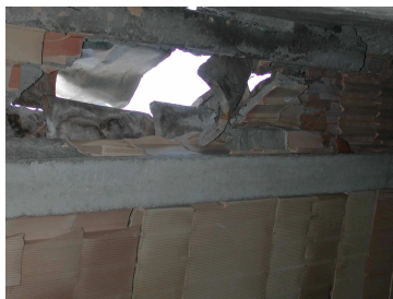
Figura 47. Detalle de la nueva cubierta. (Lagomarsino et al., 2004).
