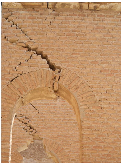
Figura 215. Arcos en la iglesia de Santiago. Foto del autor.
