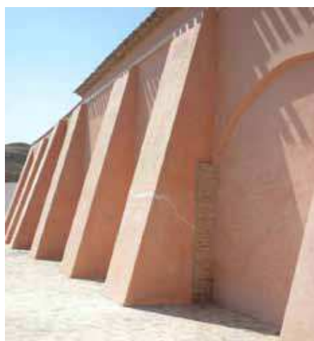
Figura 137. Contrafuertes de la ermita de San Roque de Lorca.
