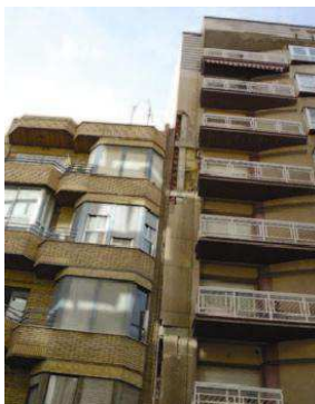
Figura 21. Efectos del golpeteo observados en la visita post-terremoto a Lorca (Carreño et al., 2012).
