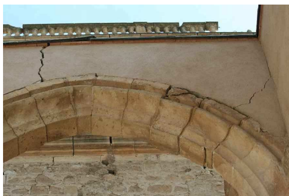
Figura 225. Detalle de arco en la iglesia de Santa María.
