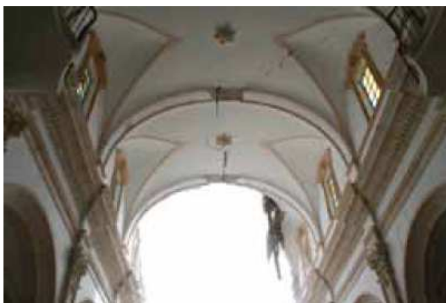
Figura 293. Iglesia de Santiago. Bóveda nave central.
