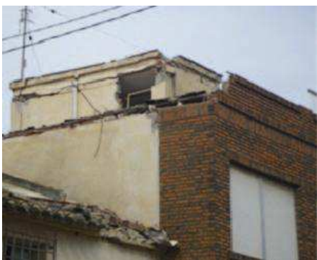
Figura 9. Elementos no estructurales no anclados a la estructura (Carreño et al., 2012).
