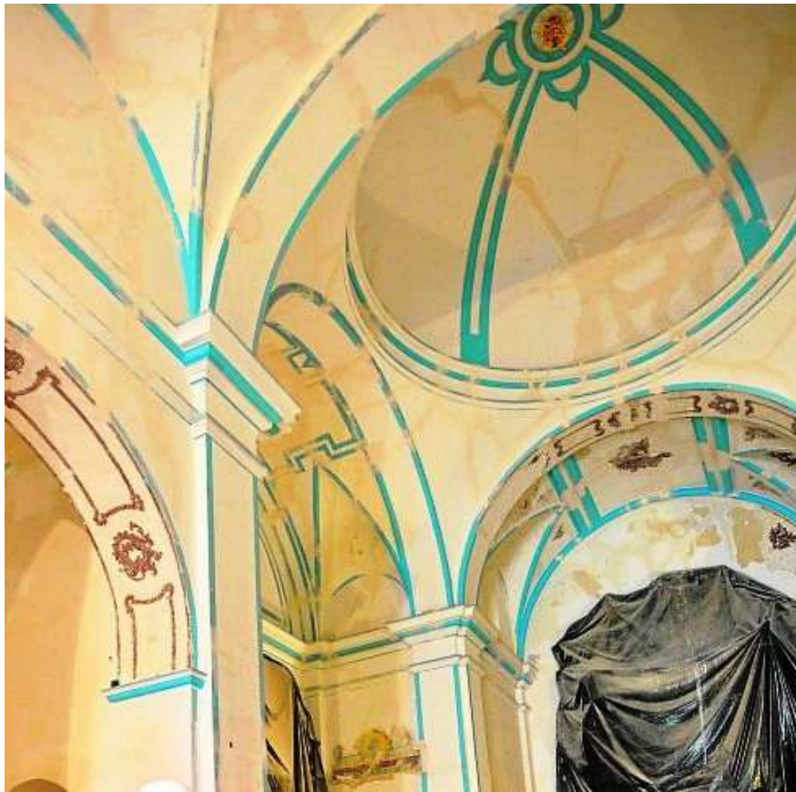
Figura 327. Cúpula de la iglesia de San diego de Lorca.
