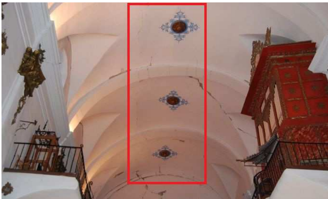
Figura 289. Nave central de la iglesia de San Francisco de Lorca.
