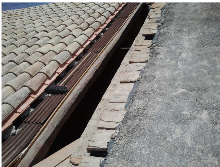
Figura 67. A la derecha se observa el estado previo de la cubierta de la nave central. Foto del autor.
