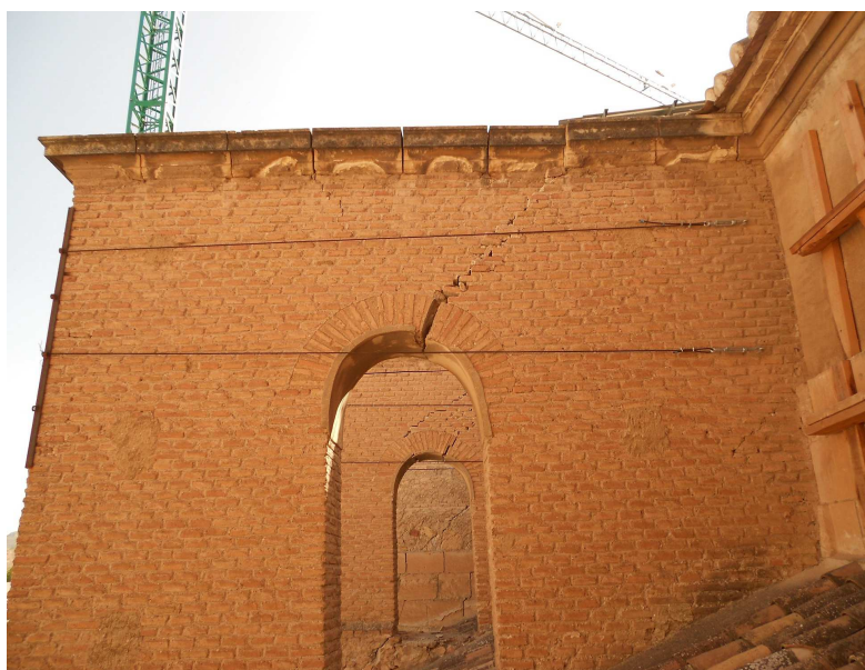
Figura 216. Arcos en la iglesia de Santiago. Foto del autor.
