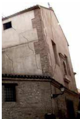
fachada acceso frontal nave
