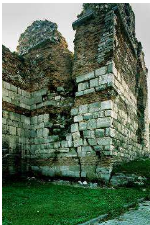
Figura 34. Torre no reconstruida. (Langenbach, 2004).
