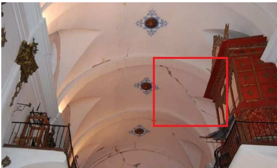
Figura 306. Nave central de la iglesia de San Francisco de Lorca
