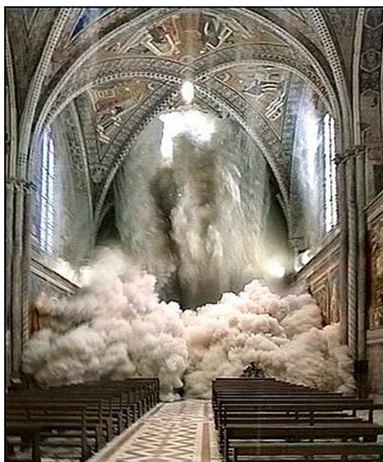
Figura 42. Captura del video del derrumbe de la bóveda del crucero.
