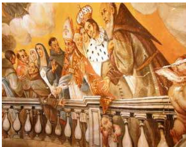
Figura 333. Iglesia Virgen de las Huertas. Fractura horizontal de la cúpula de dos roscas con pérdida de las pinturas murales en la zona fracturada.
