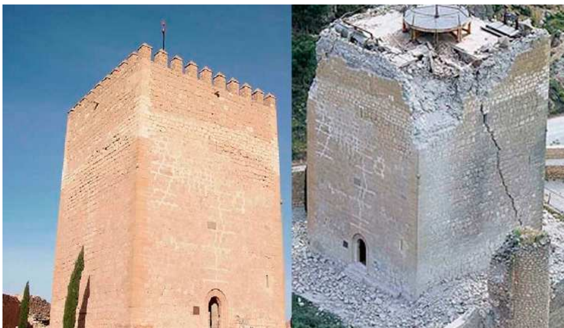
Figura 76. Daños en la Torre del Espolón.
