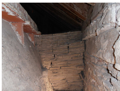
Figura 71. Trasdós de la Cúpula. Foto del autor
