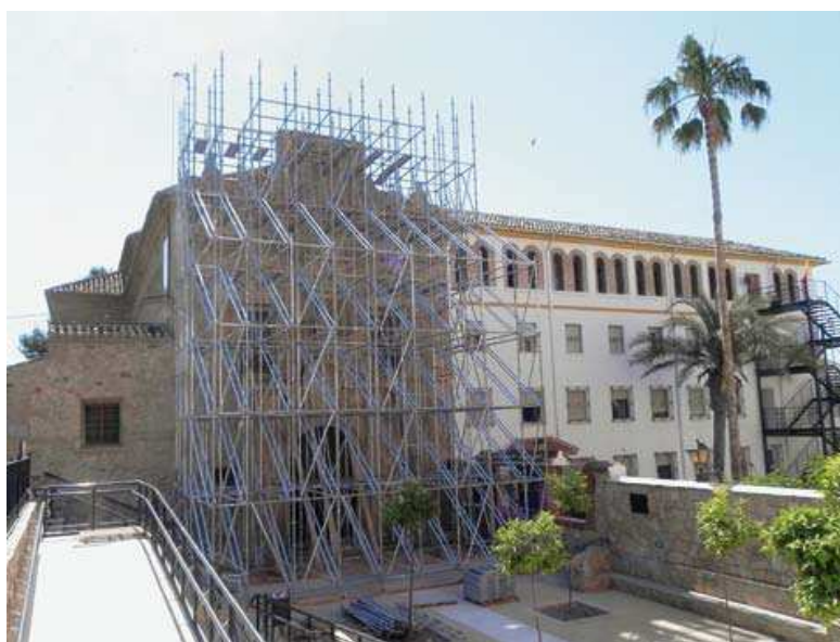
Figura 106. Andamio metálico para apear la fachada de la Iglesia de San Diego y evitar su vuelco.
