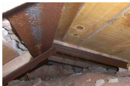
Figura 73. Apoyo de las vigas de acero (Peñalver, 2013).
