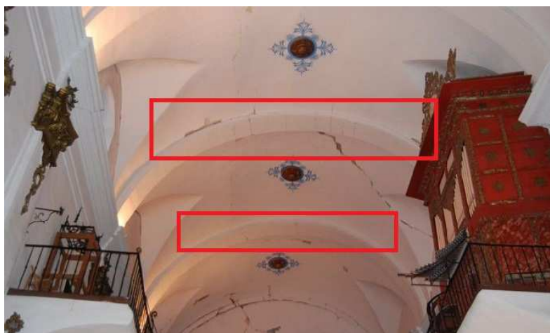
Figura 270. Nave central de la iglesia de San Francisco de Lorca
