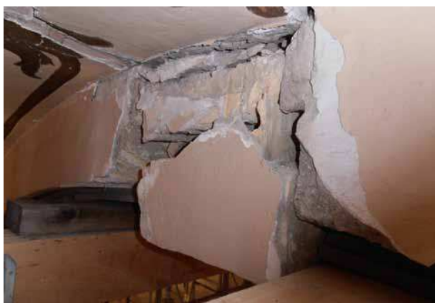
Figura 254. Detalle de la clave rota.
