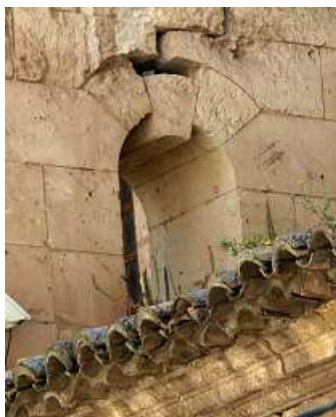
Figura 255. Descenso de clave en arco en La Colegiata, Lorca
