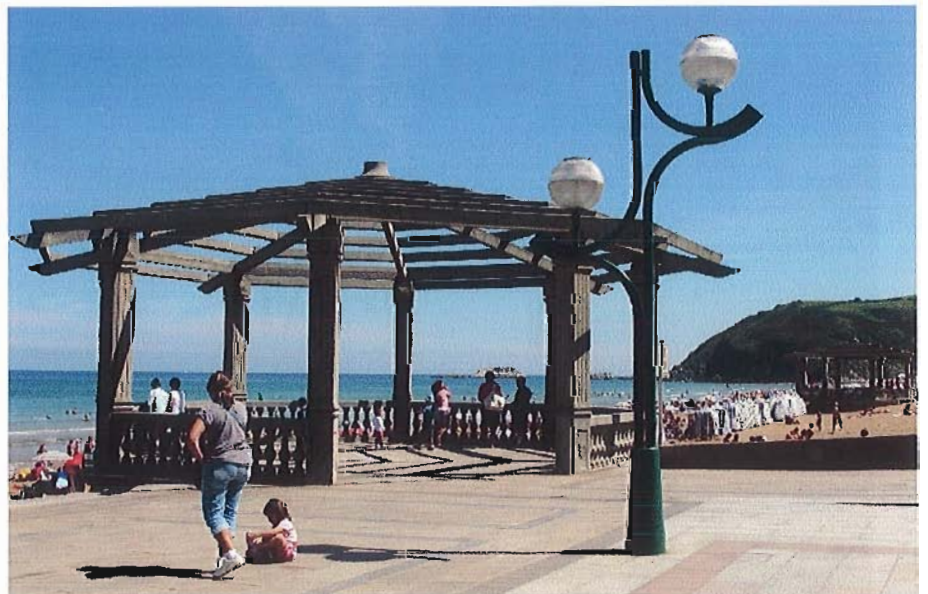
9.87.-9.90. Elementos de micro-arquitectura y de mobiliario urbano en el paseo marítimo de Zarautz (fotografías de 2011).
