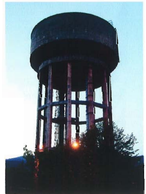
8.39. Depósito conservado en la zona de Etxebarri, junto a la Ría de Bilbao.
