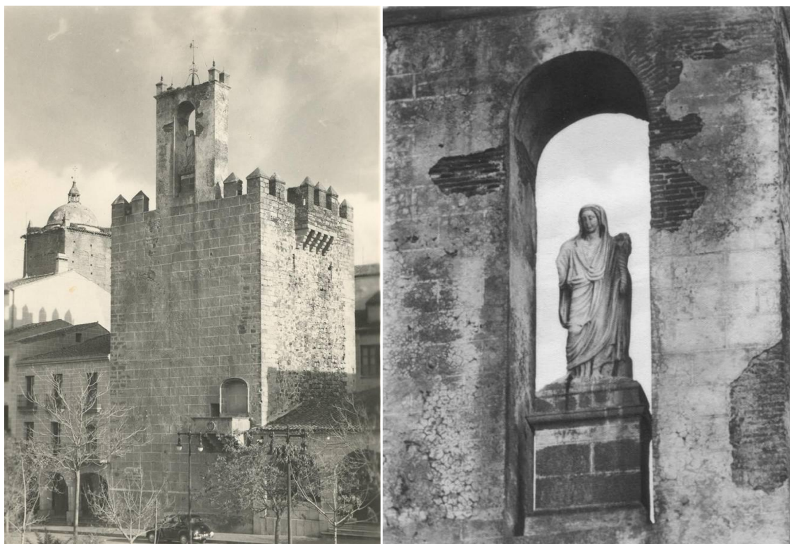
Figuras 396 y 397. Torre albarrana de Bujaco de Cáceres, con la escultura del togado instalada sobre podio y bajo templete, a mediados del siglo XX (AHPCC).
