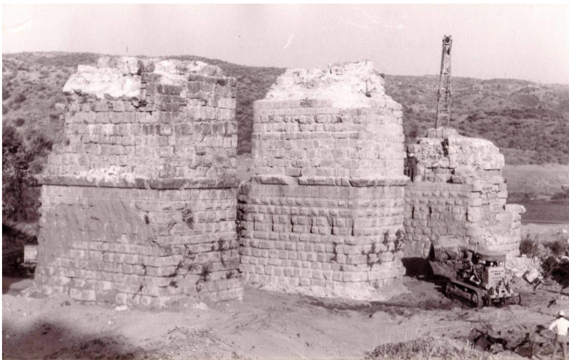
Figuras 394 y 395. Desmontaje y traslado del puente de Alcántara a su nueva ubicación (AHMCC).
