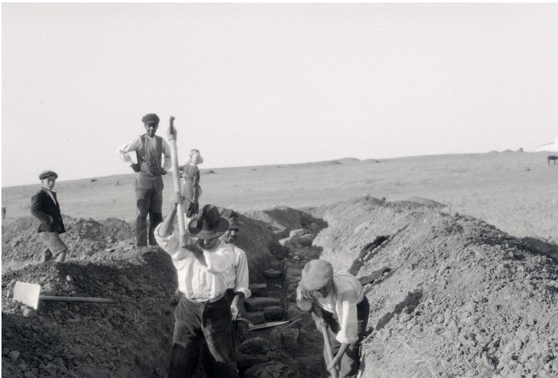
Figuras 370 y 371. Fotografías tomadas durante los trabajos de excavación de 1930 (colección Tomás Martín Gil).
