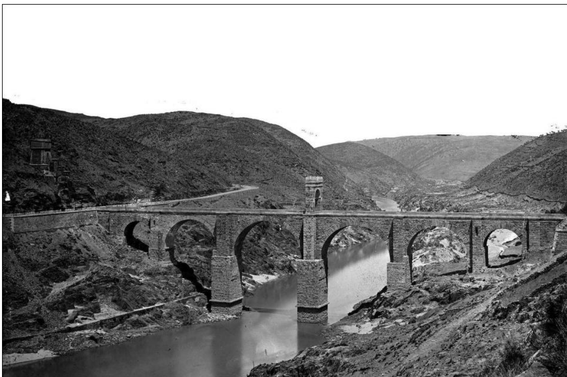
Figura 126. Panorámica del puente de Alcántara tomada por Laurent a mediados del siglo XIX. El viaducto alcanza el siglo XX sin ninguna modificación (MCC).
