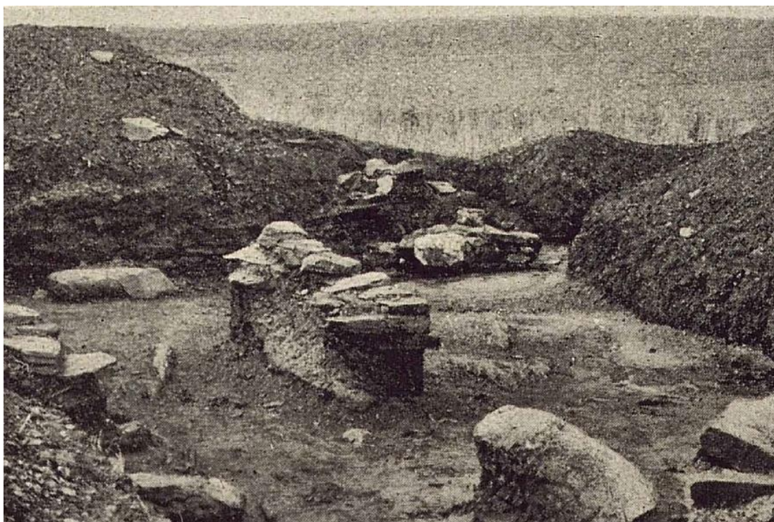
Figuras 365 y 366. Estado de las excavaciones del praetorium y la porta praetoria durante la campaña de 1928. Fotografías de Tomás Martín Gil (Blázquez Marcos, 1929).
