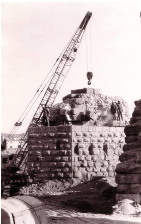
Figuras 394 y 395. Desmontaje y traslado del puente de Alcántara a su nueva ubicación (AHMCC).
