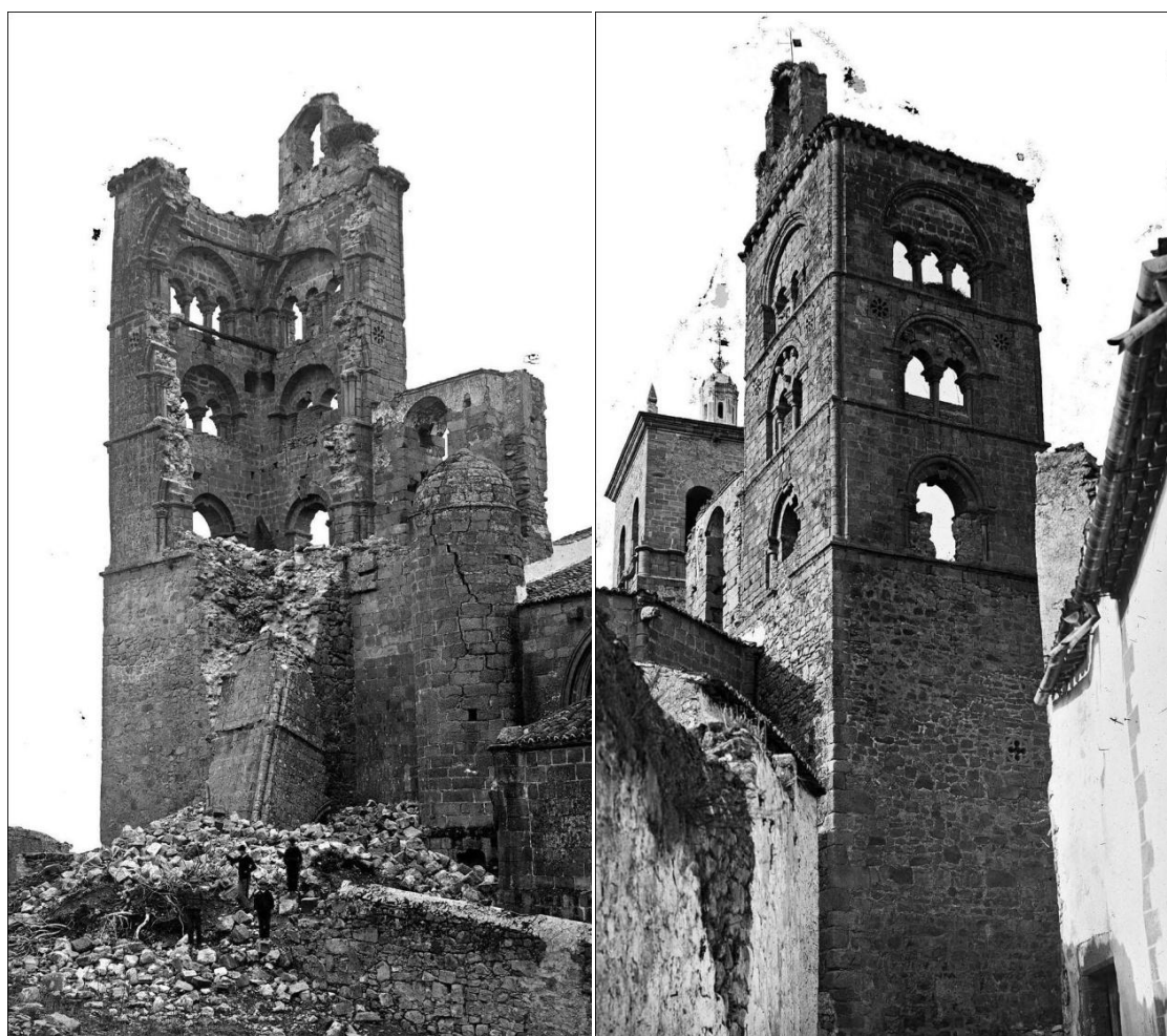
Figuras 19 y 20. Fotografías de la torre, tomadas por Laurent en 1870 (Fototeca del Instituto del Patrimonio Cultural de España).
