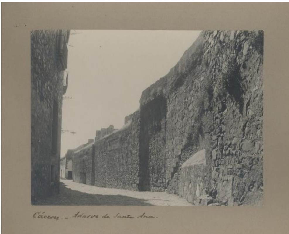
Figuras 129 y 130. Fotografías del socavón provocado en la muralla por el temporal y del interior del perímetro de la cerca, tomadas por Julián Perate (MCC).
