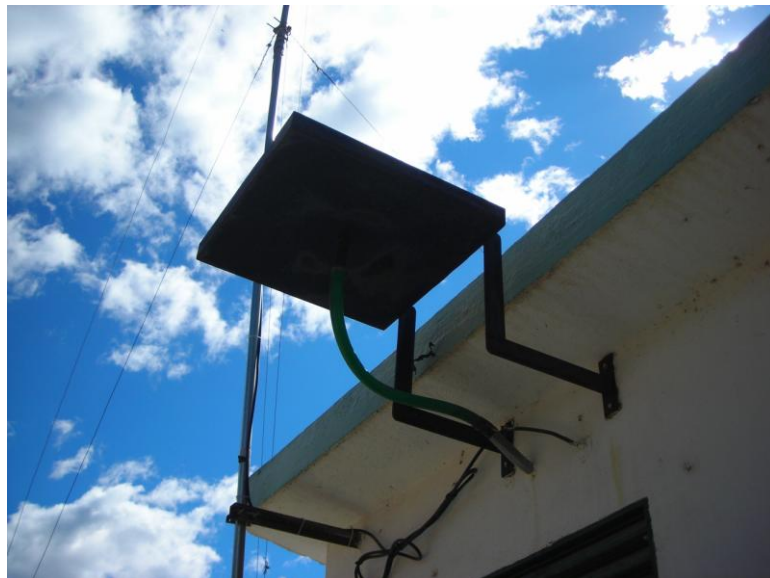
Figura 2.6. Vista del colector de agua de lluvia ubicado en el entorno de la CNA (Presa Arrocampo).
