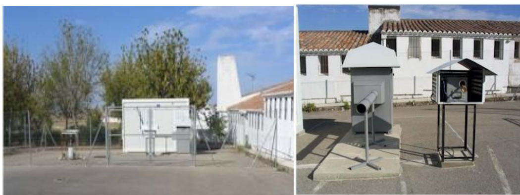
Figura. 3.1. Vistas del recinto acotado y de la estación de alto flujo ASS-500C.
