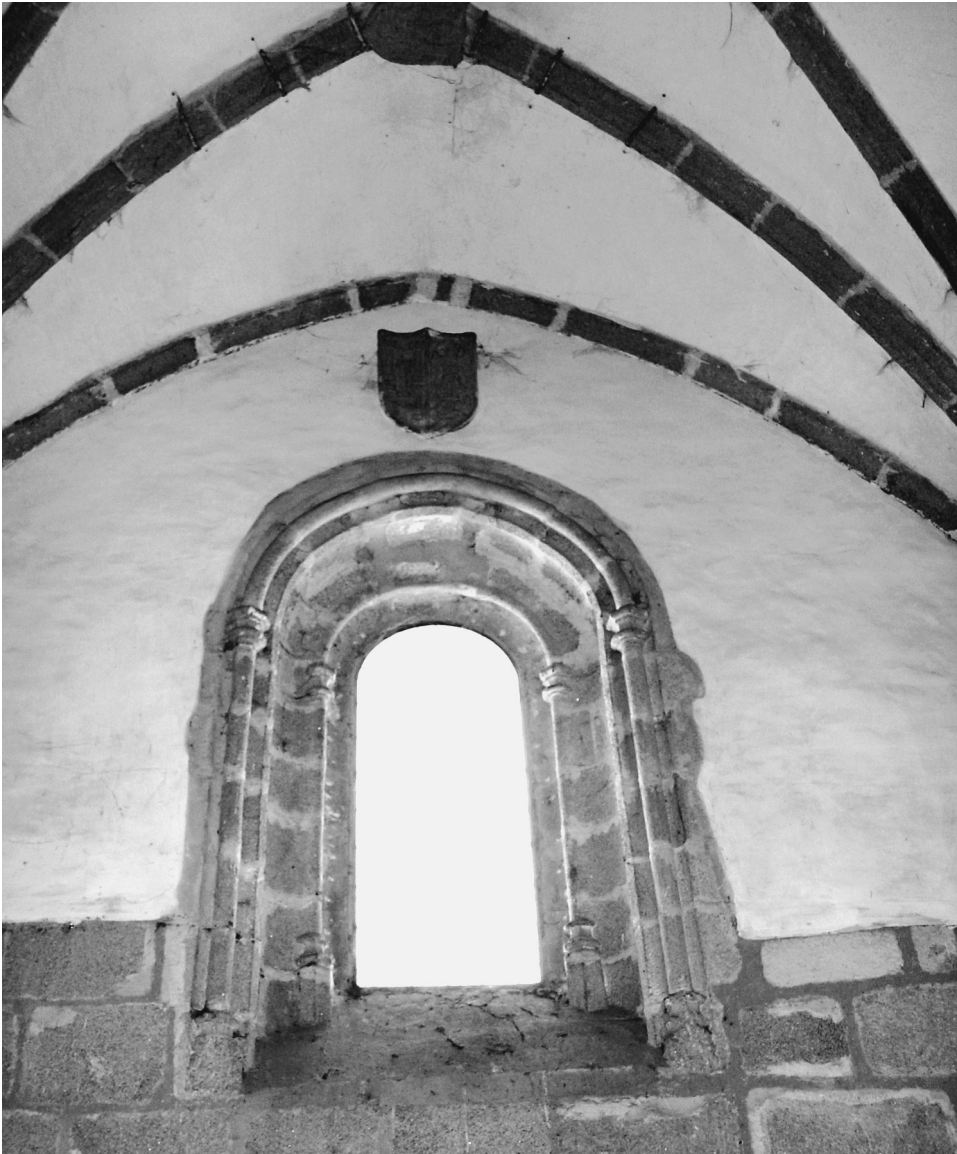
FIG. 4. Ventana del testero de la capilla.
