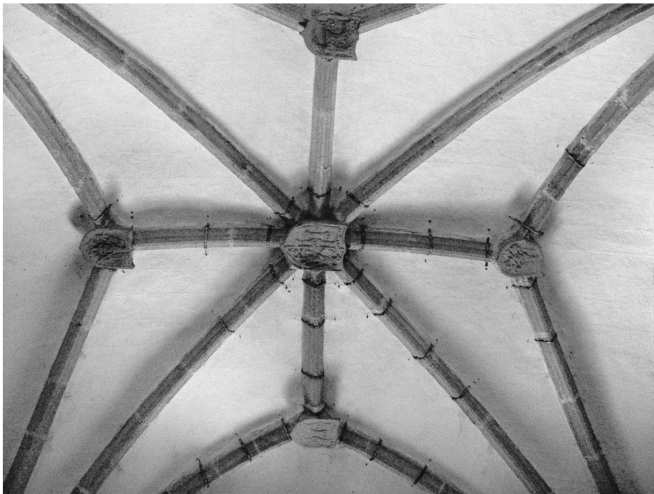
FIG. 3. Crucerías de la capilla del Mariscal.
