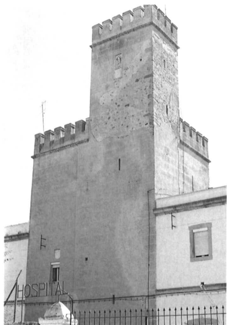
FIG. 8. Torres del Hospital Militar
