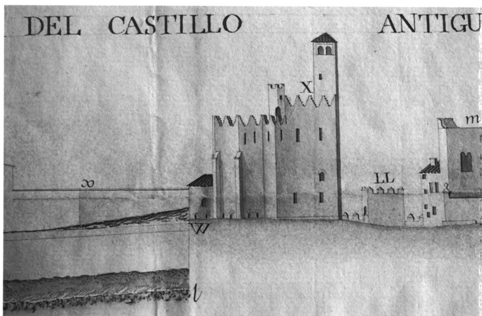
FIG. 4. Vista de las cabeceras y torres de la iglesia de Santa María. Particular del plano de José de Gabriel, 1803. X: Santa María. LL: puerta del Capitol, m: torre de la casa del Conde de los Acevedos
