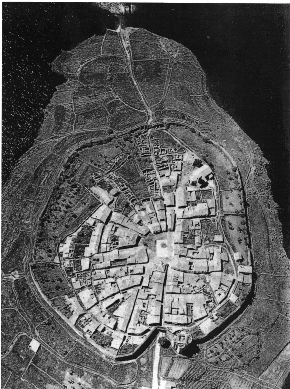
Plan de rehabilitación de la Villa de Granadilla (Cáceres). Vista aérea antes de la rehabilitación, año 1966 (J. A. Espejel, arquitecto).
