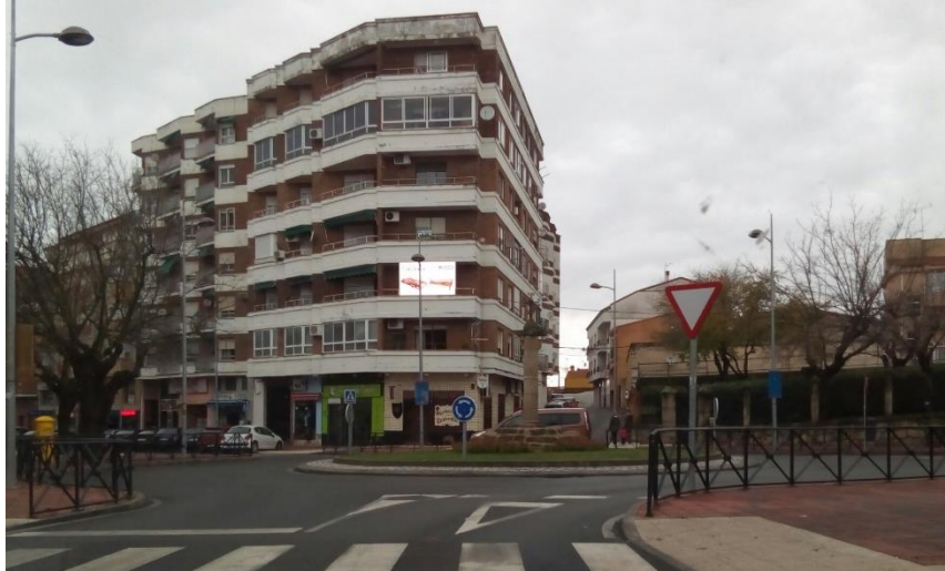
Figura 22. Glorieta Cruz del Rollo (intersección calle Antonio Concha con la calle Puerto del Escudo).
