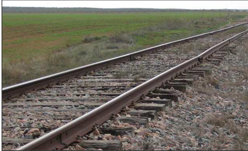
Ilustración 2. Vía del ferrocarril extremeño con carriles de 1885 Fuente:(Consejería de Medio Ambiente y Rural, 2016)
