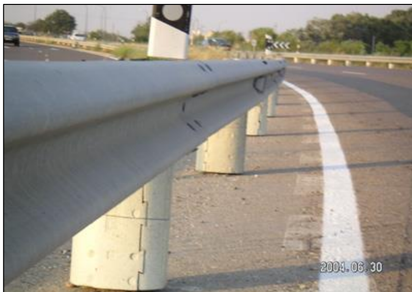
Fig. 6: Protección de los postes en H.
