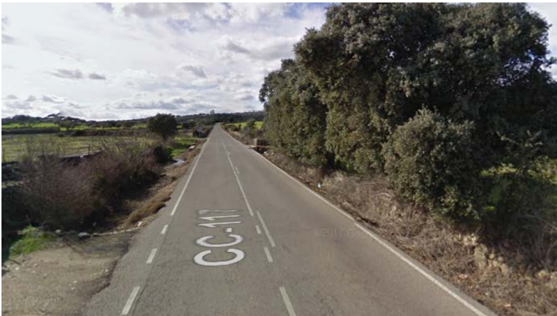
Imagen 5.Estado de la vegetación cercana a la calzada.
