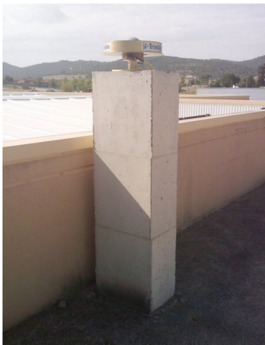
Figura 18: Estación GNSS de Cáceres en la Escuela Politécnica
