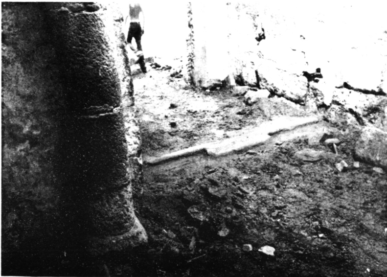
ALCUÉSCAR. Ermita de Santa Lucía. Paso de nave a crucero, donde se aprecian rozas en los muros y en la losa del suelo para colocar cancelas.
