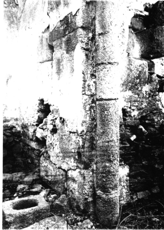
ALCUÉSCAR. Ermita de Santa Lucía. Lado S. del crucero y ábside lateral, donde se observa una columna y una roza en el muro para colocar un cancel.
