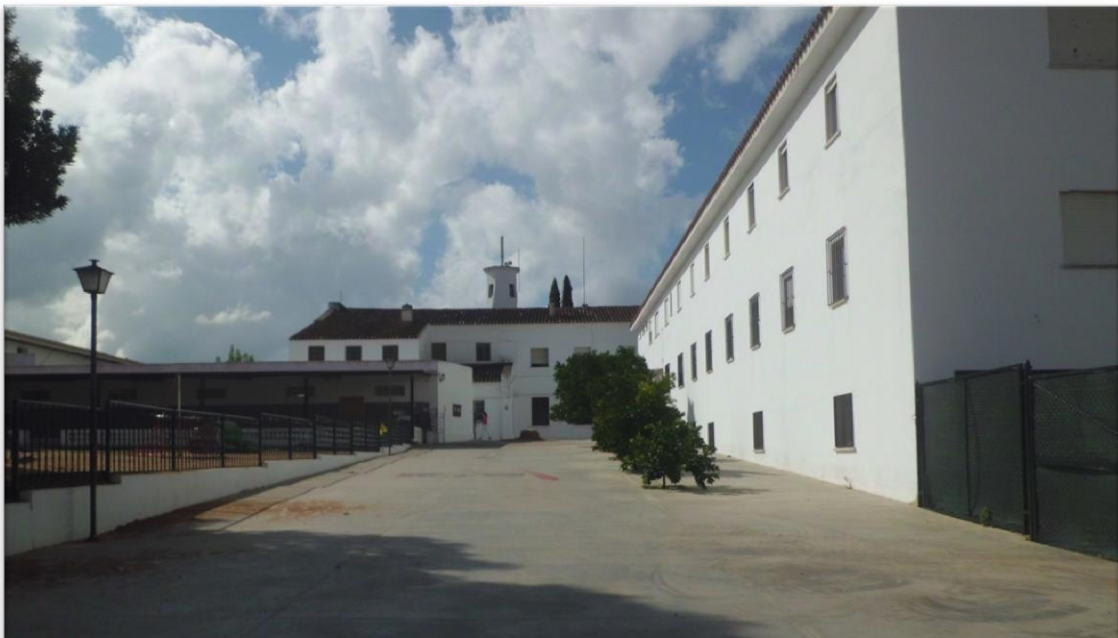
Fotografía actual del antiguo edificio de la escuela hogar, convertido hoy en módulo de Educación Infantil
