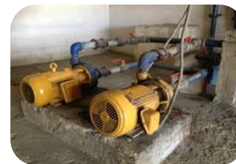
Procedimientos de mantenimiento de infraestructuras
