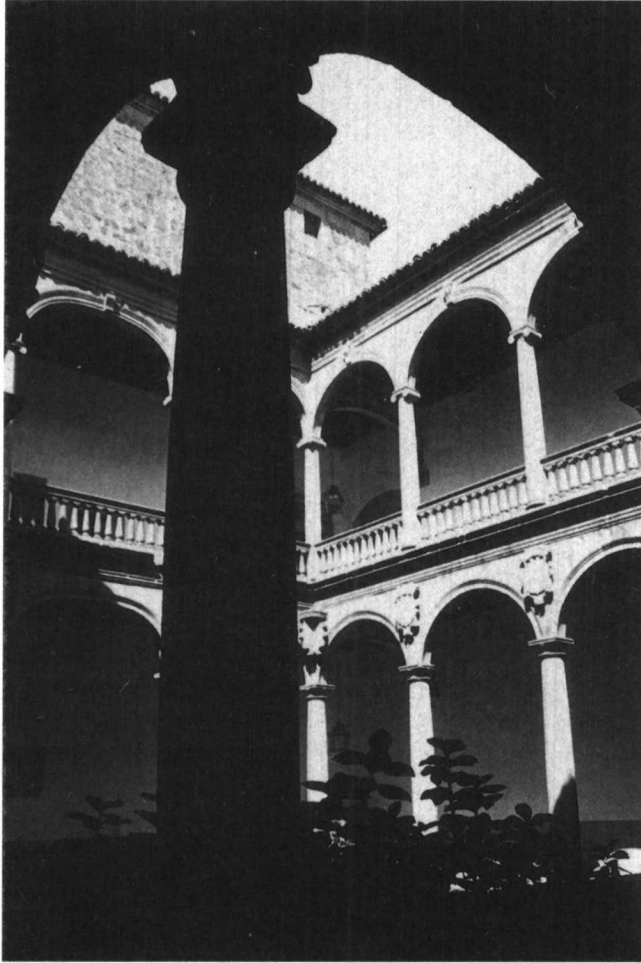
Plasencia. Patio del Palacio de Mirabel.
