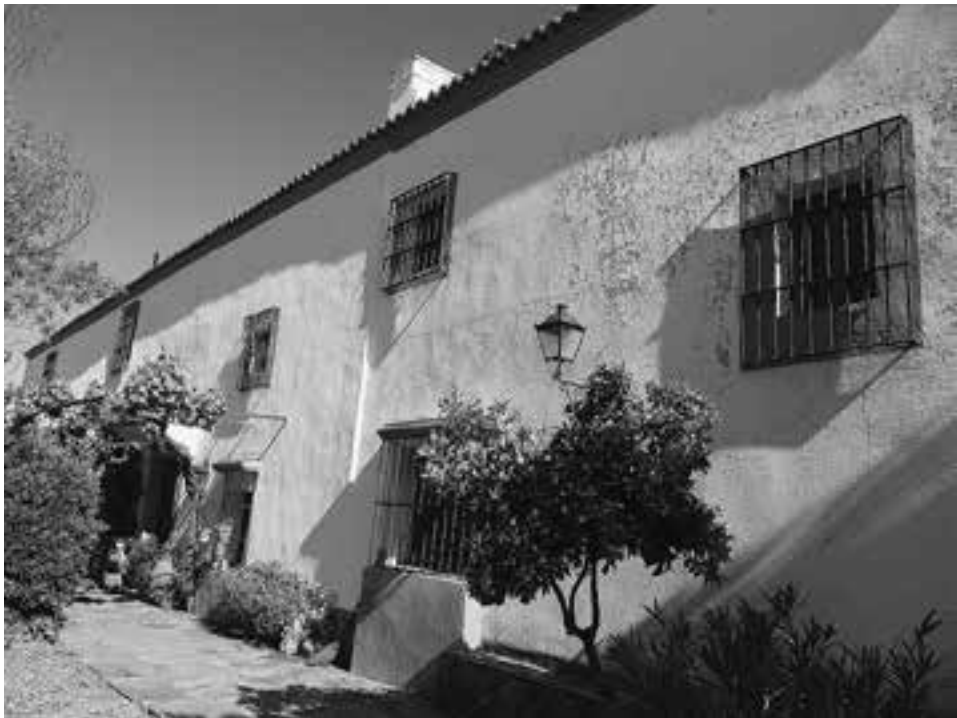
FIG. 7. Cortijo El Campo (Villar del Rey). Fachada principal.
