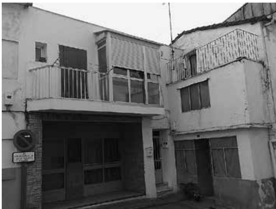
FIG. 9. Estado actual del que fuera Cine Lux de Malpartida de Plasencia. © Angélica García-Manso.
