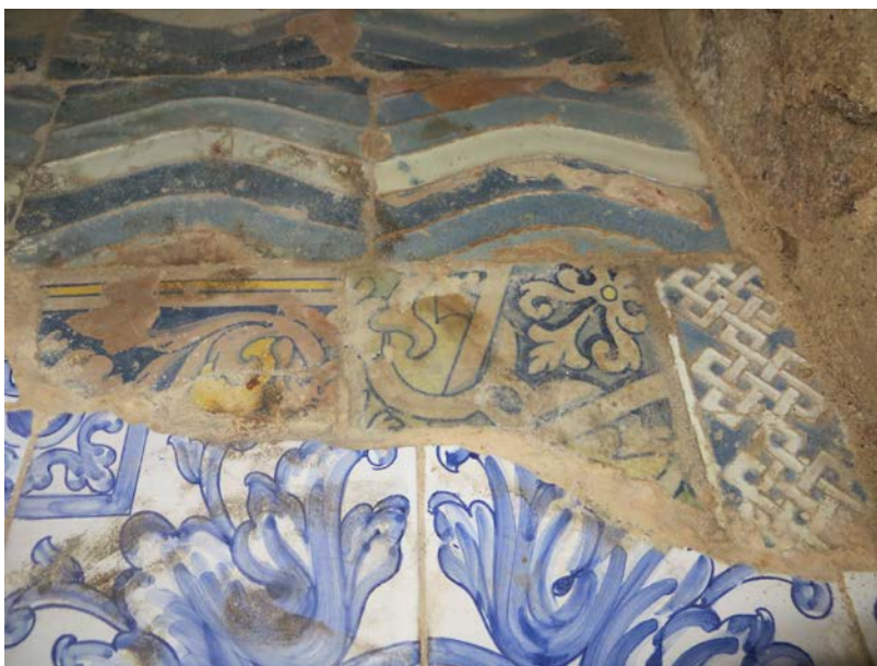
Fig. 140. Azulejos reutilizados en un vano de la sacristía del Convento de San Francisco.
