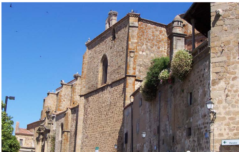
Fig. 208. Exterior de la iglesia del Convento de San Vicente adosada al Palacio de Mirabel.
