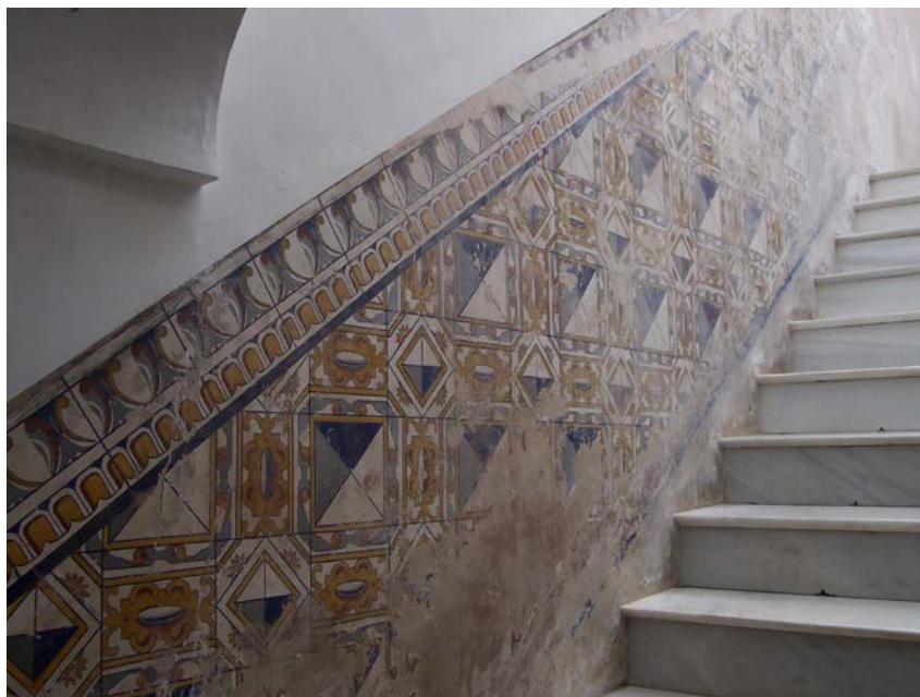
Fig. 133. Trampantojo de un zócalo de azulejos en la antigua portería del Convento de San Benito de Alcántara.
