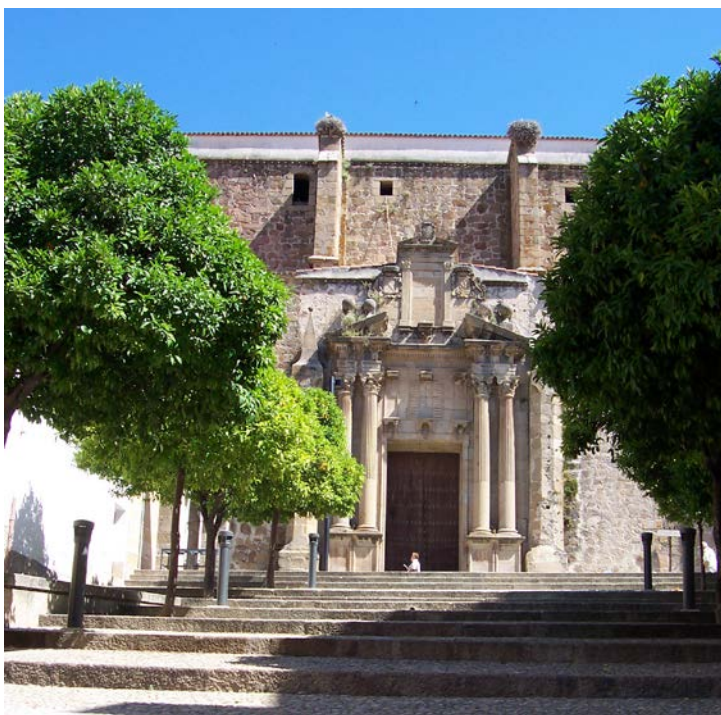
Fig. 209. Portada de la Epístola de la iglesia del Convento de San Vicente Ferrer.
