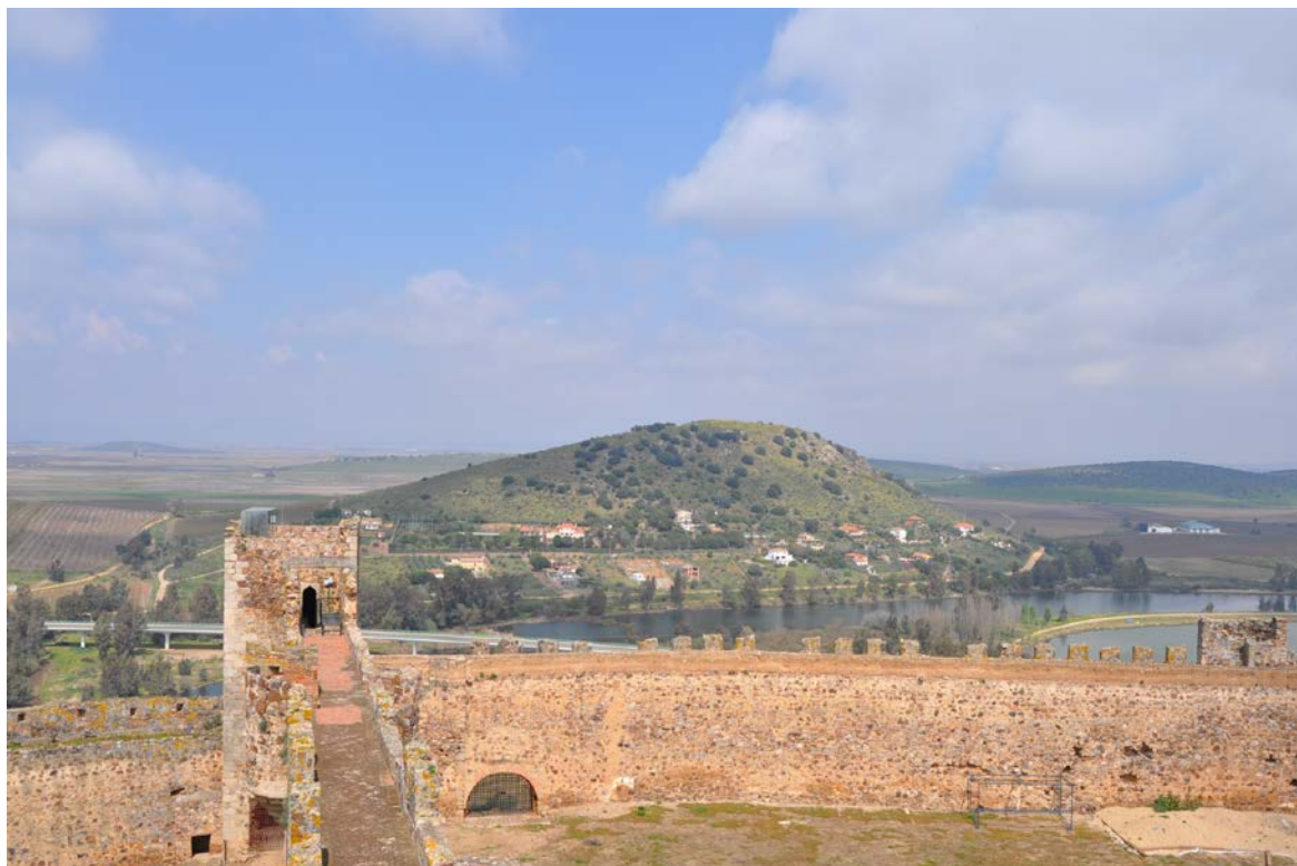
Fig. 37. Muro diafragma que divide el interior del castillo de Medellín.
