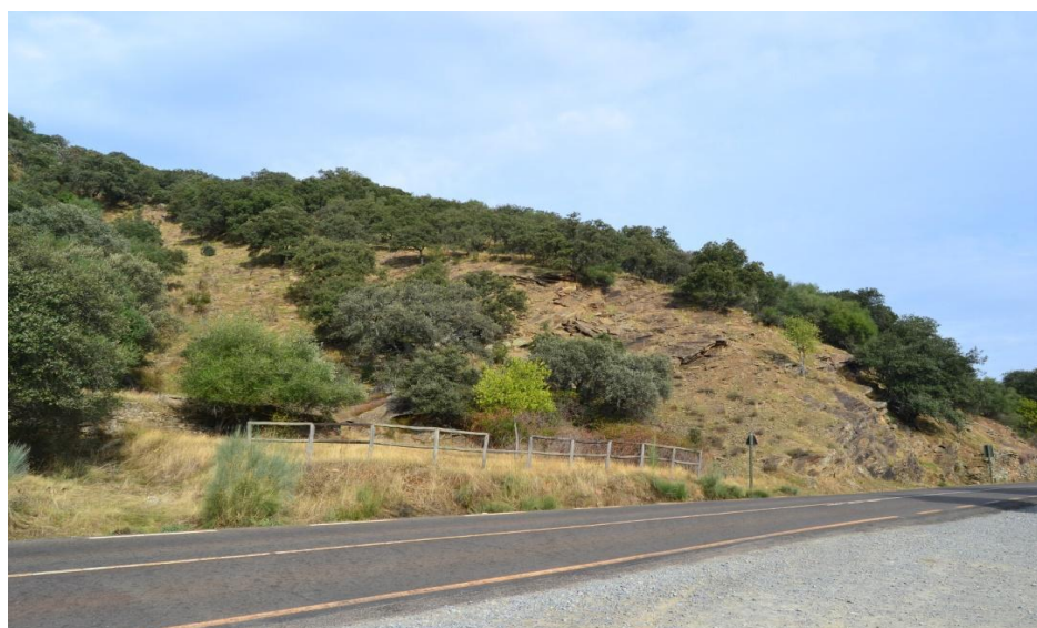
Figura 1: Panorámica del deslizamiento del Desfiladero. Fuente: propia. Año 2016.
