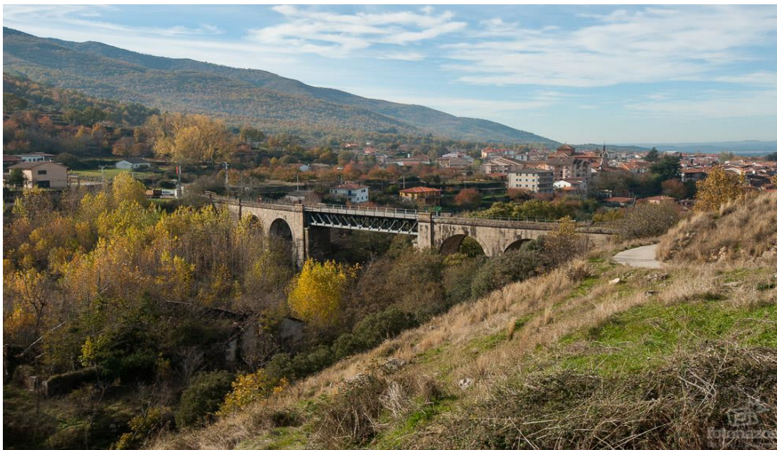
Imagen 2. “Puente de Hierro”. Fuente: https://www.fotonazos.es/2013/12/en-puente-de-hierro-de-hervas-resquicios-del-ferrocarril-en-el-valle-de-ambroz/
