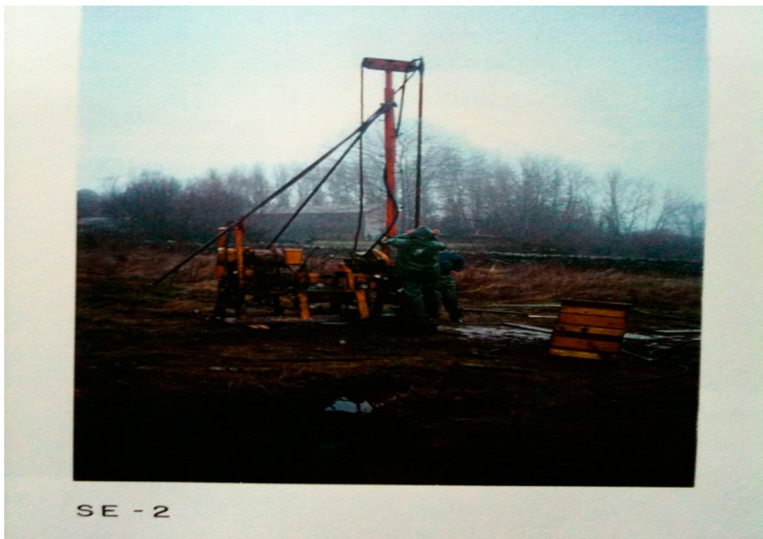
Imagen 8. Maquinaria empleada para realizar los sondeos.
